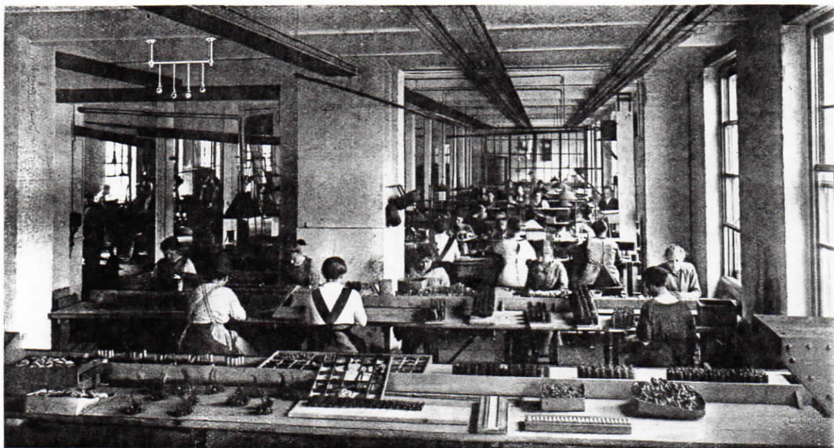
Abb. 6. Die Signalarmatur einer Ringsignalanlage in einer elektrotechnischen Fabrik. (Die Armatur ist an der Decke angebracht.)
