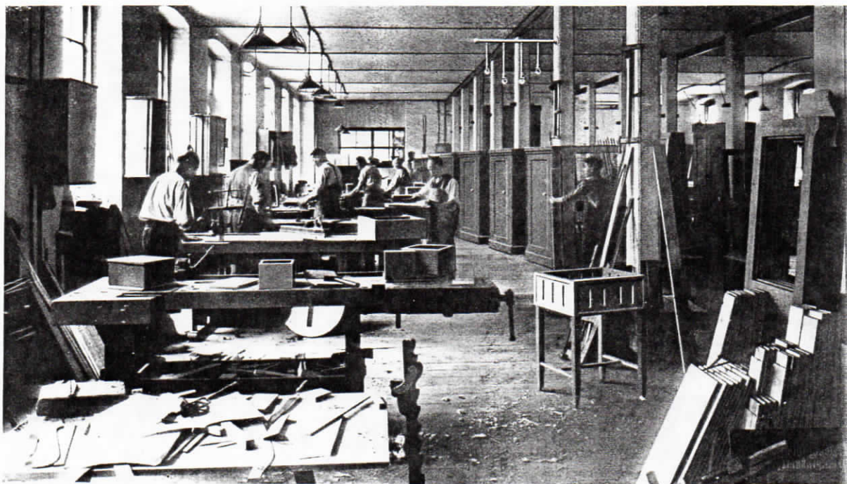
Abb. 7. Die Signalarmatur einer Ringsignalanlage in einer Holzbearbeitungsfabrik. (Die Armatur ist an einer Säule angebracht.)
