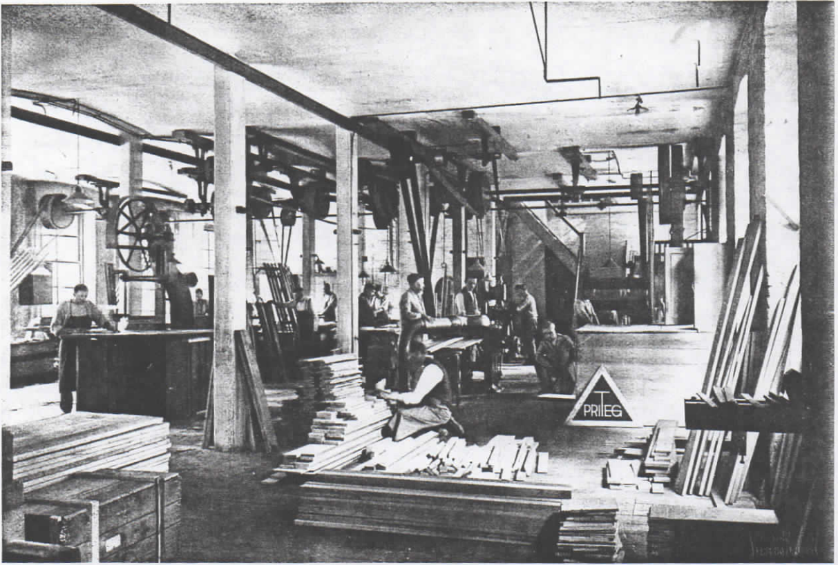
Teilansicht des Holz-Zuschneideraumes.
