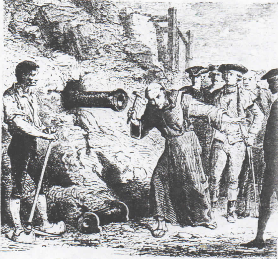
Abb. 4. Der Zisterzienser Dom Gauthey führt 1782 eine Röhrenanlage vor, mit welcher er sich mittels besonderer Klopfeichen auf weite Entfernungen verständlich machte.
