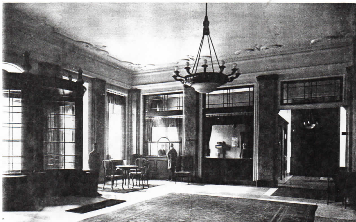
Abb. 2. Empfangsraum mit „Priteg“-Lichtsignal-Tableau im Palast-Hotel Quellenhof in Aachen.
