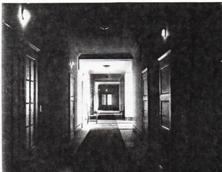
Abb. 7. Flur mit „Priteg“-Lichtsignal-Anlage im Palasthotel Quellenhof in Aachen.
