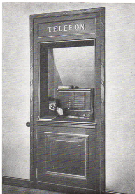
„Priteg“ Glühlampen-Zentrale im Central-Hotel Columbus in Bremen.
