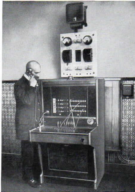
Abb. 7. „Priteg“ Glühlampen-Zentrale als Unterzentrale in den Städt. Betriebswerken, Crefeld.
