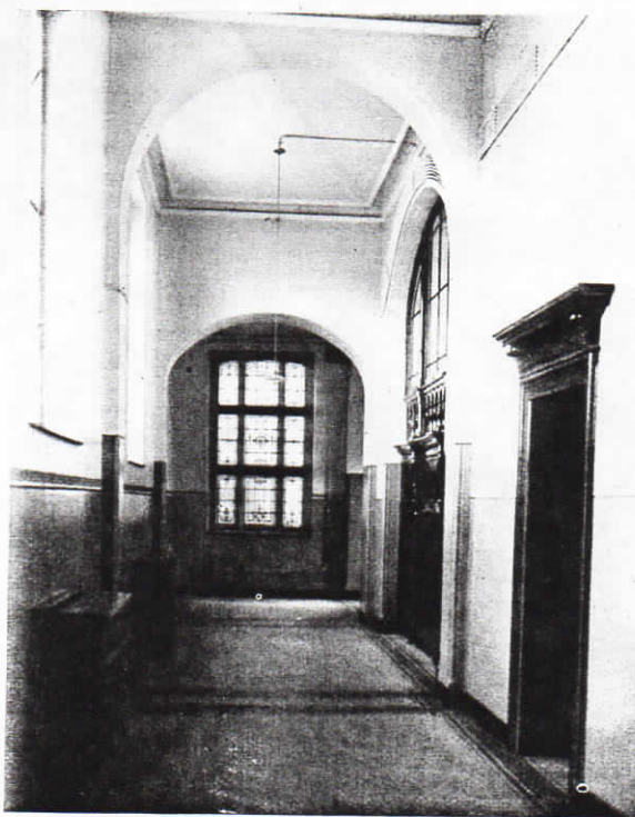
Abb. 3. Korridor im Rathaus Crefeld mit den zahlreichen Rohrleitungen, die in unauffälliger Weise der Innenarchitektur angepaßt sind.
