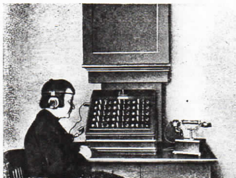
Abb. 1. Vermittlungsstelle in Spezialausführung.
