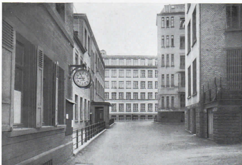
Normalzeit-Uhr in wasserdichtem Gehäuse im Hof des Stuttgarter Verein, Versicherungs A.-G. in Stuttgart.
