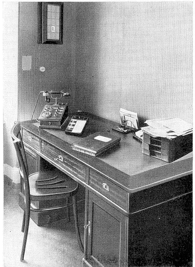
Abb. 3. Teilansicht des Direktionszimmers mit Priteg-Vorschalt-Fernsprechapparat, ferner Einschaltvorrichtung für die Lichtrufanlage mit Kontrolleinrichtung, sowie an der Wand Stockwerk-Kontrolltablo für die Lichtsignalanlage.
