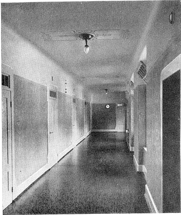
Abb. 2. Flur mit Priteg-Lichtsignalanlage und Normalzeituhr im Sanatorium Wehrwald bei Todtmoos im Schwarzwald.
