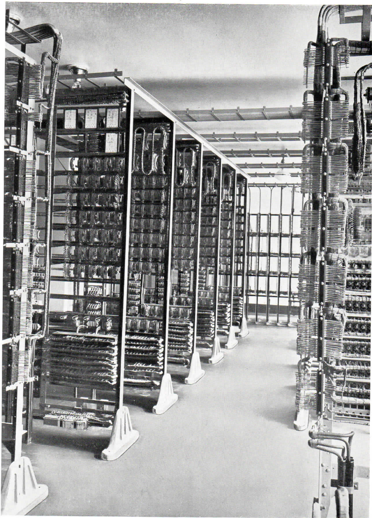
Abb. 4. Rückansicht der Wählergestelle
