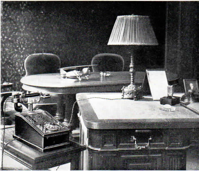
Abb. 8. Spezialstation für automatischen Ruf, direkter Linienwahl, Meldeleitung, Lichtruf und Türblockierung für Direktoren
