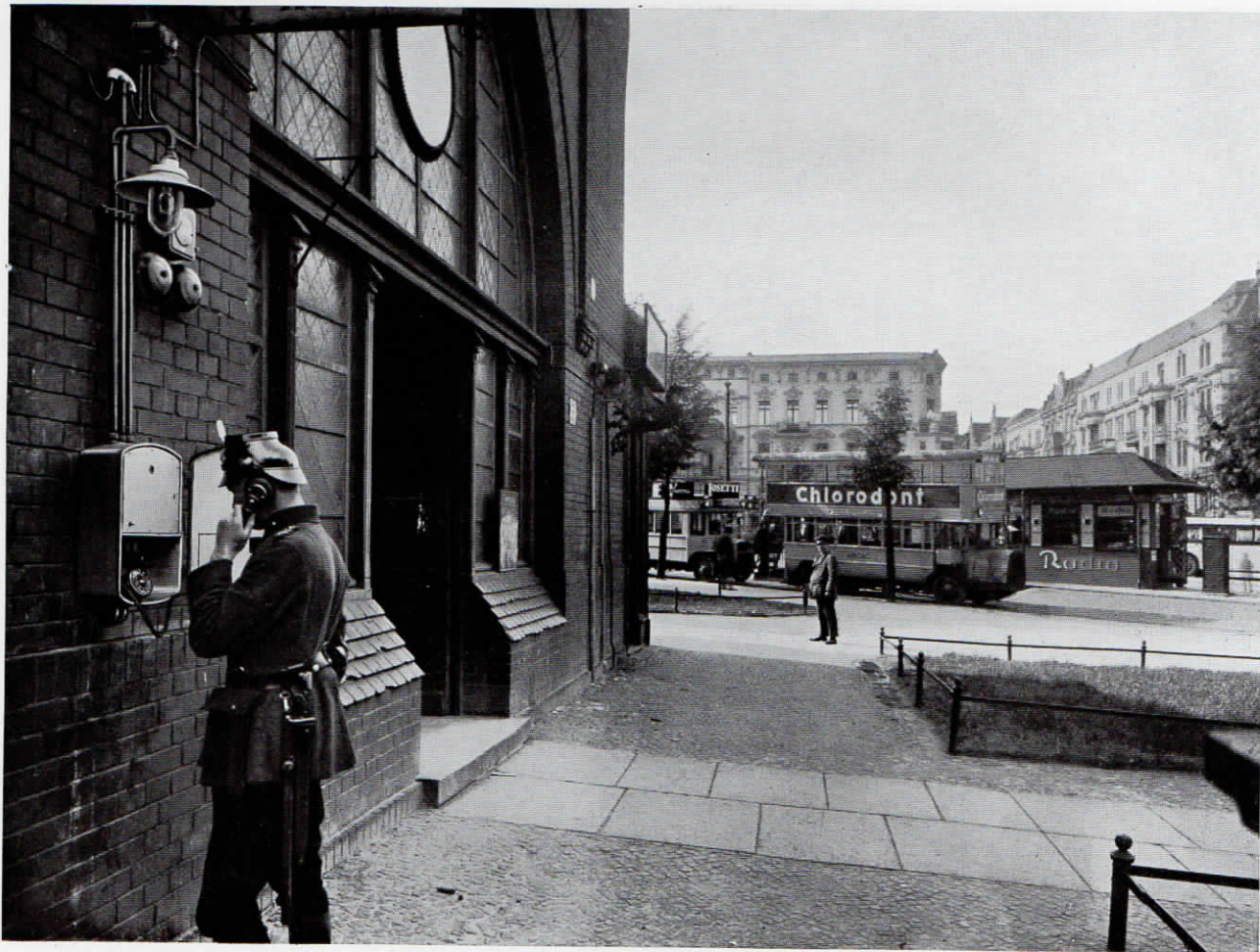
Abb. 30. Polizei-Notruf-Straßenmelder in Berlin, mit Fernsprech-Apparat, Anruflampe und Wecker
