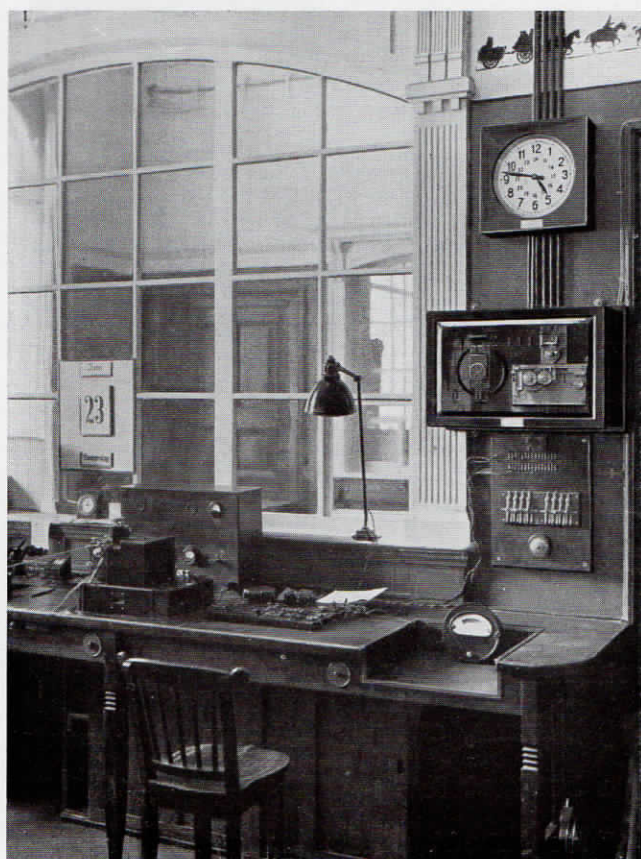
Abb. 27. Normalzeit-Nebenuhr und Zeitsignalgeber-Einrichtung für selbsttätige drahtlose Zeit-Übermittlung, im Präsidium
