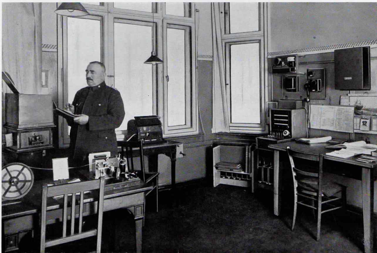
Abb. 26. Fernsprechzentrale eines Polizei-Reviere mit Sondereinrichtung für den Simultanbetrieb im Verbindungsleitungsverkehr und selbsttätiger Ladeeinrichtung für die Betriebsbatterie
