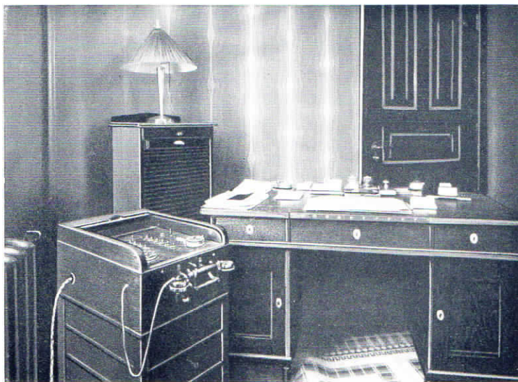
Abb. 20. Arbeitszimmer des Direktors der Nachrichtenstelle mit fahrbarem Fernsprechtisch „Pufu“ im Fischereihafen in Cuxhaven
