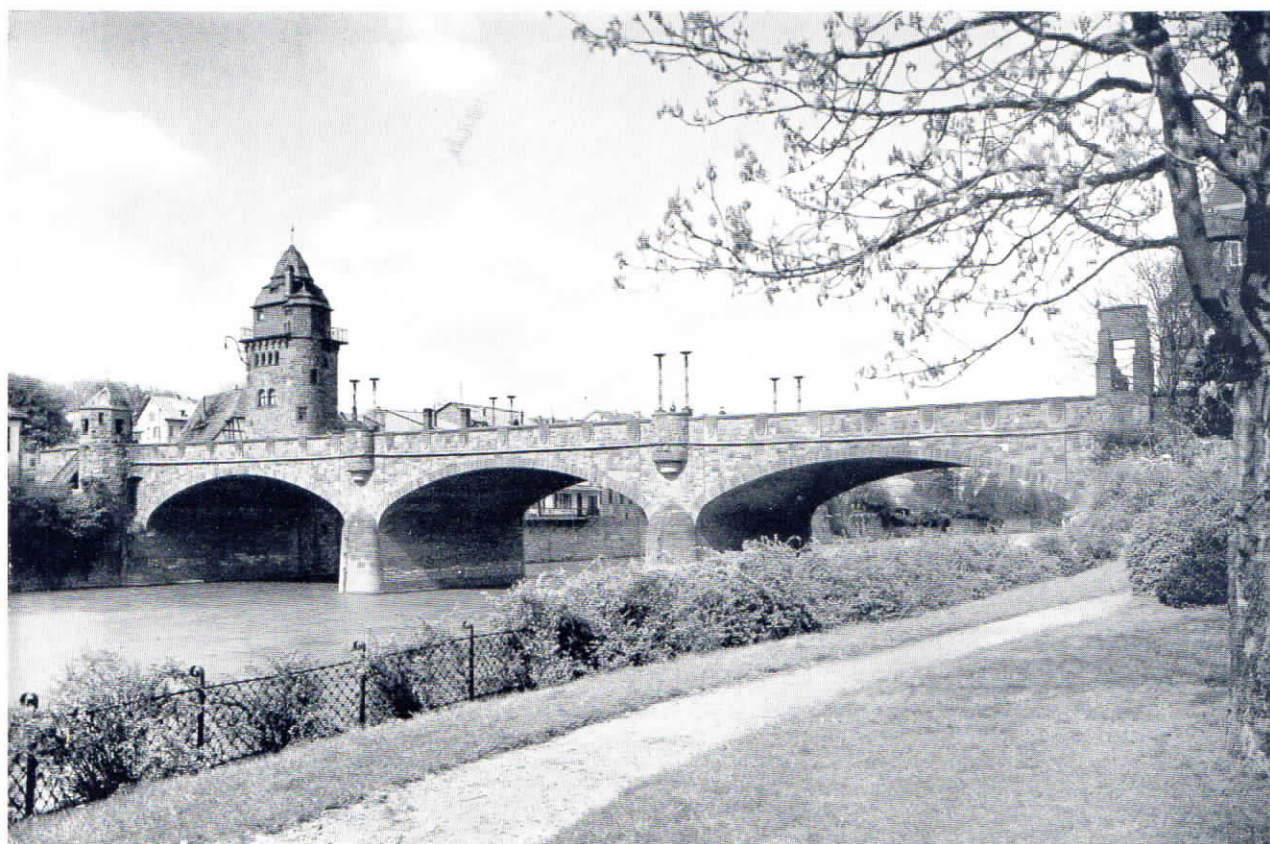
Abb. 8. Bad Kreuznach. Neue Nahebrücke mit Kabel für die Feuermelde- und Alarmanlage. (Um die Kabelführung zu zeigen, ist das Kabel besonders hervorgehoben)
