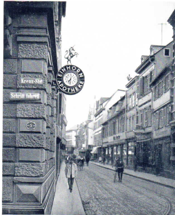
Abb. 11. Normalzeit-Reklame-Nebenuhr (an das städtische Leitungsnetz angeschlossen) in der Mannheimer Straße, Bad Kreuznach
