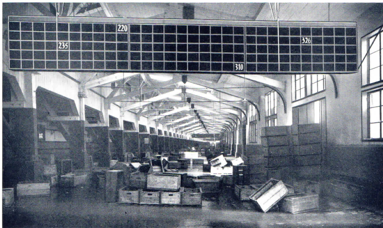
Abb. 6. Fischauktionshalle mit fünf 8 m langen und 1 m hohen Lichtsignaltablos für 150 Teilnehmer, in Wesermünde-F.
