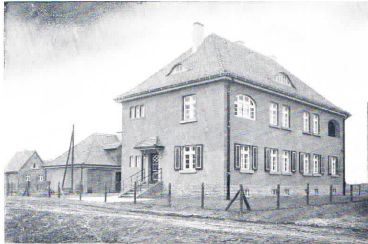
Abb. 6. Streckenbauleitungsgebäude in Glindenberg
