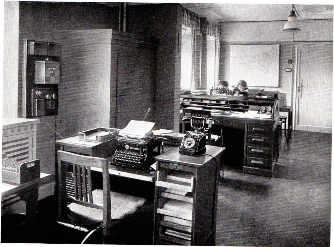
Abb. 7. Büro mit Fernsprechapparaten und Türsperrsignal in der Möbelfabrik Siegfried Silbermann, Würzburg.
