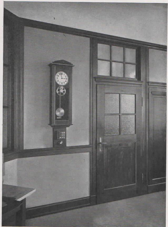
Abb. 8. Normalzeit-Signal-Hauptuhr nebst Einschaltetastatur für die Lichtrufanlage
