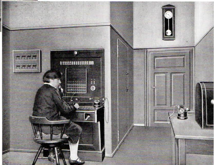
Abb. 34. Manuelle Fernsprechzentrale und Normalzeit-Hauptuhr in der Deutschen Raiffeisen-Bank A.-G., Filiale Ludwigshafen.
