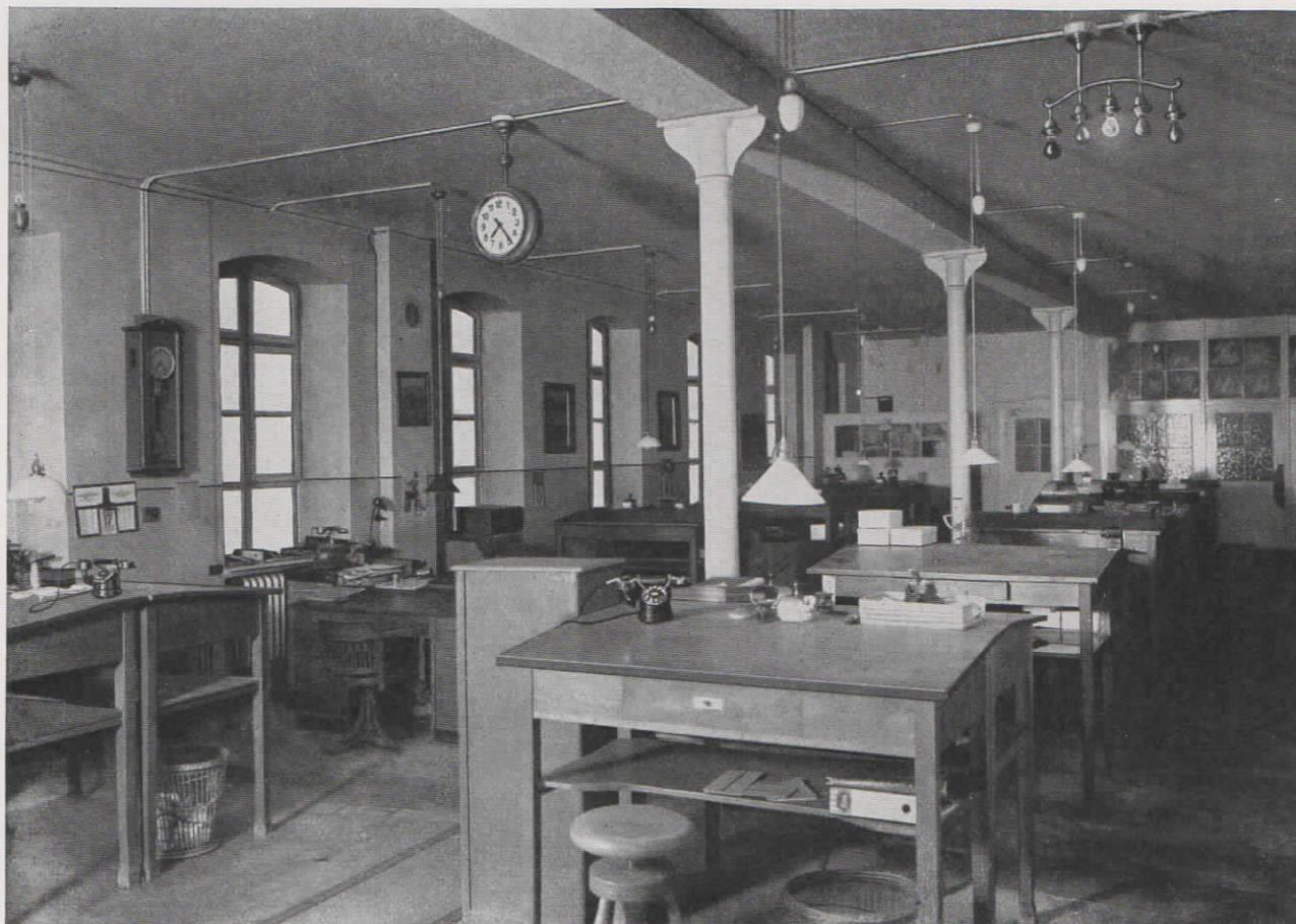
Abb. 5. Büro mit Fernsprechapparaten, Lichtruf-Armatur sowie Normalzeit-Haupt- und Nebenuhr in einem Werk der Emil Neuffer-Schuhfabriken, Pirmasens.
