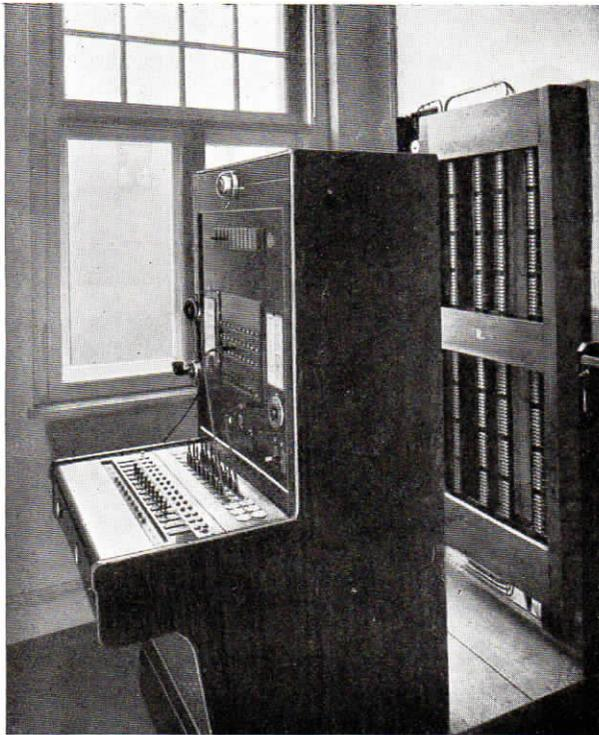
Abb. 4. Manuelle Fernsprechzentrale mit Rangierverteiler
