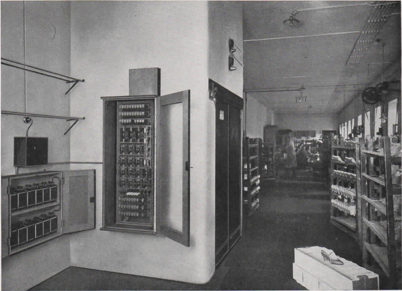
Abb. 2. Automatische Fernsprechzentrale für 25 Teilnehmer und Lichtrufanlage in einem der Werke der Emil Neuffer-Schuhfabriken, Pirmasens.
