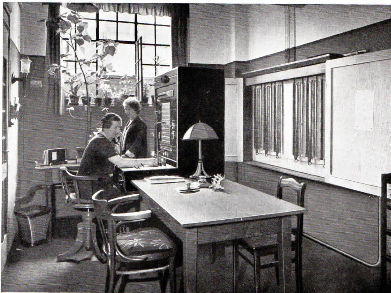
Abb. 1. Manuelle Fernsprechzentrale mit Rangierverteiler (geöffnet)
