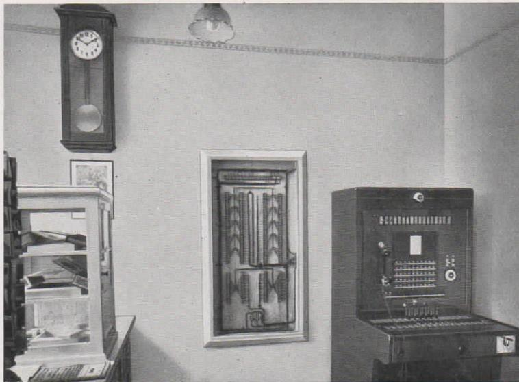
Abb. 21. Portierloge mit manueller Fernsprechzentrale, Rangierverteiler (geöffnet) und Normalzeit-Hauptuhr im Sanatorium Dr. Apolant, Bad-Kissingen.
