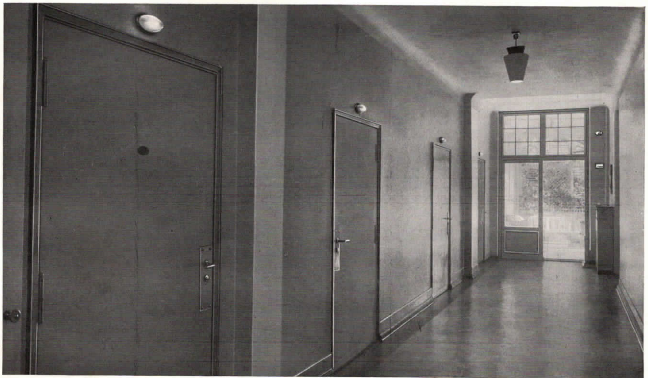
Abb. 81. Flur mit Ruflampen über den Zimmern im Westsanatorium in Berlin.
