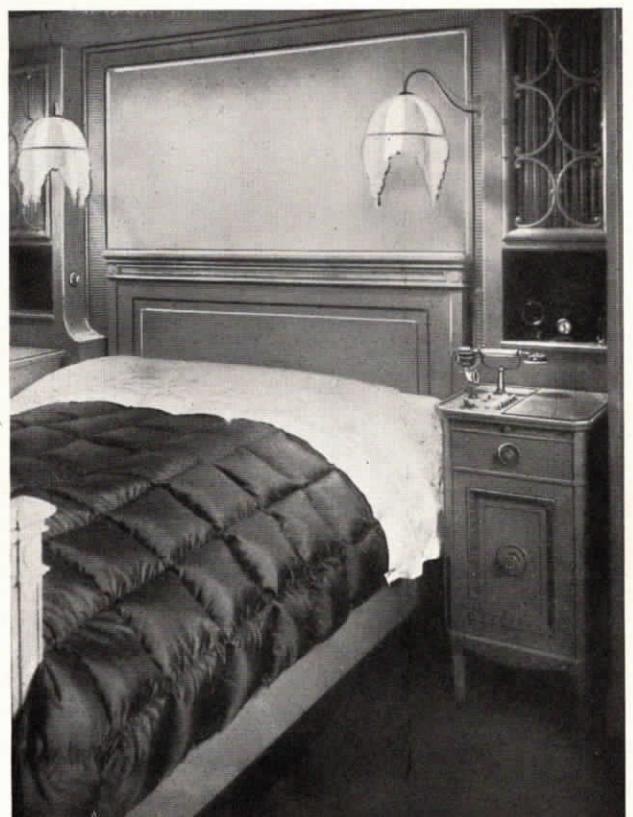
Abb. 83. In den Nachttisch eingebaute Fernsprecheinrichtung in einem Berliner Wohnhaus.
