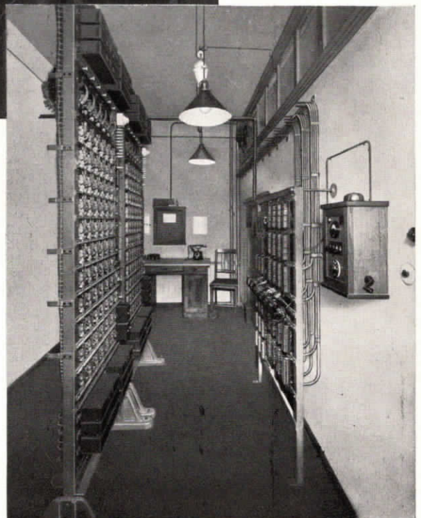
Abb. 50. Vollautomatische Fuld-Hauszentrale für 100 Teilnehmer.
