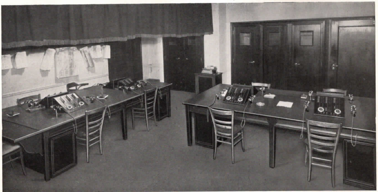
Abb. 17. Fuld-Devisen-Fernsprecheinrichtung mit 8 Arbeitsplätzen. Diese Einrichtung ermöglicht es den Börsenvertretern mit den Maklerfirmen direkt in Sprechverkehr zu treten. Alle Anrufe von der Börse bezw. von den Maklern erscheinen auf sämtlichen Arbeitsplätzen gleichzeitig. Die gleiche Einrichtung besitzt auch die Börsenabteilung dieses Bankhauses.
