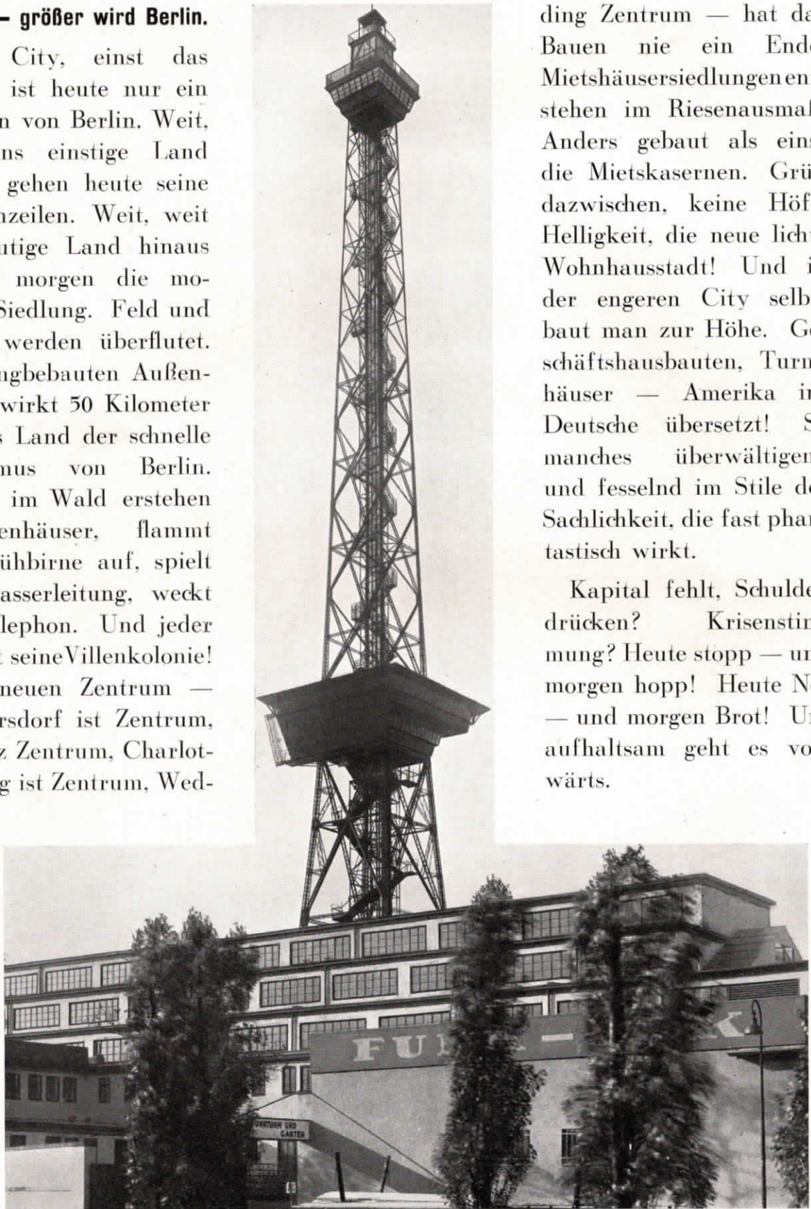
Abb. 75. Der 138 m hohe Funkturm in Berlin, dessen Plattform mit einem Fahrstuhl zu erreichen ist.
