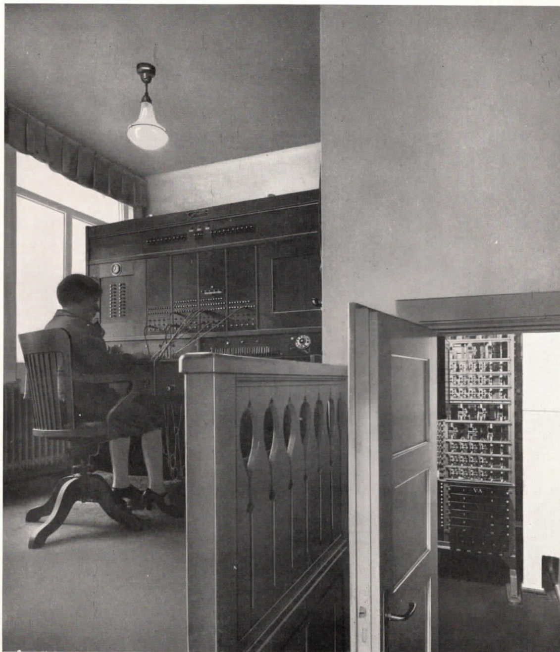
Abb. 2. Fuld-Fernsprech-Glühlampenzentrale und vollautomatische Hauszentrale für 200 Teilnehmer in der Sarotti A.-G. in Berlin.
