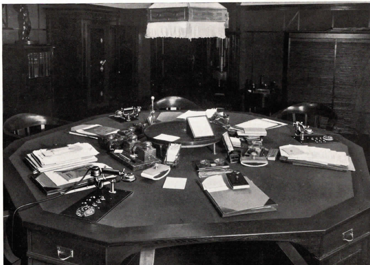
Abb. 66. Chefzimmer der Firma Graumann & Stern, Berlin, mit 3 eingebauten Fernsprechapparaturen in einem gemeinschaftlichen Tisch. Eine vollautomatische Fuld-Hauszentrale dient dem internen Verkehr.
