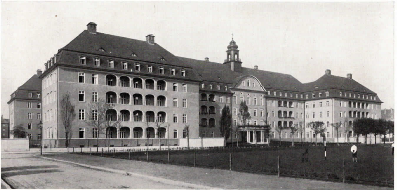
Abb. 76. Das St. Josephs-Krankenhaus in Berlin-Tempelhof wurde mit einer umfangreichen Fuld-Fernsprechanlage, bestehend aus einer Zentrale für 5 Amtsleitungen und 30 Nebenstellen, sowie mit einer vollautomatischen Hauszentrale für 80 Teilnehmer, ferner einer elektrischen Normalzeit-Uhrenanlage, bestehend aus 1 Hauptuhr und 60 Nebenuhren, ausgestattet.
