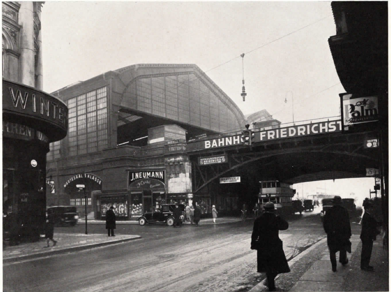
Abb. 29. Bahnhof Friedrichstraße in Berlin.
