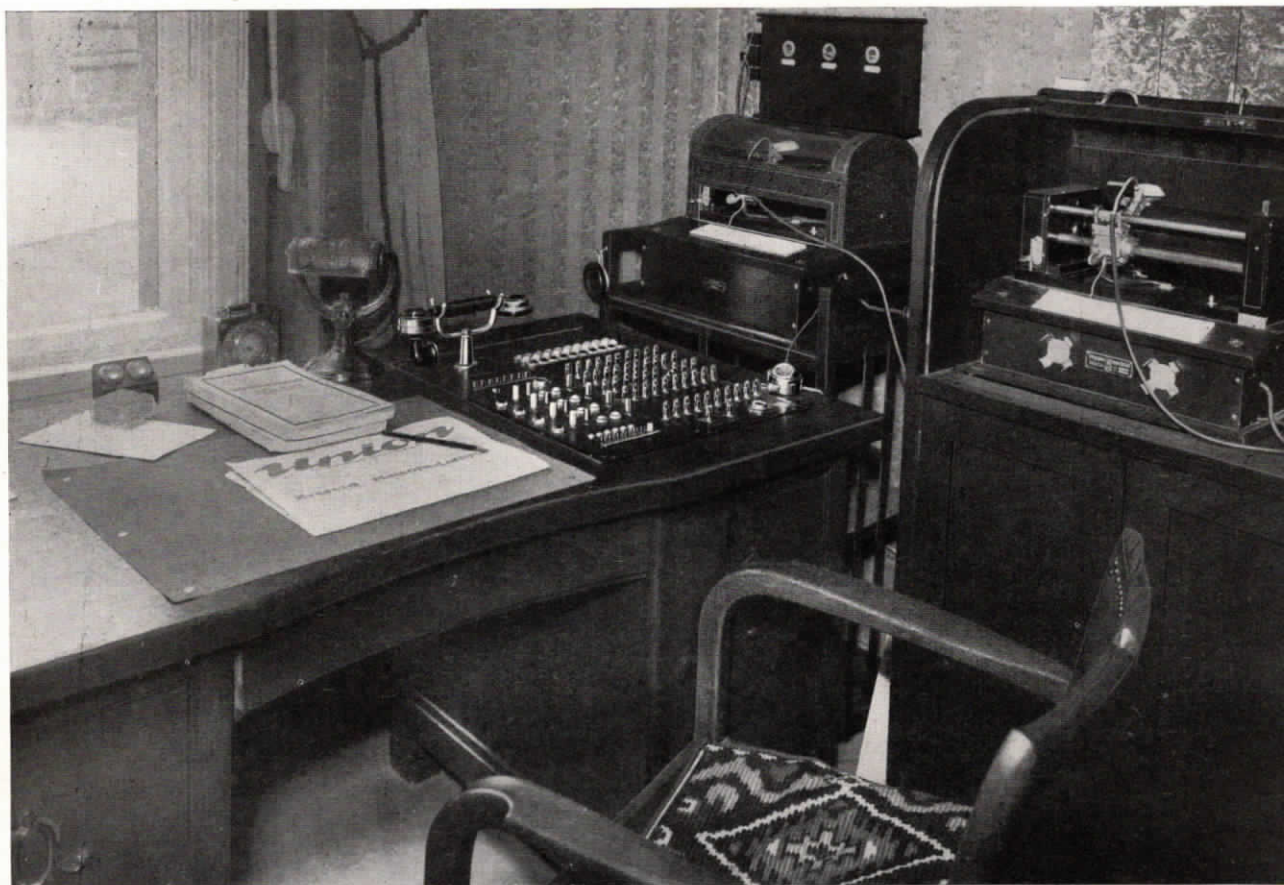
Abb. 70. Chefbüro des Wettbüros Mihan, Kurfürstendamm Berlin, mit in den Schreibtisch eingebauter Fernsprech- und Lichtrufarmatur. Die Firma besitzt eine Fuld-Fernsprechzentrale für 4 Amtsleitungen und 10 Nebenstellen.
