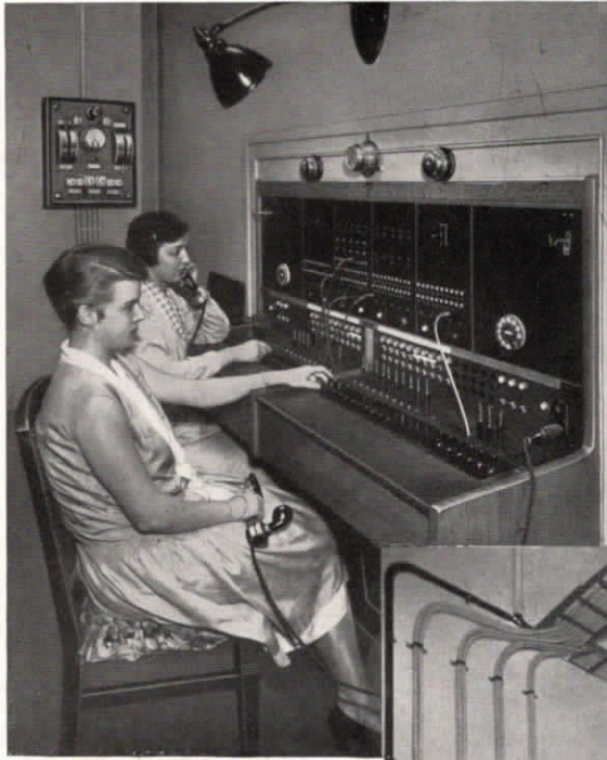
Abb. 61. Zweiplätziges Fuld-Fernsprech-Glühlampen-Zentrale für 20 Amtsleitungen und 100 Nebenstellen bei der Schweitzer & Oppler A.-G., Berlin.
