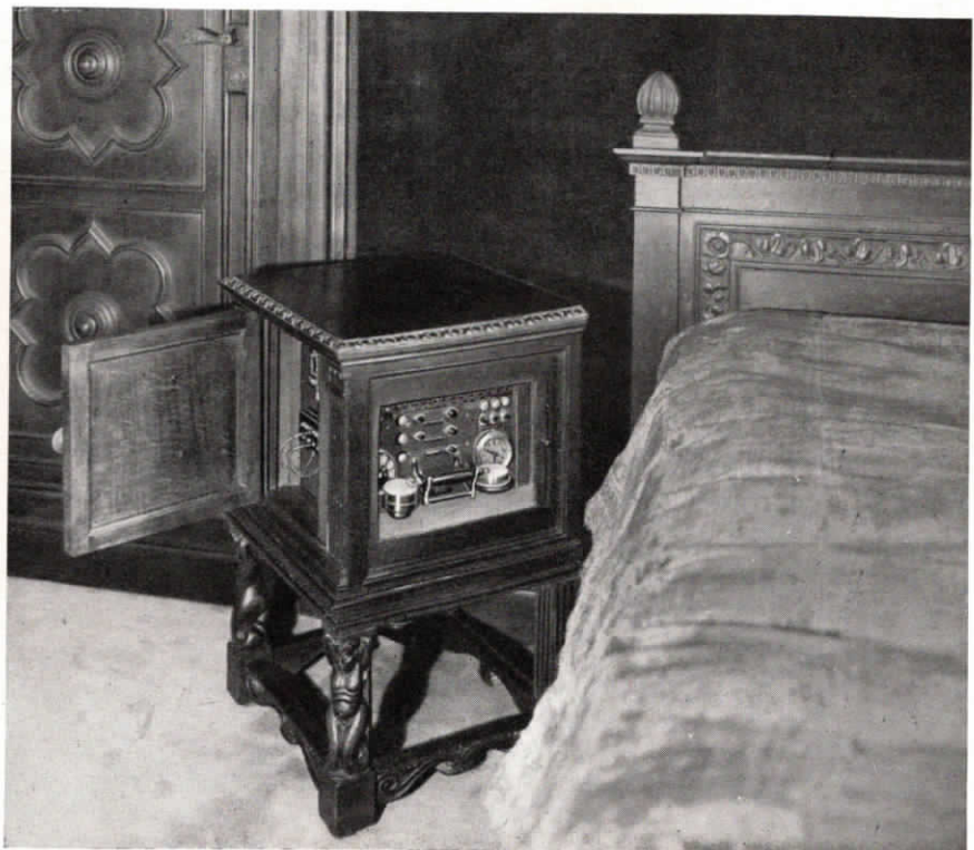
Abb. 4. Schlafzimmer mit den in den Nachttisch eingebauten schwachstrom-technischen Einrichtungen (Nachttisch geschlossen) sowie Einschaltastatur an der Tür für die Lichtrufanlage.
