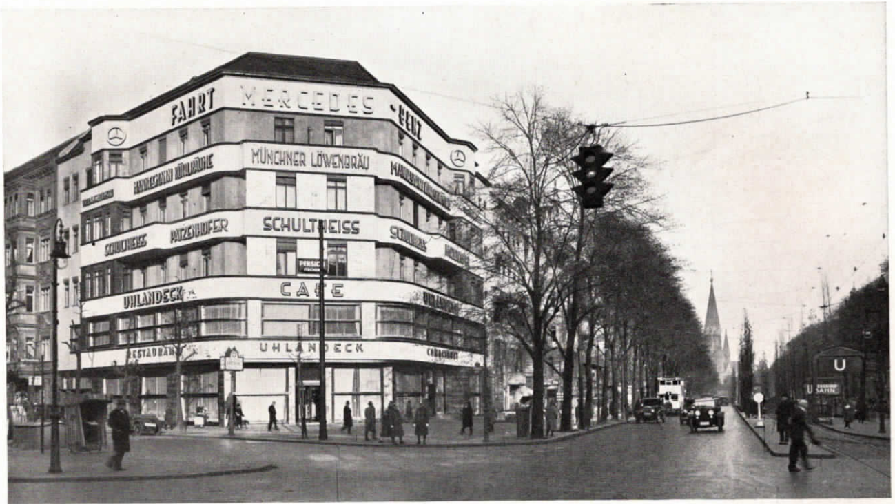
Abb. 41. Restaurant und Café Uhlandeck auf dem Kurfürstendamm in Berlin. Das Restaurant verfügt über eine ausgedehnte Fuld-Fernsprechanlage, bestehend aus einer Glühlampenzentrale für 5 Amtsleitungen, 10 Nebenstellen und 10 Hausstellen. Von den Nebenstellen sind 5 Apparate Münzfernsprecher, die den Gästen dienen.
