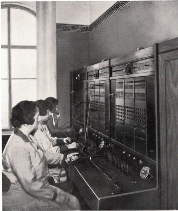
Abb. 31. Dreiplätziges Fuld-Glühlampenzentrale für 30 Amtsleitungen und 200 Nebenstellen in einer Berliner Bank.
