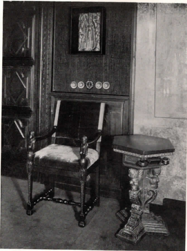
Abb. 9. Telephontisch in der Bibliothek (geschlossen). An der Wand Einschalttastatur für die Lichtrufanlage.
