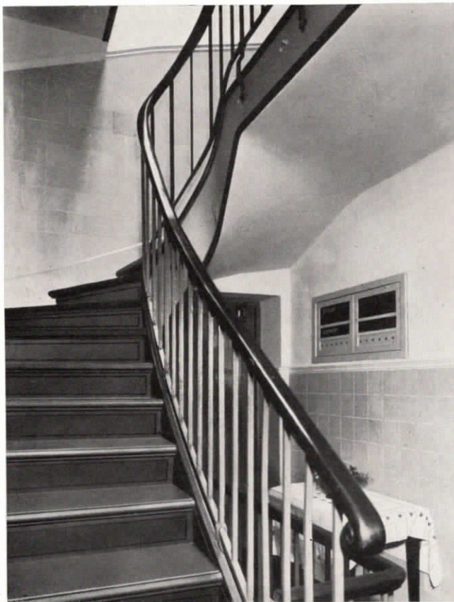
Abb. 20. Lichtruftablo im Treppenhaus für die Bediensteten.
