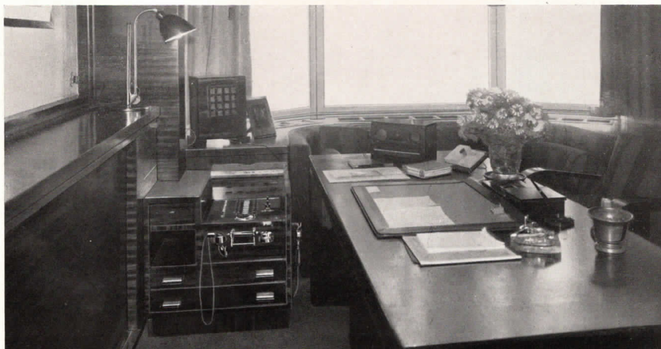
Abb. 20. Eingebaute Fernsprecheinrichtung in einem Chefzimmer des Bankhauses Lazard Speyer Ellissen in Berlin. Das Bankhaus besitzt eine Fuld-Fernsprechanlage, bestehend aus Glühlampenzentrale für 20 Amtsleitungen und 100 Nebenstellen sowie vollautomatische Hauszentrale für 100 Teilnehmer, ferner Devisen-Fernsprecheinrichtung für den direkten Verkehr zu den Börsenmaklern, zur Börse und zum Amt.
