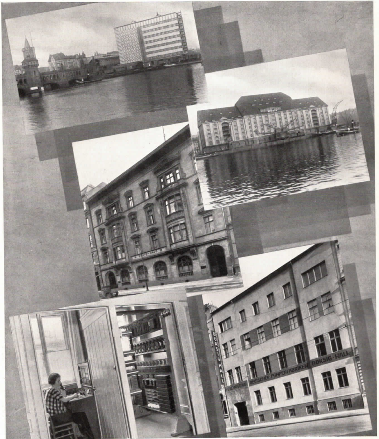
Abb. 53. Kühltransit Osthafen-Berlin besitzt eine Fuld-Fernsprech-Reihenanlage mit 6 Apparaten und Verbindungsschrank. — Abb. 54. Behala Osthafen-Berlin. Halbautomatische Glühlampenzentrale für 10 Amtsleitungen, 25 Nebenstellen und 23 Hausstellen sowie vollautomatische Hauszentrale für 100 Teilnehmer. — Abb. 55 und 56. Friedr. Krupp A.-G. Berlin. Halbautomatische Glühlampenzentrale für 7 Amtsleitungen, 40 Nebenstellen sowie vollautomatische Hauszentrale für 100 Teilnehmer. — Abb. 57. Borsig-Hall. Glühlampenzentrale für 4 Amtsleitungen und 30 Nebenstellen, vollautomatische Hauszentrale für 30 Teilnehmer, sowie eine Lichtrufanlage.
