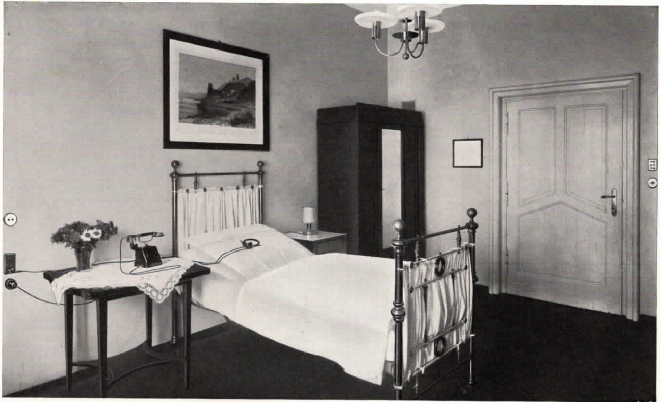
Abb. 80. Krankenzimmer mit Fuld-Fernsprecher, Einschalt-Tastatur für die Lichtruf-Anlage sowie Rundfunkanschluß im Westsanatorium Berlin. Das Westsanatorium besitzt eine Fuld-Fernsprechanlage für 6 Amtsleitungen und 80 Nebenstellen sowie eine vollautomatische Hauszentrale, eine Lichtruf-Anlage für ca. 85 Zimmer, ferner eine gemeinschaftliche Rundfunkanlage für 85 Zimmer.
