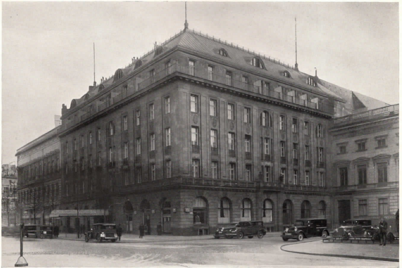
Abb. 2. Das Hotel Adlon in Berlin besitzt eine moderne Fuld-Fernsprechanlage, bestehend aus einer vierplätzigen Glühlampen-Zentrale für 60 Amtsleitungen und 400 Nebenstellen in den Hotelzimmern, einer Vestibül-Zentrale für 8 Fern- und Amtsleitungen nebst 10 Nebenstellen für den Fern- und Ortsverkehr der Fernsprechkzellen. Dem Wirtschaftsbetrieb des Hotels dient eine vollautomatische Hauszentrale für 60 Sprechstellen.
