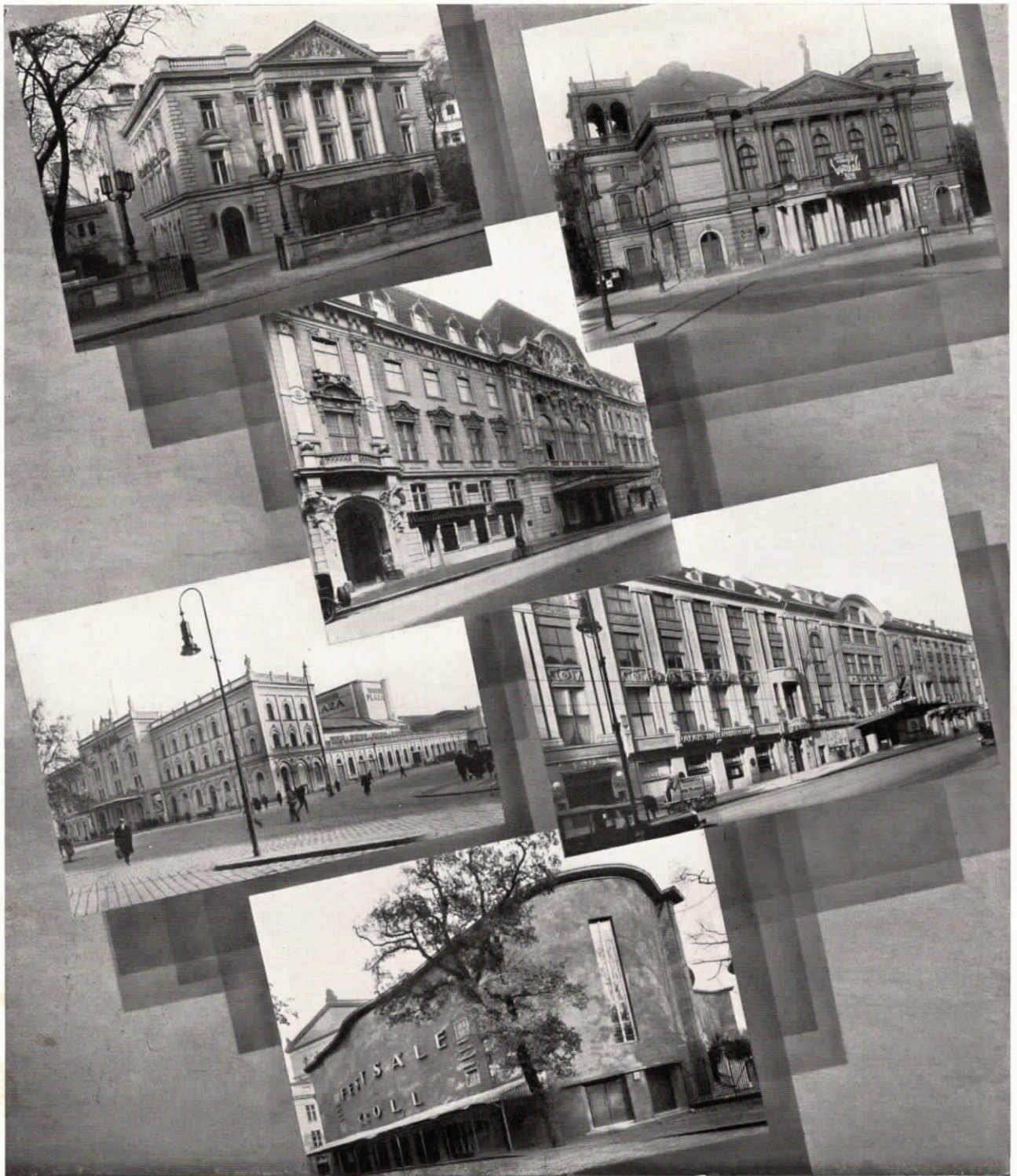
Abb. 86. Das „Berliner Theater“ besitzt eine Fuld-Fernsprechanlage, bestehend aus einer Glühlampenzentrale über 4 Amtsleitungen und 20 Nebenstellen. — Abb. 87. Lessing-Theater, Reihenanlage über 2 Amtsleitungen und 15 Hausstellen. — Abb. 88. Das Metropol-Theater verfügt über eine umfangreiche Fuld-Fernsprechanlage. — Abb. 89. Plaza, Varieté und Kabarett, Reihenanlage über 3 Amtsleitungen und 15 Hausstellen. — Abb. 90. Scala Varieté, Reihenanlage über 3 Amtsleitungen und 17 Hausstellen. — Abb. 91. Kroll-Festsäle, Glühlampenzentrale über 4 Amtsleitungen, 40 Sprechstellen sowie vollautomatische Hauszentrale.
