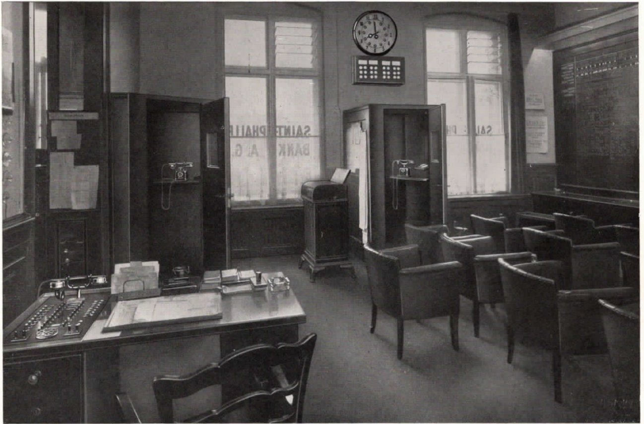
Abb. 25. Devisen-Fernsprecheinrichtung, Lichtsignaltablo für Städtemeldung und Personenruf, sowie Normalzeit-Nebenuhr in der St. Phallebank A.-G., Berlin.
