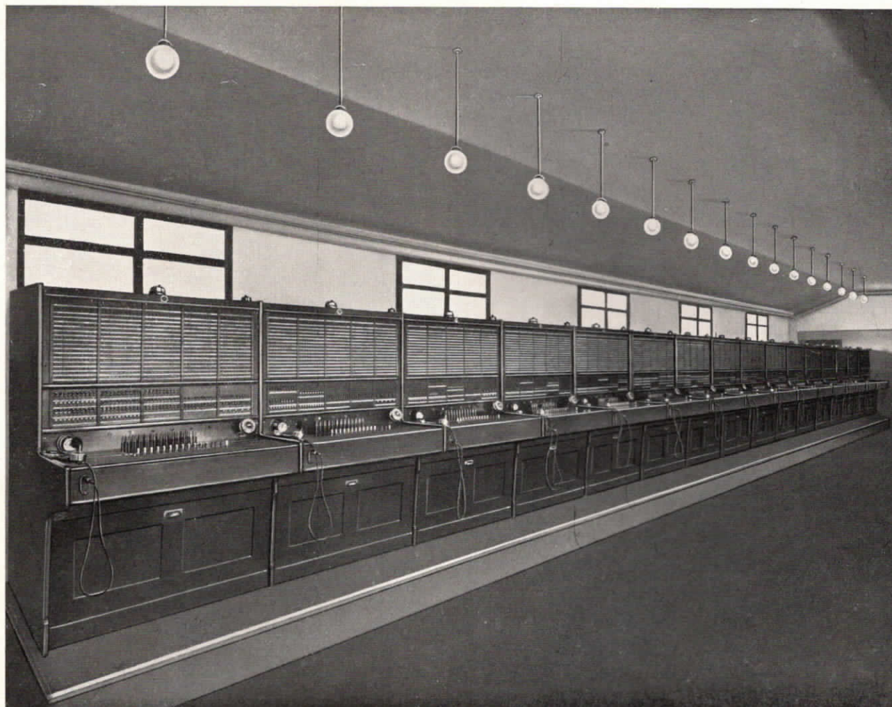
Abb. 2. Halbautomatische Fuld-Fernsprech-Glühlampen-Zentrale mit 17 Arbeitsplätzen, ca. 150 Amtsleitungen und 700 Nebenstellen im Hauptgebäude der Dresdner Bank in Berlin.
