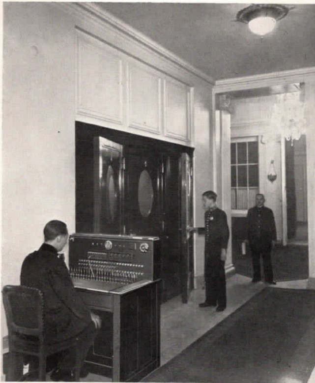
Abb. 7. Fuld-Vestibülzentrale für den Fern- und Ortsamtsverkehr der Telephonzellen für 10 Fern- und Amtsleitungen, 20 Nebenstellen und 10 Verbindungsleitungen zur Hauptzentrale, mit Warteklinken und elektrischer Normalzeit-Nebenuhr im Hotel „Der Kaiserhof“ in Berlin.
