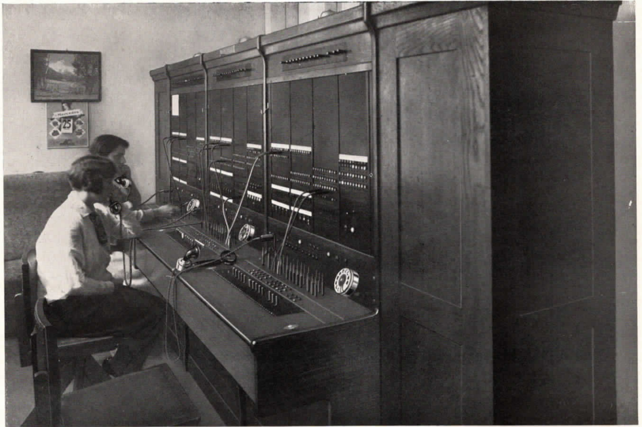
Abb. 16. Halbautomatische Fuld-Fernsprechzentrale mit 3 Arbeitsplätzen im Bankhaus Gebr. Arnhold, Berlin. Dem internen Verkehr dient eine vollautomatische Fuld-Hauszentrale.
