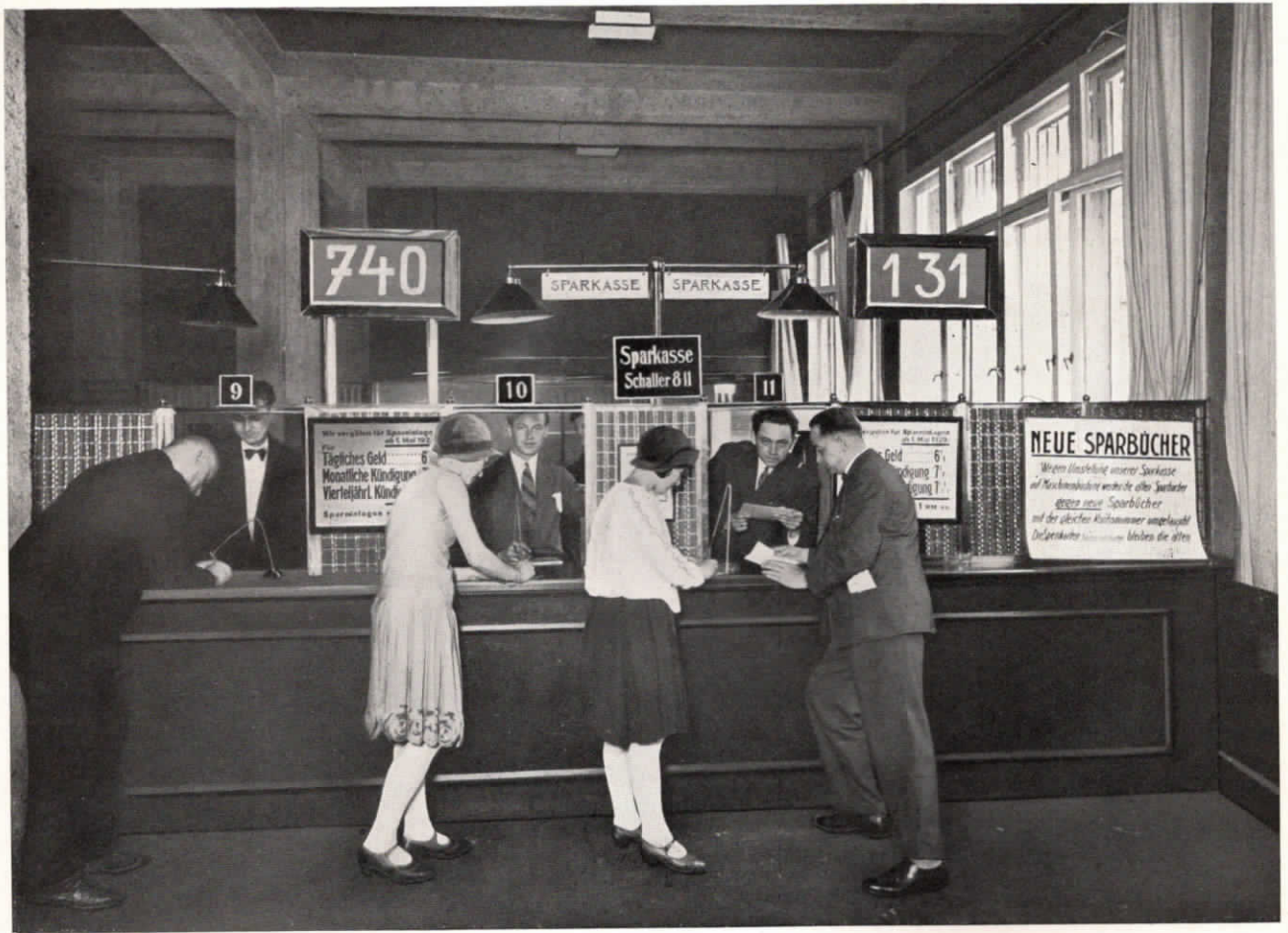
Abb. 21. Fuld-Zahlengabe-Signalanlage in der Bank für Angestellte und Arbeiter in Berlin.
