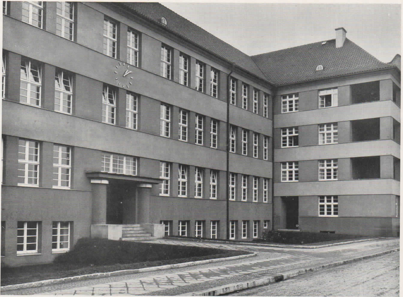
Abb. 34: Normalzeit-Nebenuhr mit freigehenden Zeigern an der Zastraschule in Neisse O/S. Die Zastraschule verfügt über eine Fuld-Reihenanlage (10 Apparate) und eine Normalzeit-Uhrenanlage
