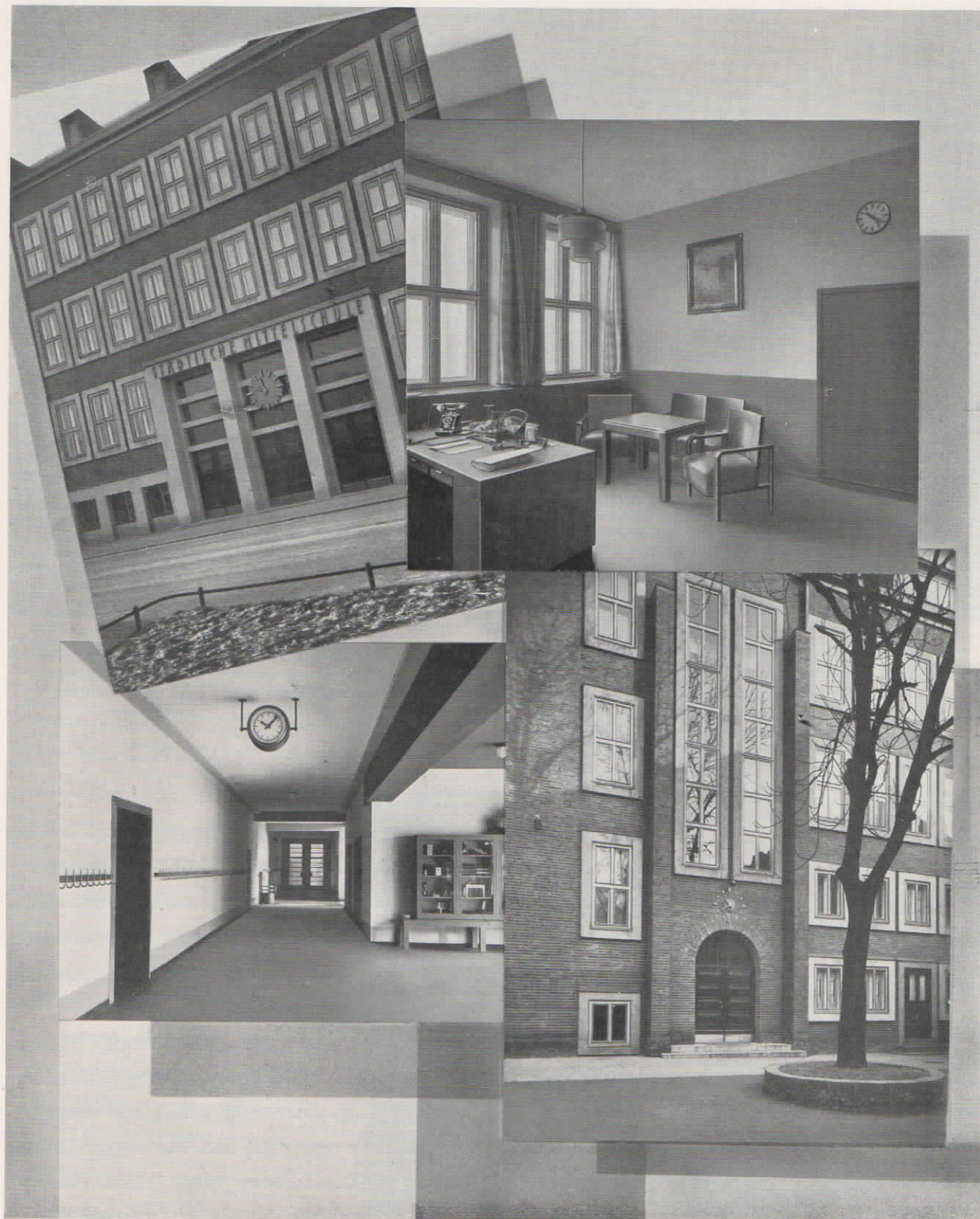
Mittelschule in Beuthen O/S. Abb. 30 (links oben) Normalzeit-Nebenuhr mit freigehenden Zeigern. Abb. 31 (rechts oben): Rektorzimmer mit Fuld-Fernsprecher und Normalzeit-Nebenuhr. Abb. 32 (links unten): Korridor mit doppelseitiger Normalzeit-Nebenuhr. Abb. 33 (rechts unten): Hofansicht mit Normalzeit-Nebenuhr und Signalwecker
