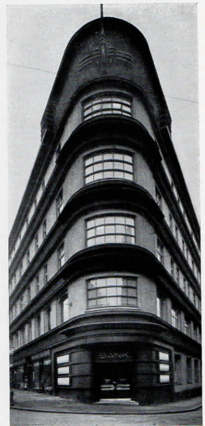
Abb. 14 : Eines der modernsten und imposantesten Gebäude Beuthens, das Bankhaus Schweitzer, Freund & Co. enthält eine umfangreiche Fuld-Fernsprechanlage
