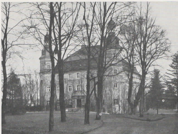
Abb. 1: Schloß Groß-Neukirch O/S, Besitzer Hans Eberhard Graf von Matuschka, verfügt über eine Fuld-Reihenanlage in Verbindung mit einem Hausautomaten und 4 außenliegenden Nebenstellen
