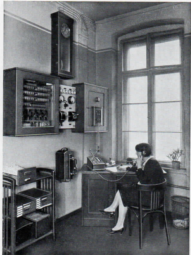
Abb. 12: Stimmungsbild aus Oberschlesien (Oberschlesische Hüttenwerke Gleiwitz). Die Unterabteilung Stahlröhrenwerk Hulschinsky der Oberschlesischen Hüttenwerke verfügt über eine Fuld-Fernsprechzentrale und über eine Normalzeit-Uhrenanlage
