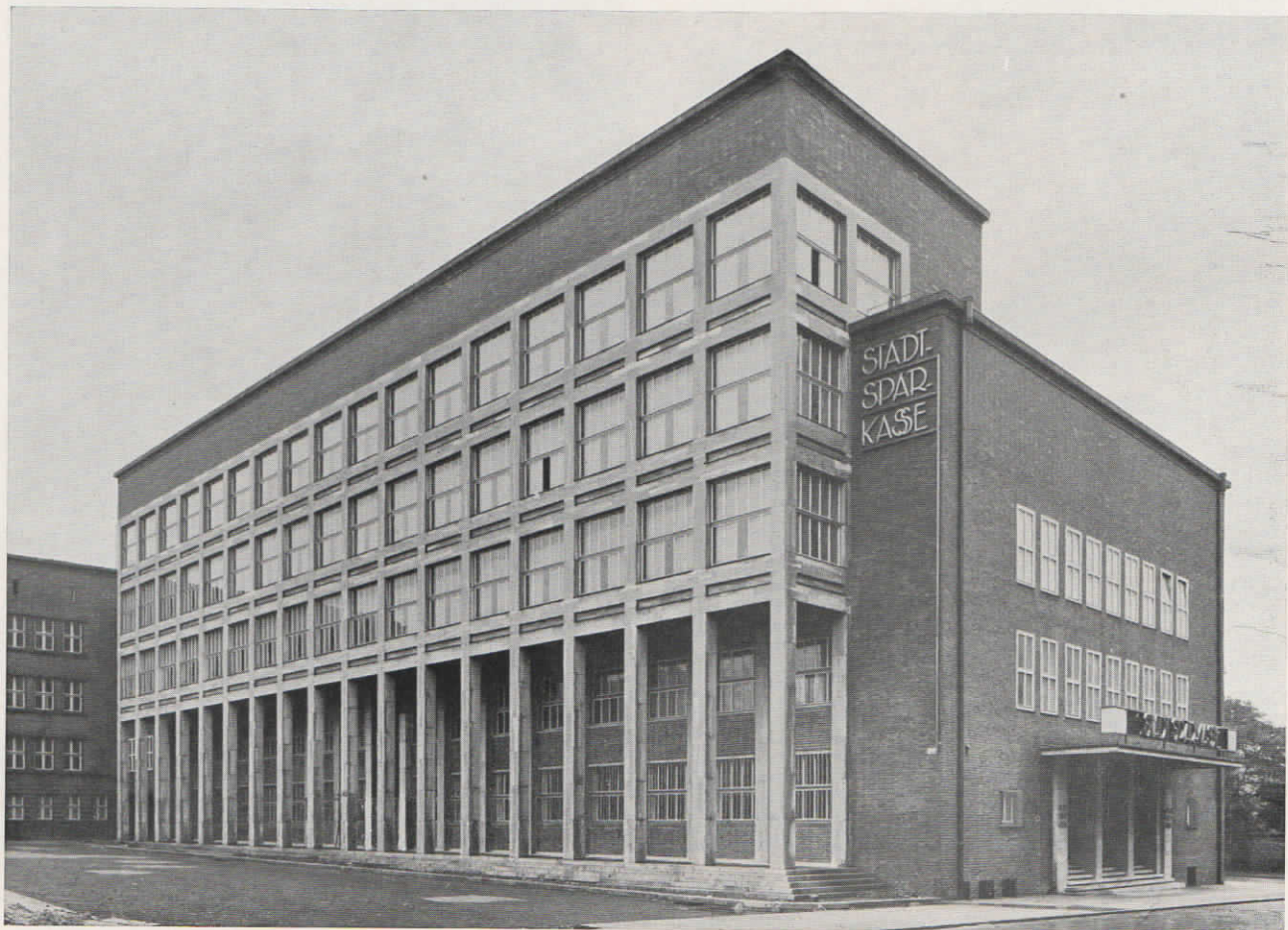
Abb. 40: Die Stadt-Sparkasse in Beuthen besitzt eine halbautomatische Fuld-Fernsprechzentrale in Verbindung mit einer vollautomatischen Hauszentrale für 50 Teilnehmer mit Verbindungsleitungsverkehr zu der Fuld-Fernsprechzentrale im Rathaus, 25 Fernsprechapparate, kombiniert für Post- und Hausgespräche, ferner Personen-Ruf- und Türsperrsignalanlagen
