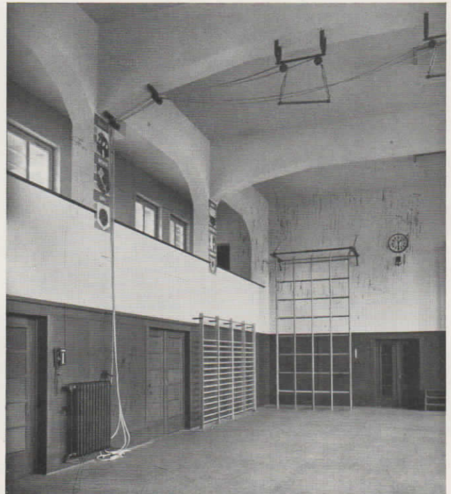
Abb. 35 (nebenstehend): Turnhalle der Zastraschule in Neisse O/S. mit Fuld-Fernsprecher und Normalzeit-Nebenuhr
