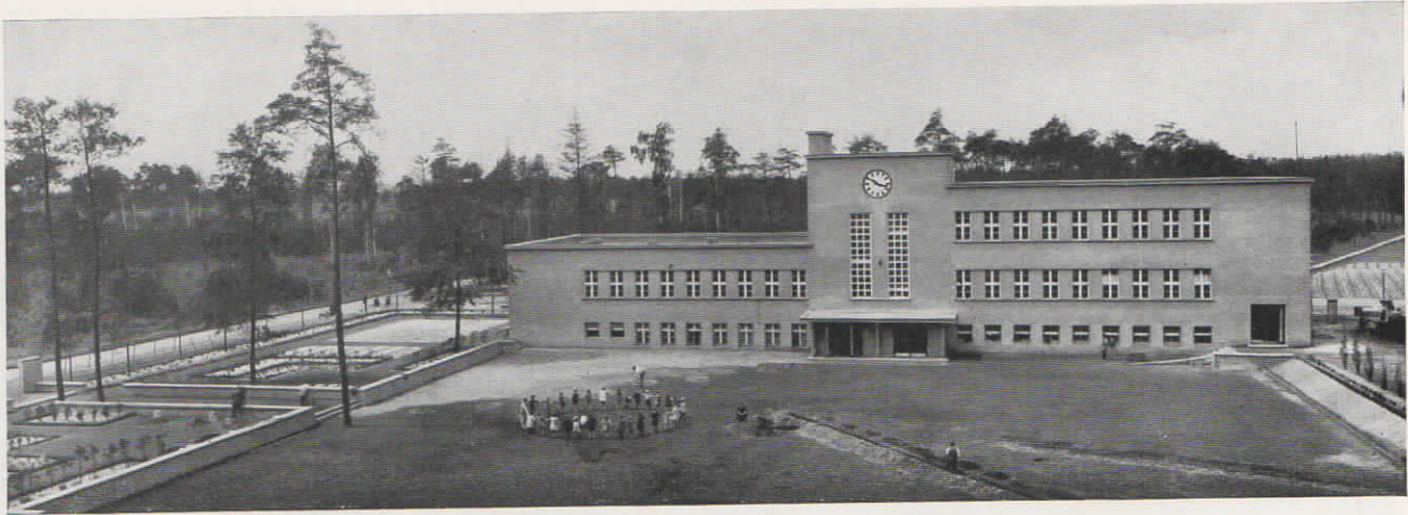
Abb. 36: Schule Siedlung Süd in Hindenburg O/S. mit Normalzeit-Nebenuhr (Zifferblatt 2 Meter Durchmesser unter Glas)
