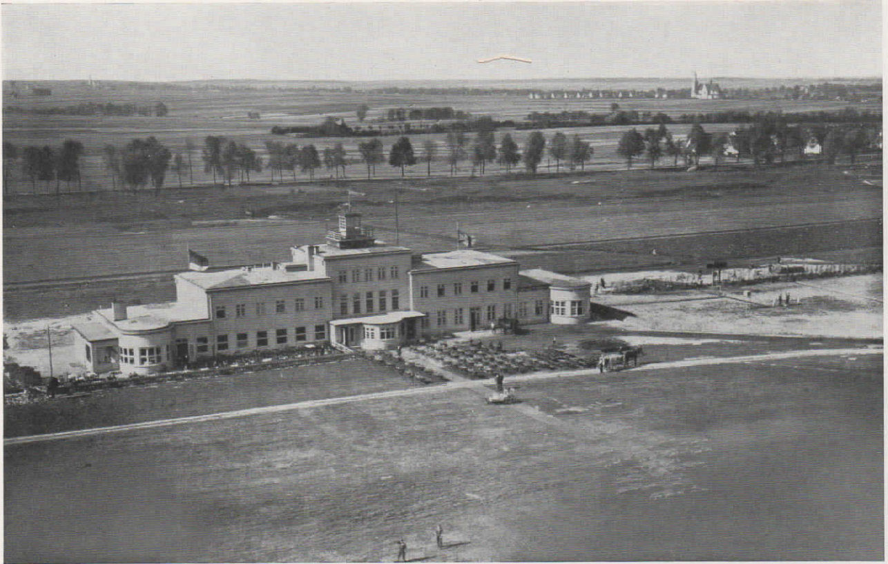
Abb. 29: Das Empfangsgebäude der Oberschlesischen Flughafen G. m. b. H. in Gleiwitz O/S. enthält eine Fuld-Glühlampenzentrale über 2 Amtsleitungen und 20 Nebenstellen, eine vollautomatische Fuld-Hauszentrale für 50 Teilnehmer, ausgebaut für 30 Teilnehmer, sowie eine Normalzeit-Uhrenanlage, bestehend aus 6 Uhren
