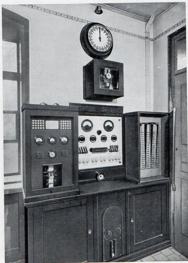
Abb. 14 (nebenstehend): Kombinierte Wächterkontroll- und Feuermelde-Zentrale für eine Schleifenleitung mit mehrfacher Sicherheitsschaltung für die gleichzeitige Kontrolle mehrerer Wächter, ferner Ladeeinrichtung für die Betriebs- und Reserve-Batterien, Quecksilber-Dampf-Gleichrichter, Kabelverteiler-Schrank (geöffnet), Signal-Nebenuhr für 10 Signalstromkreise, Personen-Suchzeigerwerk in der Portierloge der Firma S. Fränkel
