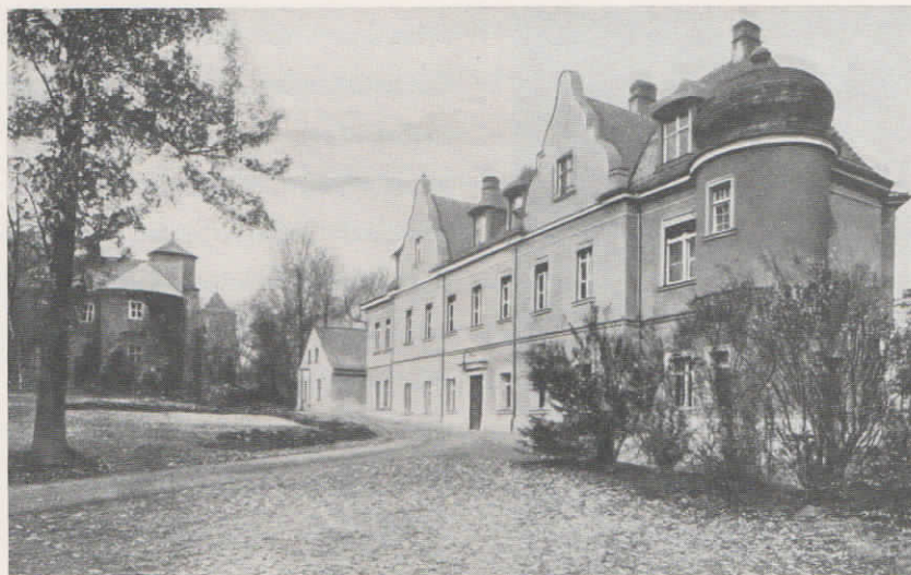
Abb. 4: Majoratsherrschaft Tost-Peiskretscham, Tost O/S., besitzt eine weitverzweigte Fuld-Fernsprechanlage, bestehend aus 1 vollautomatischen Hauszentrale, 1 Umschalteschrank für 10 Außenstellen bis 16 km Entfernung (Güter, Forstämter etc.), insgesamt sind 28 Apparate im Betrieb
