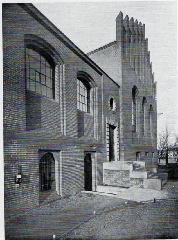
Abb. 15 und 16 (unten): Kombinierte Wächterkontroll- und Feuermelde-Apparate an den Fabrikgebäuden
