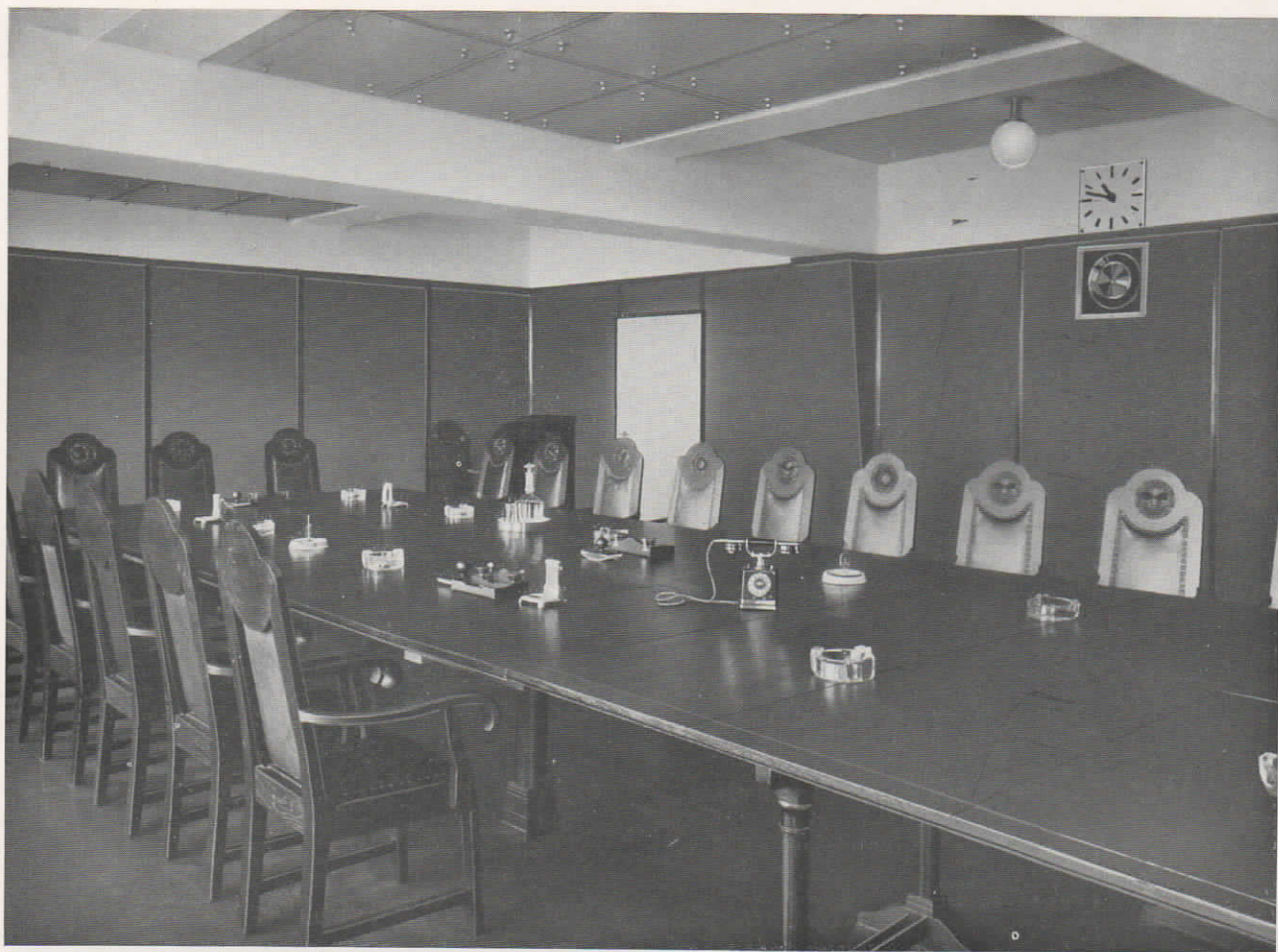
Abb. 7: Sitzungssaal im Rathaus Hindenburg O/S. mit Fuld-Fernsprecher, Normalzeit-Nebenuhr und darunter befindlichem Lautsprecher, der von der Vermittlungszentrale bedient wird und zum Heranrufen des gewünschten Teilnehmers an den Fernsprecher dient
