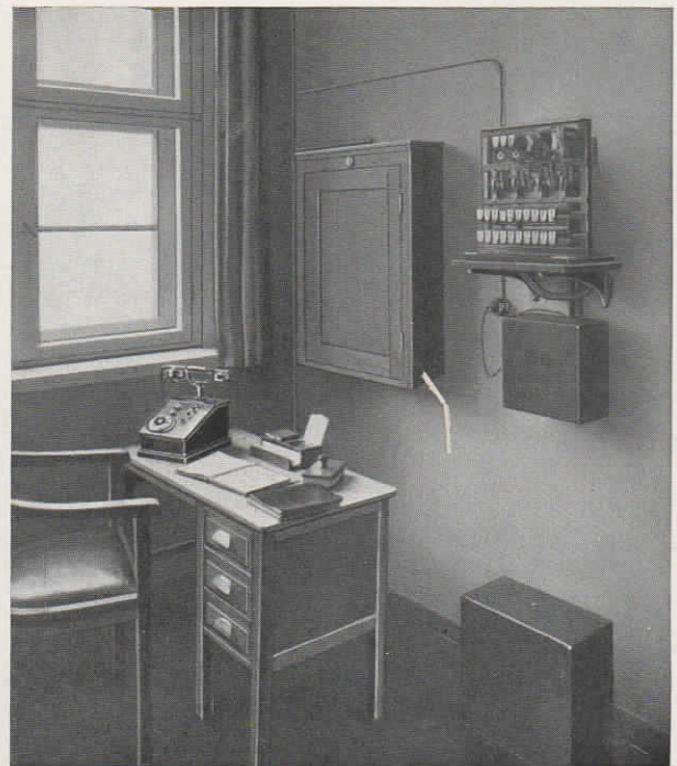
Abb. 42: Fuld-Kleinautomat für 10 Teilnehmer, geöffnet, Dauerladeeinrichtung, Verteiler mit Störungslampe, sowie Abfrageapparat in der Ortskrankenkasse „Hansa“ in Gleiwitz
