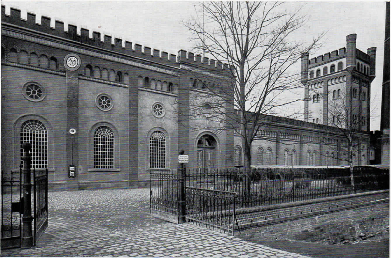
Abb. 17: Normalzeit-Nebenuhr und kombinierter Wächterkontroll- und Feuermelder am Haupteingang der neuen Weberei
