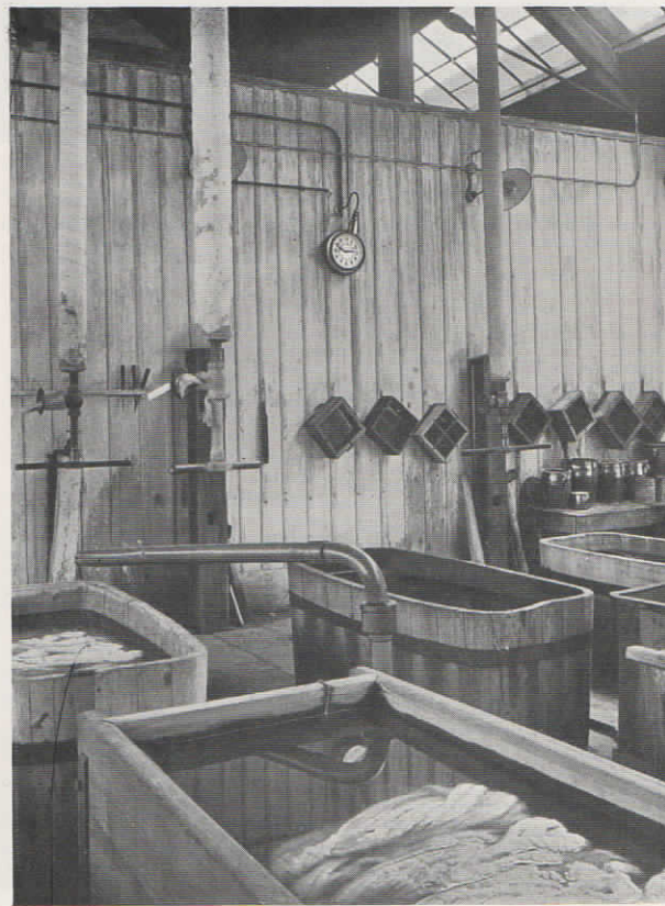
Abb. 4: Normalzeit-Nebenuhr in der Färberei
