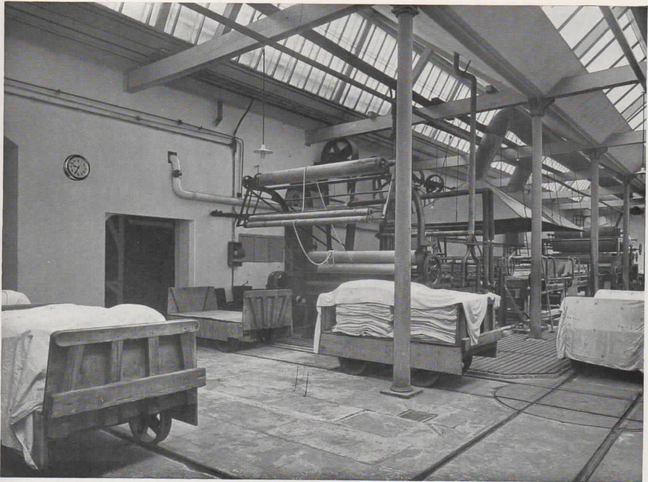
Abb. 5; Normalzeit-Nebenuhr im Mangel-Neubau
