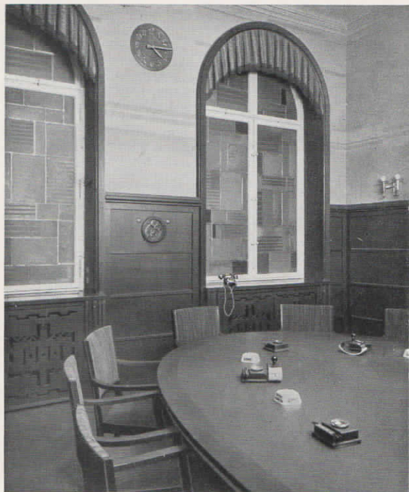
Abb. 12: Sitzungszimmer im Rathaus Ratibor mit Normalzeit-Nebenuhr und eingebautem Lautsprecher zum Herausrufen eines Sitzungsteilnehmers an einen Fernsprechapparat. Die zu beiden Seiten des Lautsprechers eingebauten verschiedenfarbigen Lämpchen zeigen an, ob es sich um ein Fern- oder Hausgespräch handelt
