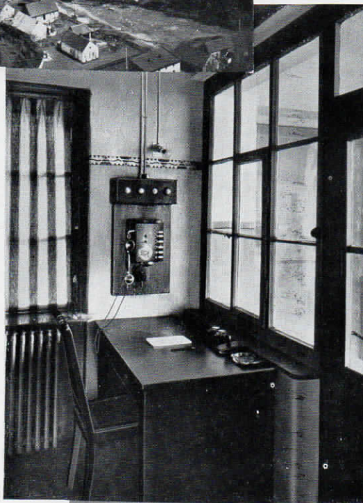
Abb. 4: Das Werk Groschowitz der Schlesischen Portland-Cement-Industrie A. G. Oppeln besitzt eine Fuld-Reihenanlage in Verbindung mit einer vollautomatischen Hauszentrale für Verbindungsleitungsverkehr, bestehend aus 15 Apparaten für den Amts- und Fernverkehr, sowie 10 Hausapparaten. Sämtliche Apparate für den Amts- und Fernverkehr besitzen eine direkte Amtsleitung in Reihe, eine Querverbindung nach dem Halbautomaten der Hauptverwaltung in Oppeln in Reihe, einen Automatenanschluß für den Hausverkehr, sowie Verbindungsleitungsverkehr über die Hauszentrale der Hauptverwaltung
