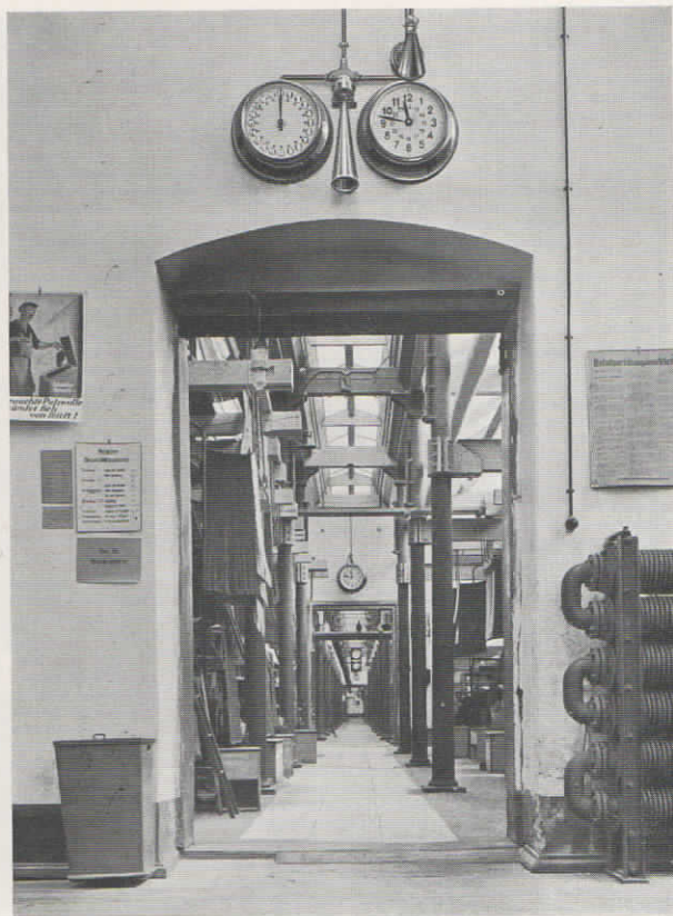
Abb. 10: Durchblick durch die Websäle mit Normalzeit-Nebenuhren und Personen-Suchanzeigern
