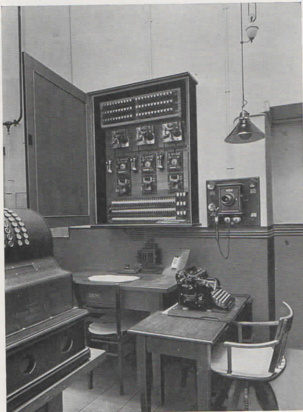
Abb. 6: Zentrale für die Personen-Ruf-Anlage, Zeigersystem, 19 Personen in 3 Gruppen
