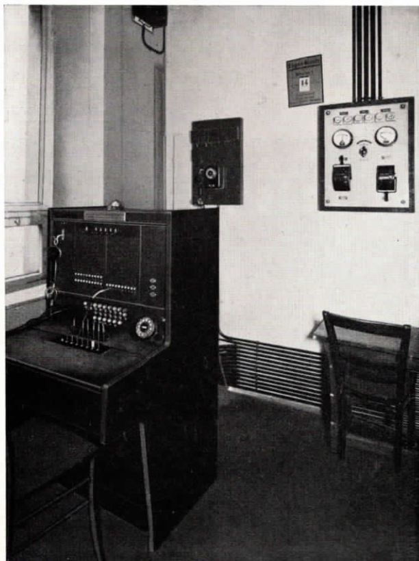
Abb. 4. Halbautomatische „Fuld“-Fernsprechzentrale für 5 Amtsleitungen, 1 Querverbindung und 30 Nebenstellen, ferner Ladeschalttafel in der Siedlungsgesellschaft Breslau Aktiengesellschaft in Breslau.
