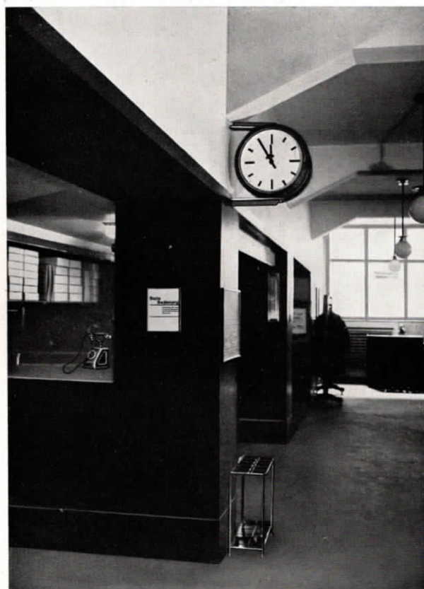
Abb. 14. Doppelseitige Normalzeit-Nebenuhr und „Fuld“-Fernsprechapparat im Kaufhaus Rudolf Petersdorff in Breslau.
