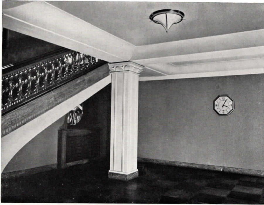
Abb. 12. Treppenhaus im Landesfinanzamt mit eingebauter Normalzeit-Nebenuhr.
