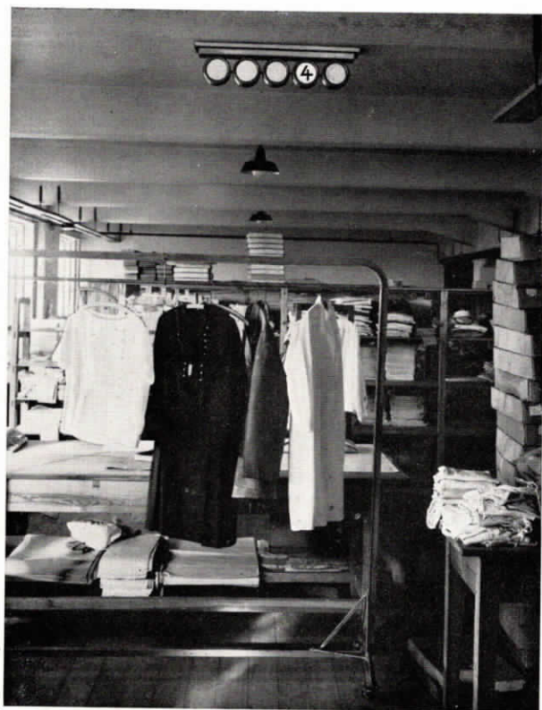
Abb. 8. „Fuld“-Suchsignalarmatur in der Expedition.
