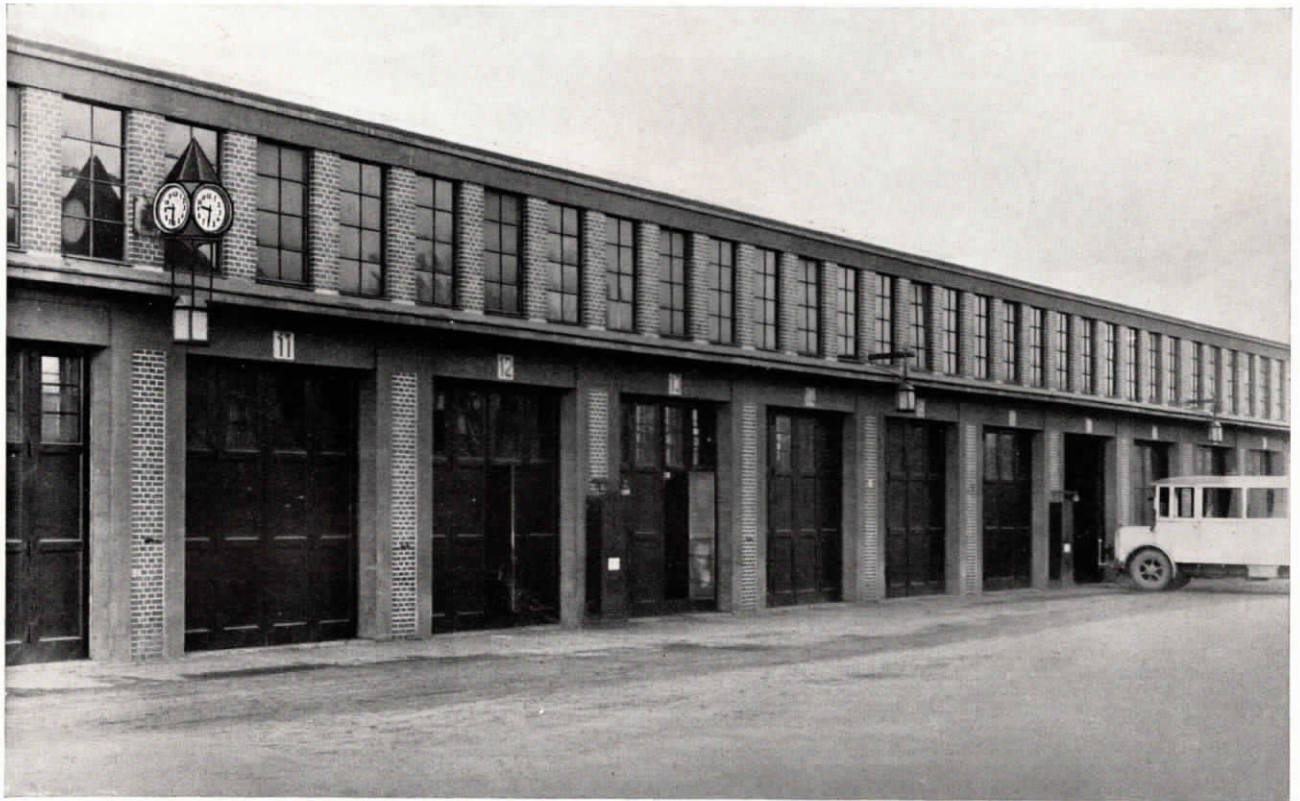
Abb. 2. Omnibushalle der Städtischen Straßenbahn mit dreiseitiger Normalzeit-Nebenuhr.
