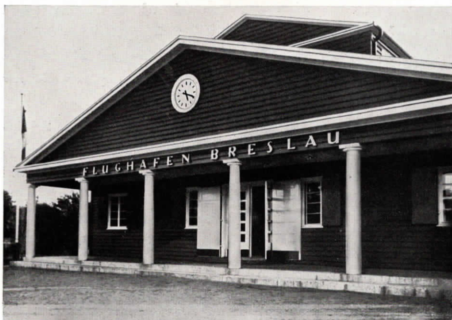
Abb. 15. Flughafen-Gebäude in Breslau mit eingebauter Normalzeit-Nebenuhr.
