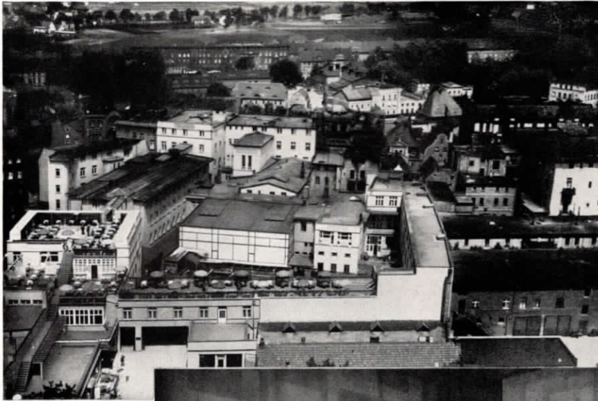
Abb. 8. Das Hotel „Drei Berge“ in Hirschberg im Riesengebirge besitzt eine „Fuld“-Glühlampenzentrale und 165 Fernsprechapparate.
