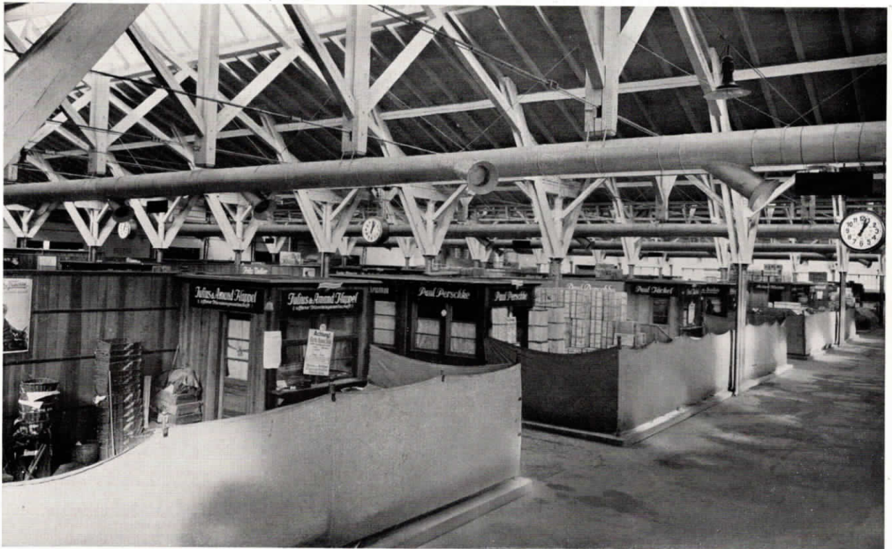
Abb. 10. In der Großmarkthalle in Breslau befinden sich eine Normalzeit-Signalhauptuhr, 6 doppelseitige transparente Nebenuhren und 4 einseitige transparente Nebenuhren.
