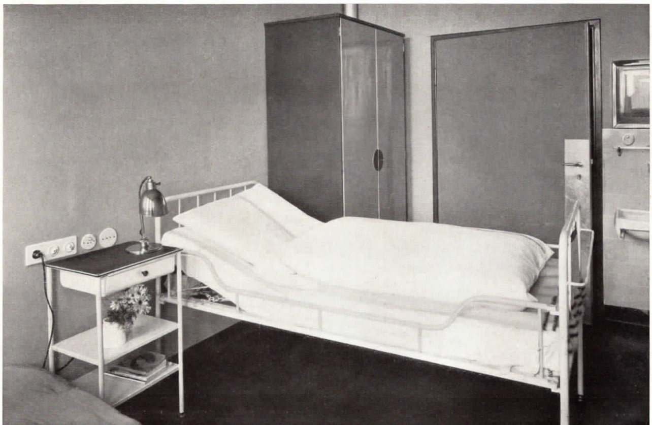
Abb. 7. Krankenzimmer mit Ruf- und Abstellastatur für die Lichtsignalanlage.
