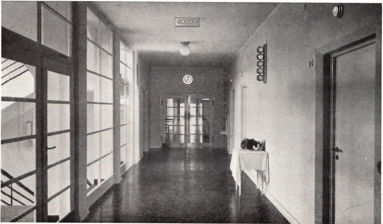
Abb. 21. Flur im Städtischen Krankenhaus in Schweinfurt a. M. mit Lichtsignal-Suchtablo für 5 Personen, Rufarmatur, Zimmerlampen und eingebauter Normalzeit-Nebenuhr.
