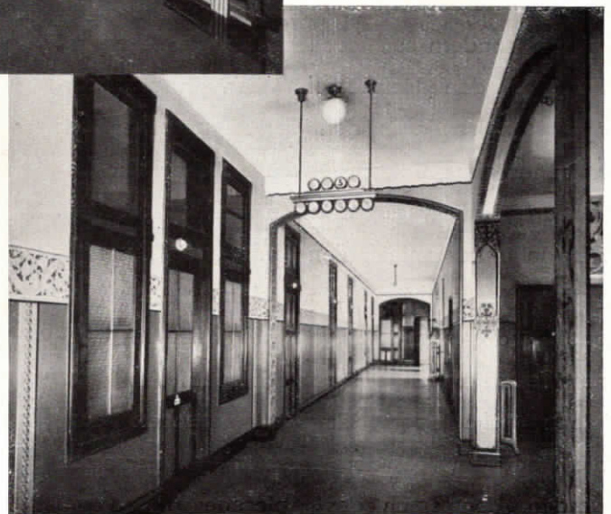
Abb. 95. Flur im St. Josef-Hospital in Bremerhaven mit Zimmerlampen und Lichtsignalarmatur. Die Armatur ist so durchgebildet, daß sie einmal als Richtungslampen — in diesem Falle mit Dauerlicht —, das andere Mal als Personensuchanlage — in diesem Falle mit Flackerlicht — dient. Die Anlage umfaßt 96 Zimmer.
