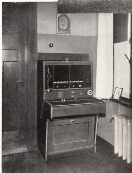
Abb. 54. »Fuld«-Glühlampenzentrale im St. Josefs-Hospital in Bochum.
