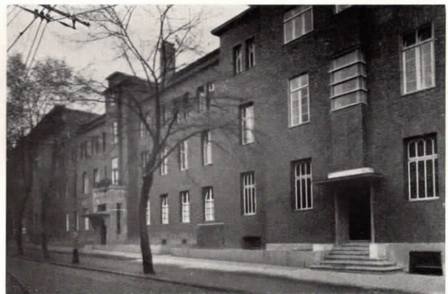
Abb. 46. Das St. Marien-Hospital in Mülheim/Ruhr besitzt eine ausgedehnte »Fuld«-Fernsprechanlage, bestehend aus einer Glühlampenzentrale für 3 Amtsleitungen und 20 Nebenstellen, sowie einem Vollautomaten für den Hausverkehr für 70 Teilnehmer, ferner eine Lichtsignalanlage und eine elektrische Normalzeit-Uhrenanlage, bestehend aus einer Hauptuhr und 10 Nebenuhren.
