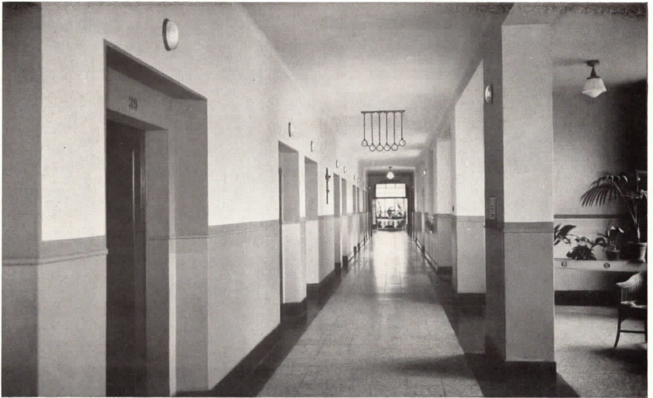
Abb.90. Flur im Städtischen Krankenhaus in Attendorn, mit Zimmerlampen und Lichtsignalarmatur.. Die Lichtrufanlage umfaßt 84 Zimmer, einschl. Bäder
