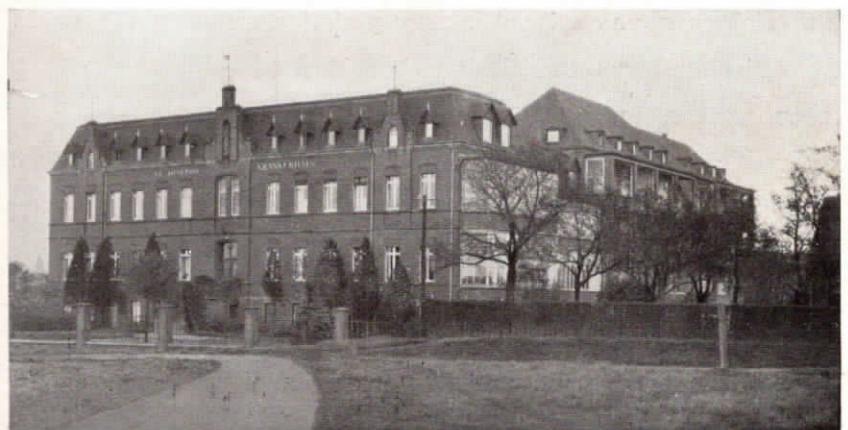
Abb. 65. Das St. Josefs-Krankenhaus in Mörs besitzt eine Fulde-Fernsprech-Reihenanlage.
