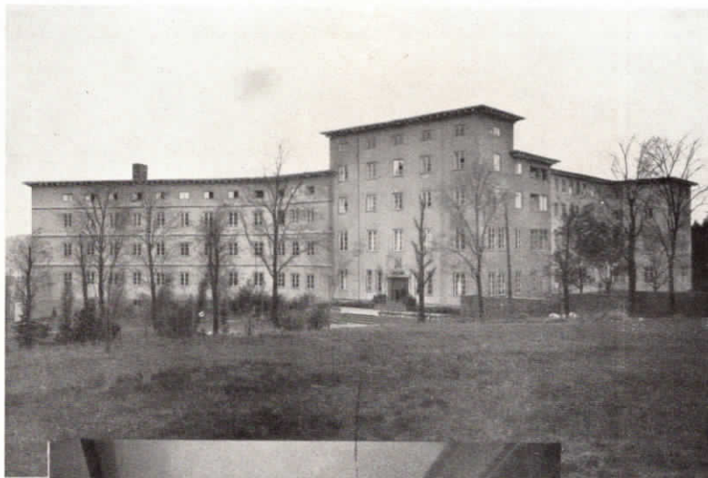
Abb. 74. Das Städtische Krankenhaus in Velbert/Rhld. verfügt über eine ausgedehnte »Fuld«-Fernsprechanlage.
