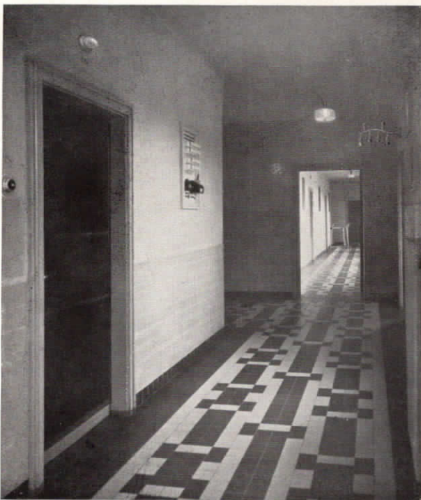
Abb. 47. Flur mit Zimmerlampen und Lichtrufarmatur im St. Marien-Hospital in Mülheim/Ruhr.
