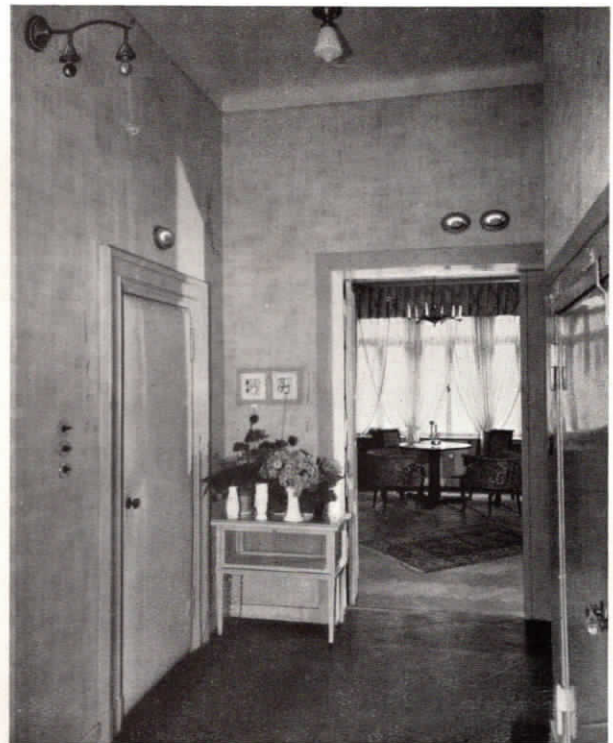
Abb. 58. Flur mit Zimmerlampen, Lichtsignalarmatur und Fernsprechapparat in der Privatklinik Dr. med. Alois Knotte, Essen.
