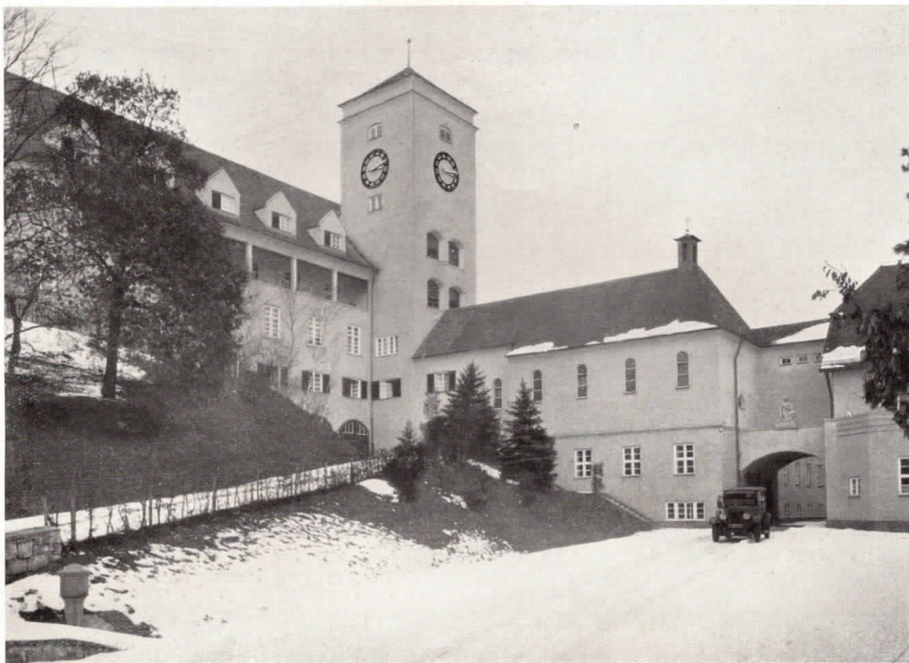
Abb. 115. Teilansicht der Lungenheilstätte in Donaustauf bei Regensburg mit Normalzeit-Turmuhren.
