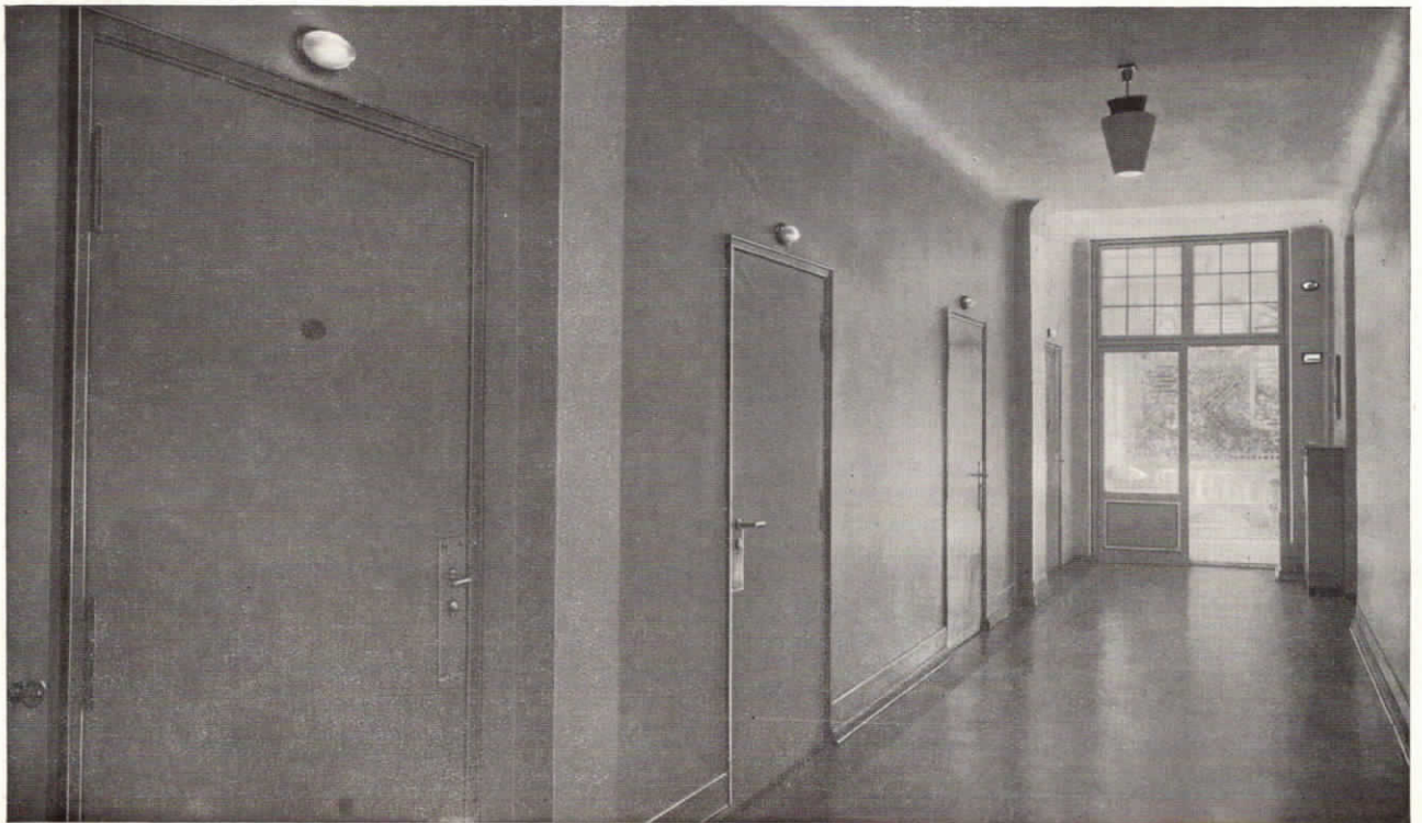
Abb. 86. Flur mit Ruflampen über den Zimmern im Westsanatorium in Berlin.
