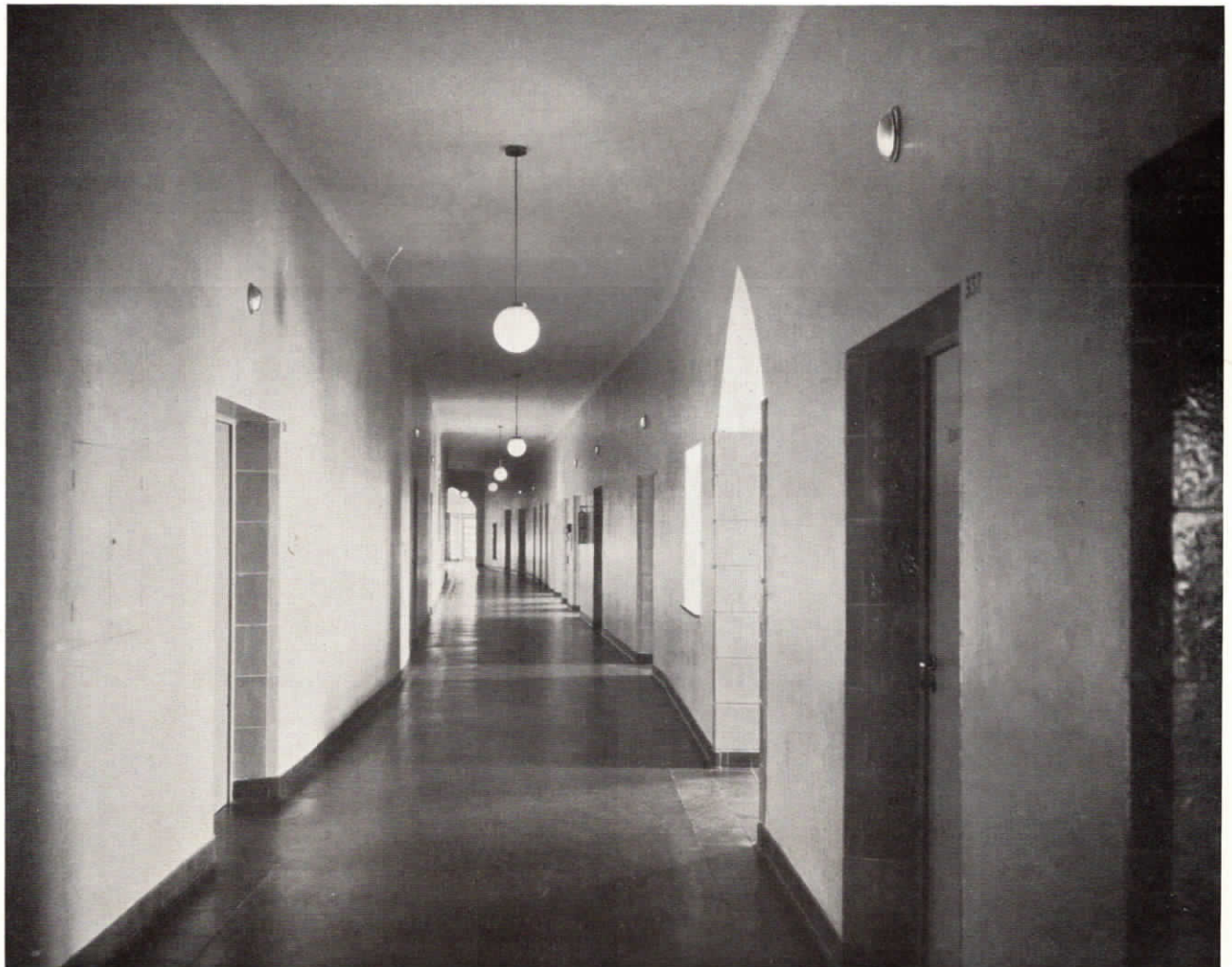
Abb. 84. Flur mit Lichtruflampen über den Türen in der Württembergischen Landeshebammschule in Stuttgart-Berg.
