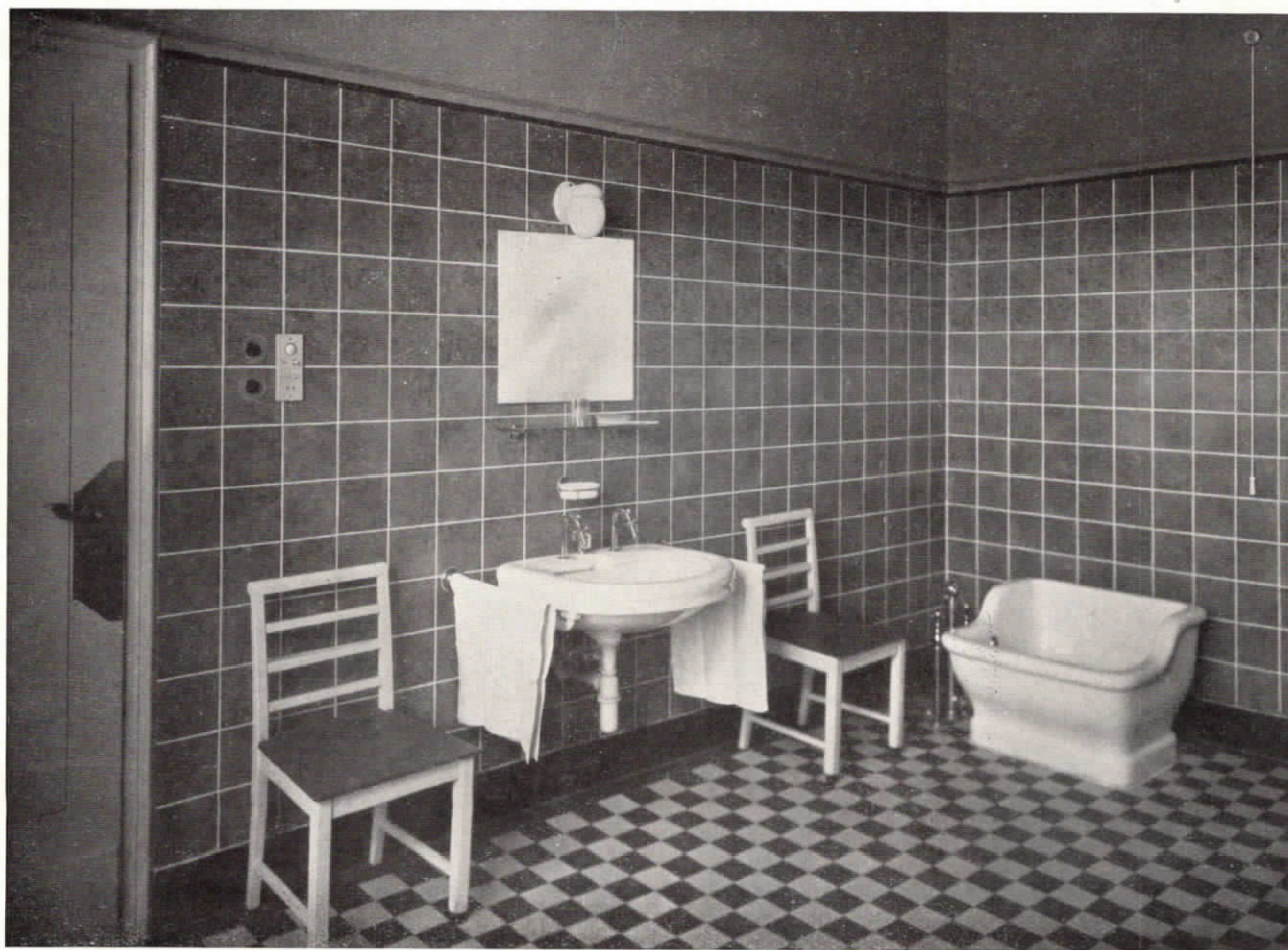
Abb. 112. Badezimmer mit Lichtsignal-Einschalt- und Abstellastatur mit Kontrollampe und Steckbuchsen für den Stecksummer (neben der Türe); ferner Badezugkontakt (an der Sitz-Badewanne) im St. Marien-Hospital in Siegen.
