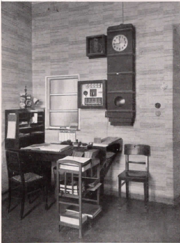
Abb. 8. Normalzeit-Hauptuhr in Spezialgehäuse, sowie Kontaktauflwerk und Ladeschalttafel im Büro des Krankenhauses der Barmherzigen Brüder zu Regensburg (Männerbau).
