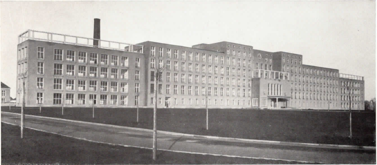
Abb. 45. Das Städtische Krankenhaus in Fürth i. Bay. verfügt über eine umfangreiche »Fuld«-Telefonanlage, bestehend aus einer Glühlampenzentrale für 3 Amtsleitungen und 25 Nebenstellen, sowie einer vollautomatischen Hauszentrale für 100 Teilnehmer. Die »Fuld«-Lichtsignalanlage umfaßt 180 Zimmer; außerdem erhielt das Krankenhaus eine Fernthermometeranlage mit 57 Meßstellen und eine Groß-Rundfunkanlage mit 250 Anschlüssen.
