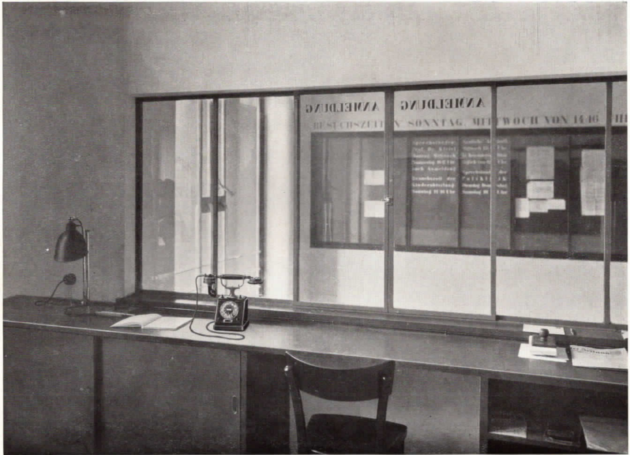
Abb. 2. Portierloge mit »Fuld«-Fernsprechapparat für Post- und Hausverkehr.
