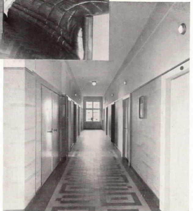
Abb. 82. Flur mit Zimmerlampen für die Lichtrufanlage im Pius-Hospital in Oldenburg.
