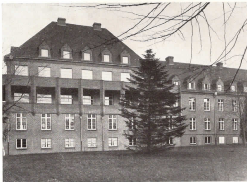
Abb.16. Teilansicht des Kreiskrankenhauses in Nordhorn.
