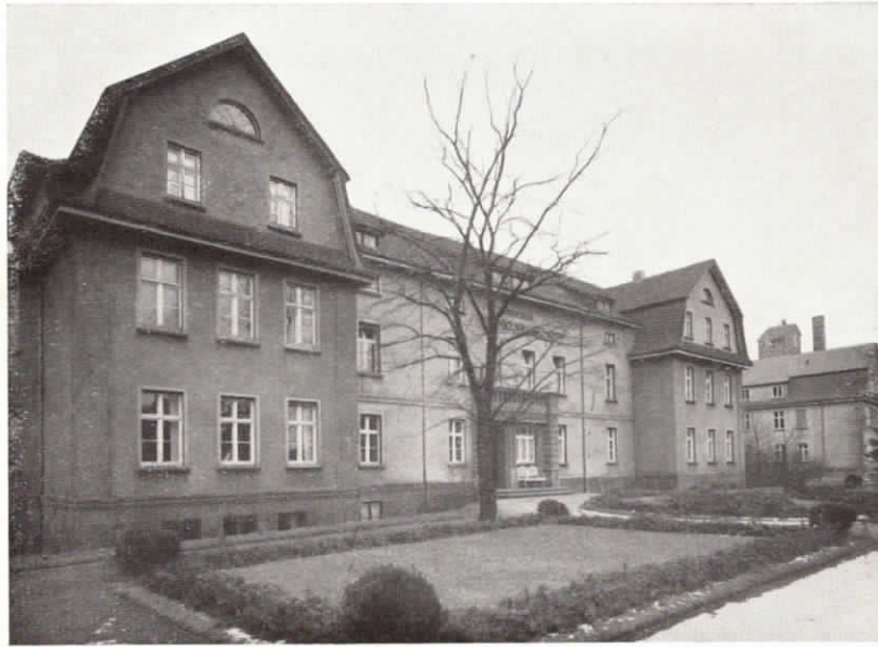
Abb. 23. Das Krankenhaus in Spremberg verfügt über eine Fuld-Fernsprechanlage, bestehend aus einer Reihenanlage, Umschaltschrank für außenliegende Nebenstellen und vollautomatischer Hauszentrale; ferner über eine Fuld-Lichtsignalanlage.
