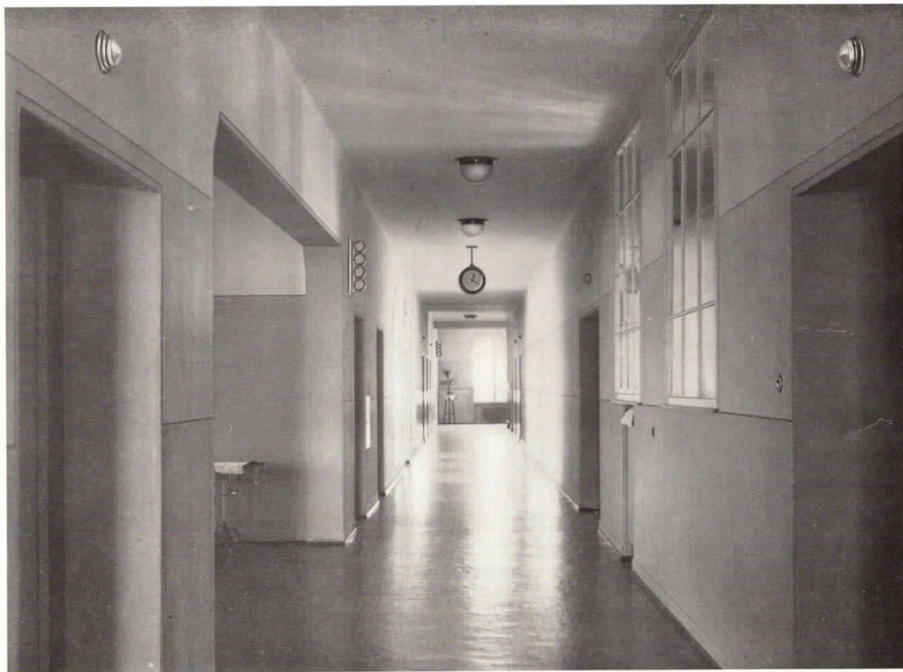
Abb.17. Flur mit »Fuld«-Lichtsignalarmaturen im Kreiskrankenhaus in Nordhorn. Die Lichtsignalanlage erstreckt sich auf 32 Krankenzimmer.
