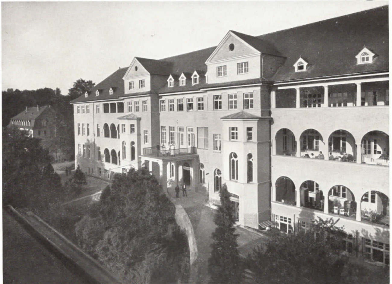
Abb. 109. Das Land-Krankenhaus in Coburg verfügt über eine ausgedehnte Fuld-Fernsprech- und Lichtsignal-Anlage.
