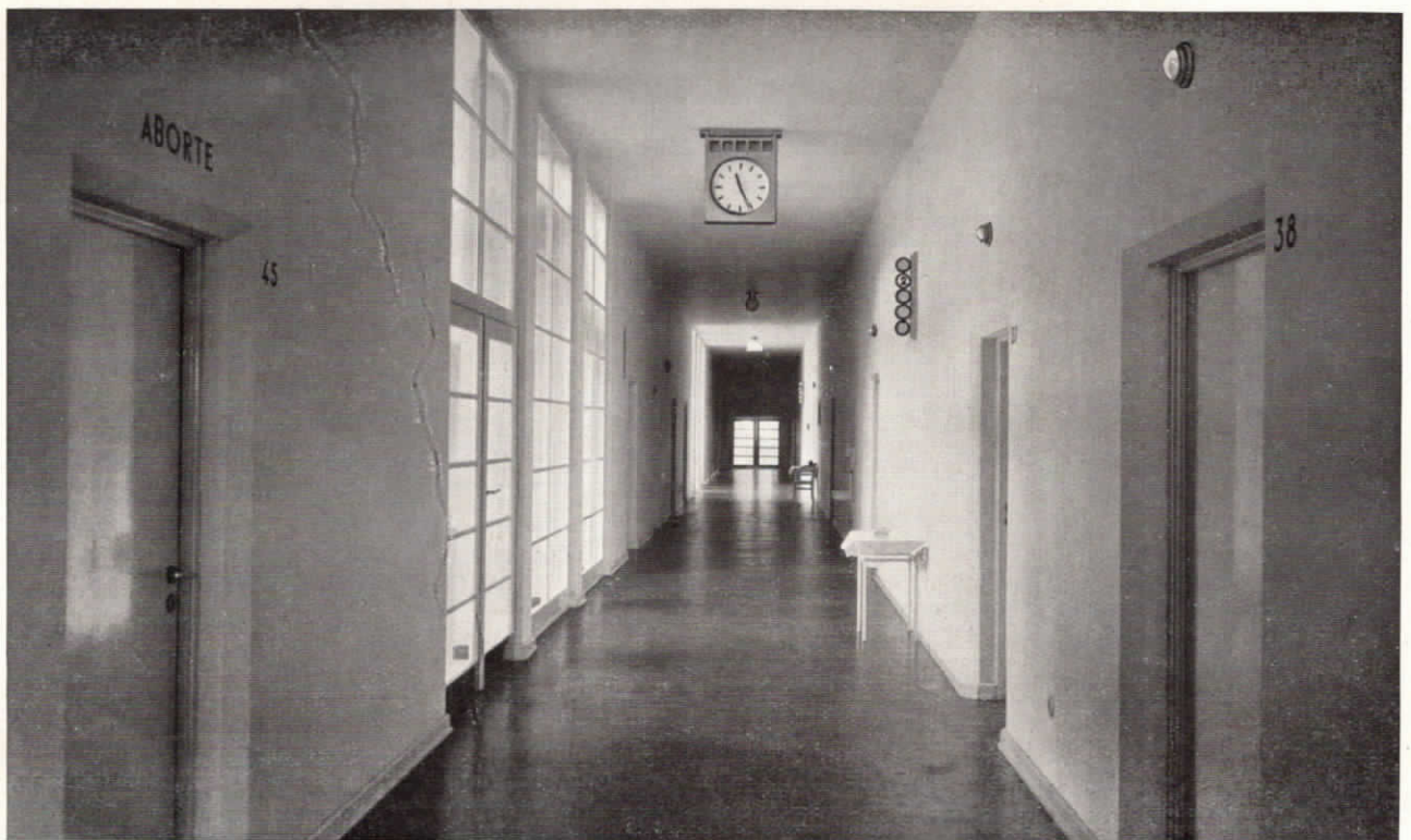
Abb. 20. Flur mit »Fulde«-Lichtsignal-Suchtafel für 5 Personen, kombiniert mit einer doppelseitigen elektrischen Normalzeit-Nebenuhr, Zimmerlampen und Lichtrufarmaturen im Städtischen Krankenhaus Schweinfurt a. M.
