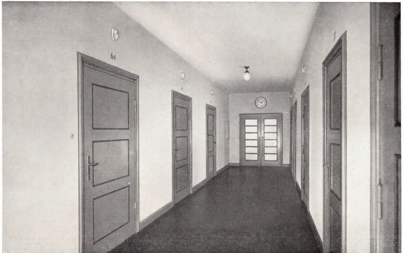
Abb.110. Flur mit Lichtruf-Zimmerlampen und Normalzeit-Nebenuhr im Krankenhaus des Vereins für Krankenpflege in Nürnberg, Hallerwiese.
