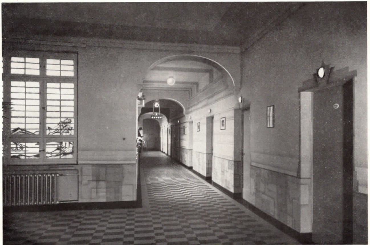
Abb. 114. Flur mit Zimmerlampen und Lichtsignalarmatur im St. Marien-Hospital in Siegen.
