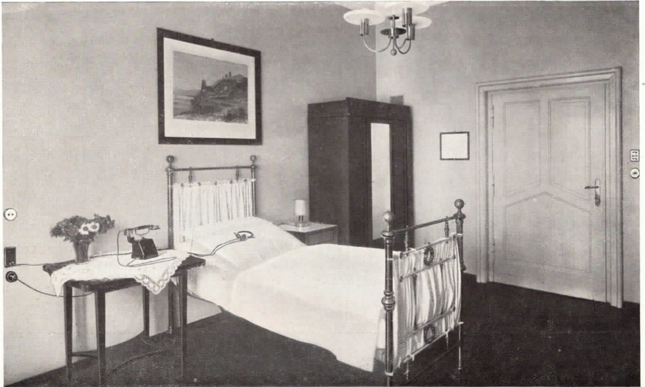
Abb. 85. Krankenzimmer mit Fuld-Fernsprecher, Einschalt-Tastatur für die Lichtruf-Anlage sowie Rundfunkanschluß im Westsanatorium Berlin. Das Westsanatorium besitzt eine Fuld-Fernsprechanlage für 6 Amtsleitungen und 80 Nebenstellen sowie eine vollautomatische Hauszentrale, eine Lichtruf-Anlage für ca. 85 Zimmer, ferner eine gemeinschaftliche Rundfunkanlage für 85 Zimmer.
