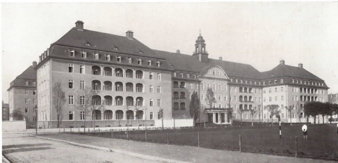
Abb. 59. Das St. Josephs-Krankenhaus in Berlin-Tempelhof wurde mit einer umfangreichen Fuld-Fernsprechanlage, bestehend aus einer Zentrale für 5 Amtsleitungen und 30 Nebenstellen, sowie mit einer vollautomatischen Hauszentrale für 80 Teilnehmer, ferner einer elektrischen Normalzeit-Uhrenanlage, bestehend aus 1 Hauptuhr und 60 Nebenuhren, ausgestattet.
