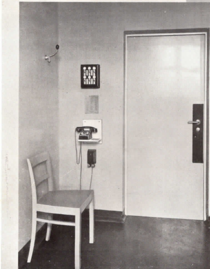
Abb. 71. Einschalttastatur für die Lichtsignalanlage und »Fuld«-Fernsprechapparat im Karl-Olga-Krankenhaus in Stuttgart.
