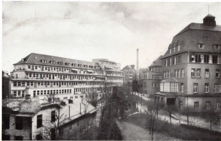
Abb. 66. Das Karl-Olga-Krankenhaus in Stuttgart verfügt über eine ausgedehnte »Fuld«-Fernsprechanlage, bestehend aus einer Glühlampenzentrale für 3 Amtsleitungen und 50 Nebenstellen, sowie aus einer vollautomatischen Hauszentrale für 70 Teilnehmer, ferner über Lichtsignalanlagen, Rundfunkanlage für 128 Anschlüsse und eine Normalzeit-Uhrenanlage, bestehend aus einer Hauptuhr und 9 Nebenuhren.
