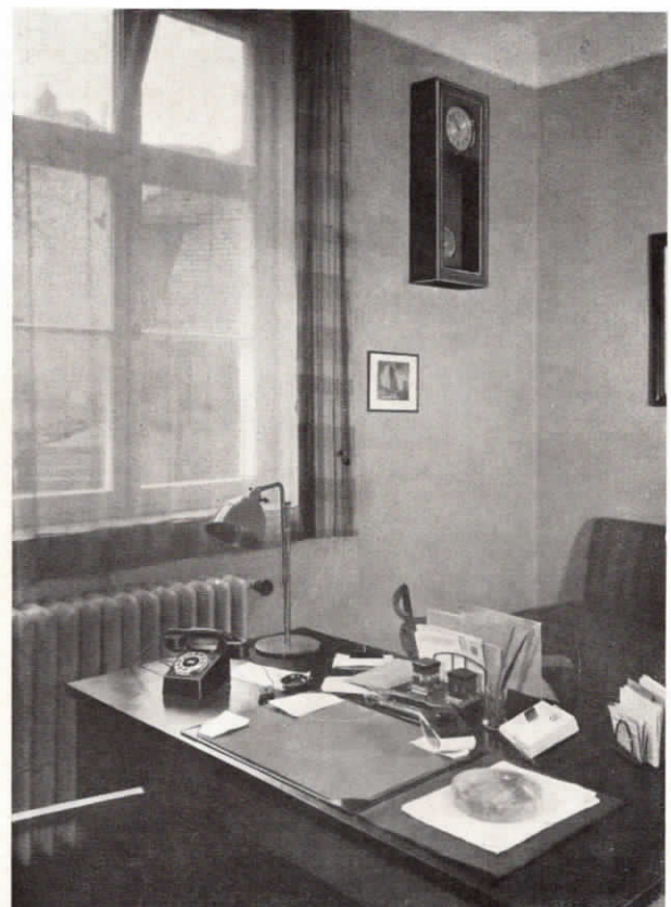
Abb. 68. Büro mit »Fuld«-Fernsprecher und Normalzeit-Hauptuhr im Karl-Olga-Krankenhaus in Stuttgart.
