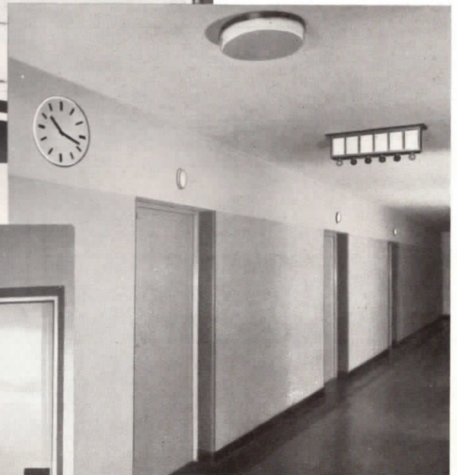
Abb. 70. Flur mit Zimmerlampen und Richtungsarmatur für 6 Abteilungen sowie eingebaute Normalzeit-Nebenuhr im Karl-Olga-Krankenhaus in Stuttgart.
