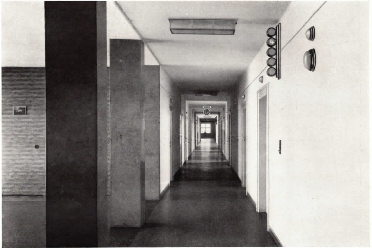
Abb. 6. Flur mit Fuld-Lichtruf-Armaturen, ferner Zimmerlampen für Einfarbenruf und Notbeleuchtung; im Hintergrund Suchsignal-Tablo, kombiniert mit doppelseitiger elektrischer Normalzeit-Uhr, im Krankenhaus der Barmherzigen Brüder in Regensburg (Männerbau).
