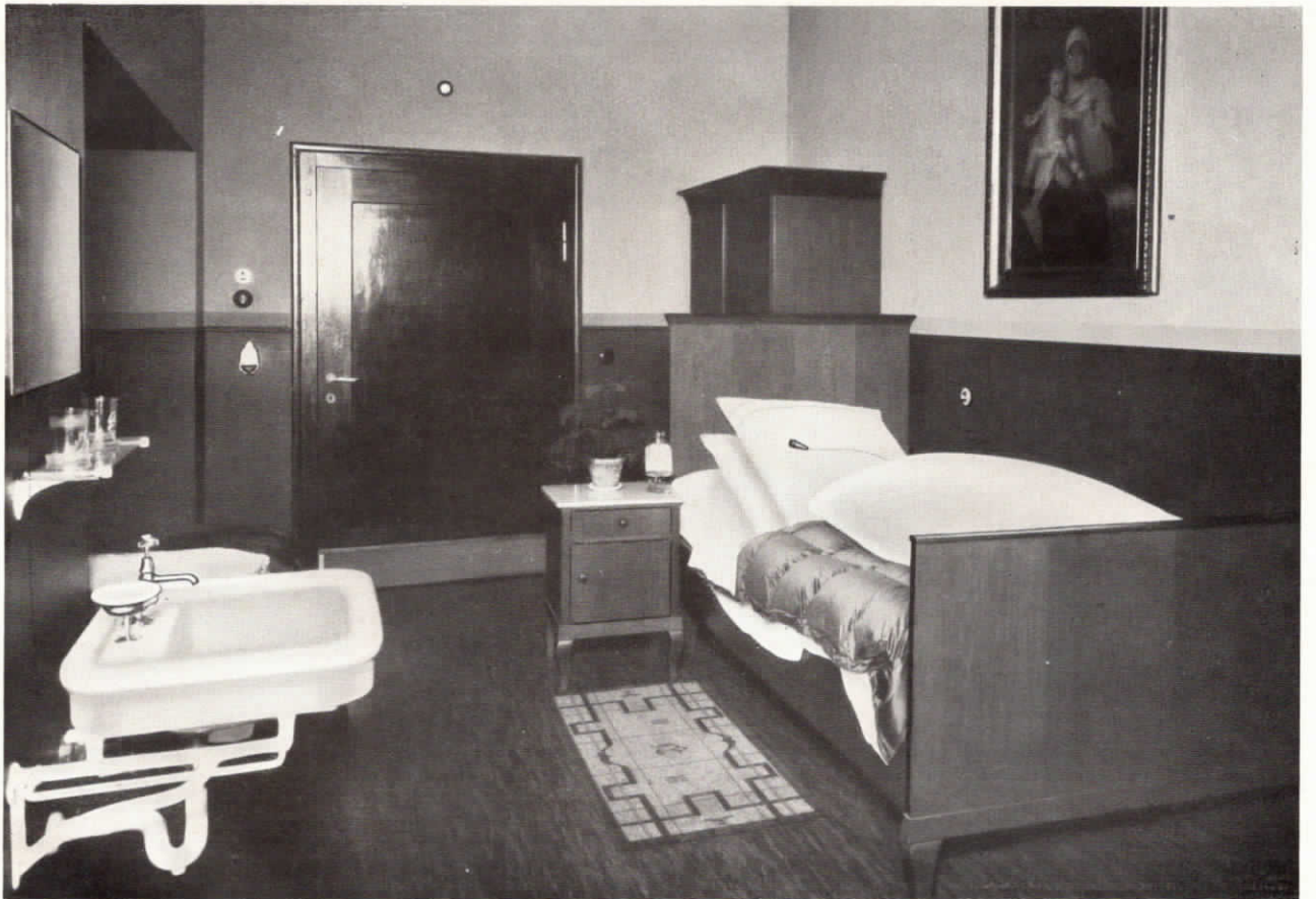
Abb. 91. Krankenzimmer mit Ruf- und Abstelltaster für die Lichtrufanlage im Städtischen Krankenhaus in Attendorn.
