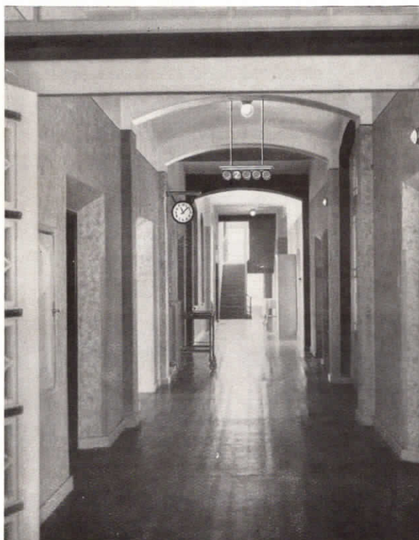
Abb. 72. Flur im Städtischen Krankenhaus in Wilhelmshaven mit Zimmerlampen, Lichtrufarmatur und doppel-seitiger Normalzeit-Nebenuhr.
