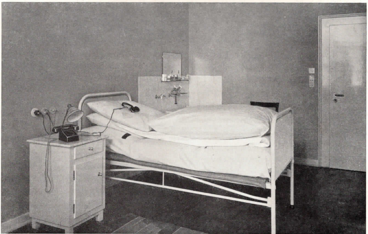
Abb. 22. Krankenzimmer mit »Fuld«-Fernsprechapparat, Birntaster zum Einschalten der Lichtrufanlage (Schwesternruf), Kopfhörer für Rundfunk; links von der Türe kombinierte Ein- und Ausschaltastatur mit Kontrollampe und Steckbuchsen für den Stecksummer im Städtischen Krankenhaus in Schweinfurt a. M.
