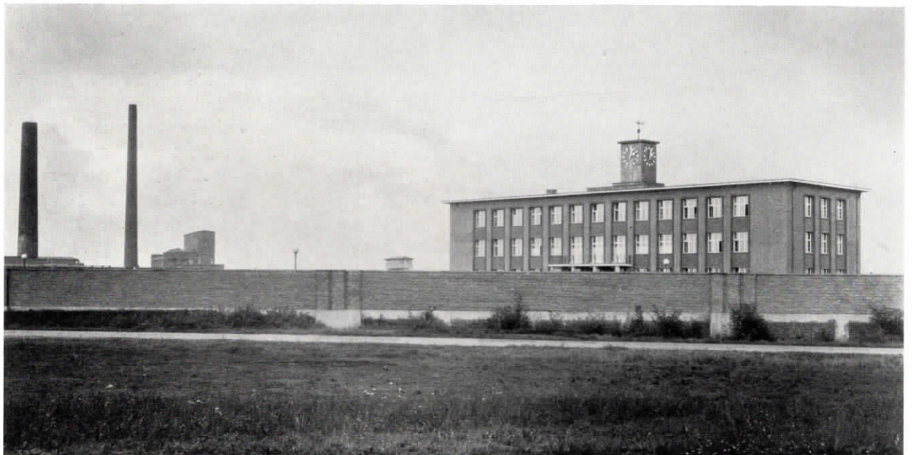
Abb. 9. Vierseitige Normalzeit-Turmuhr mit freigehenden Zeigern auf dem Verwaltungsgebäude der Glanzstoff-Courtaulds G. m. b. H., Köln-Merheim. Das Werk verfügt ferner über eine Signal-Hauptuhr, 13 doppelseitige und 31 einseitige Nebenuhren und außerdem über 16 Arbeitszeitkontroll-Apparate. Eine Feuermeldezentrale mit 7 örtlichen Feuermeldern vervollständigt die Fernmeldeanlage.
