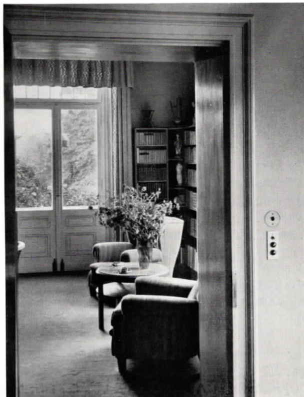
Abb. 65. Lichtruftablos in einer Villa bei Erkrath. Die Signalanlage besteht aus 12 Lichtruftablos mit den erforderlichen Signalgebern, Hupenanlage für Diener- und Gärtner, Hupenanlage für Herrschaftsruf, Zimmerlichtsignalanlage mit akustischem Ruf, Stockwerkssignallampen.
