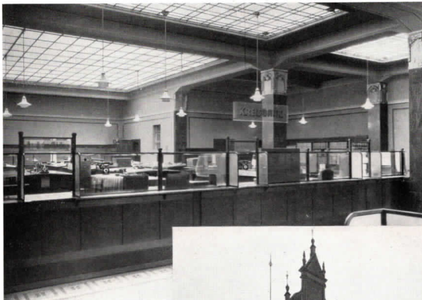
Abb. 74 (oben). Schalterraum der Kreis-Sparkasse Krefeld. Die Fernsprechanlage in der Kreissparkasse besteht aus einer Fuld-Glühlampenzentrale für 6 Amtsleitungen und 15 Nebenstellen, sowie einer vollautomatischen Fuld-Hauszentrale für 25 Teilnehmer.
