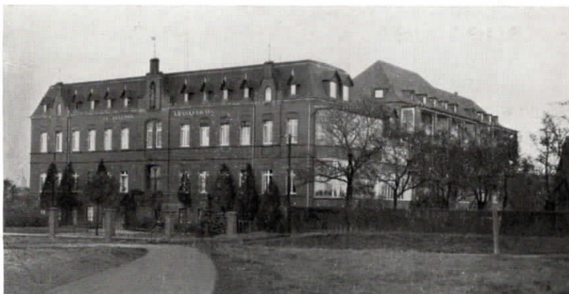
Abb. 97. Das St.-Josephs-Krankenhaus in Moers besitzt eine Fuld-Fernsprech-Reihenanlage.
