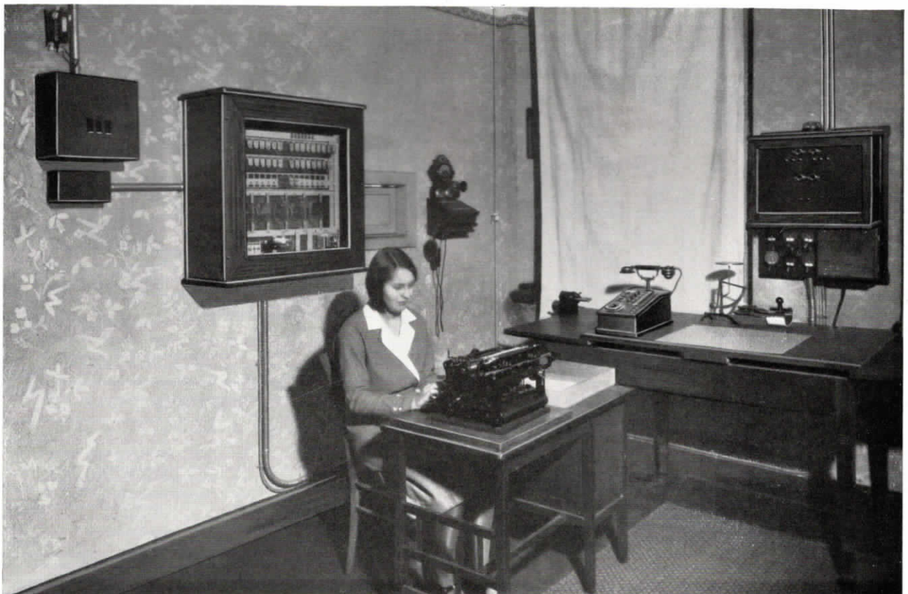
Abb. 84. Fuld-Fernsprechzentrale im Rathaus Kempen. Die Fernmeldeanlage besteht aus einer Fuld-Reihenanlage für 2 Amtsleitungen, einem Umschaltschrank für 3 außenliegende Nebenstellen zur Wohnung des Bürgermeisters, der Polizei und der Sparkasse. Dem internen Verkehr dient eine vollautomatische Zentrale für 23 Teilnehmer.
