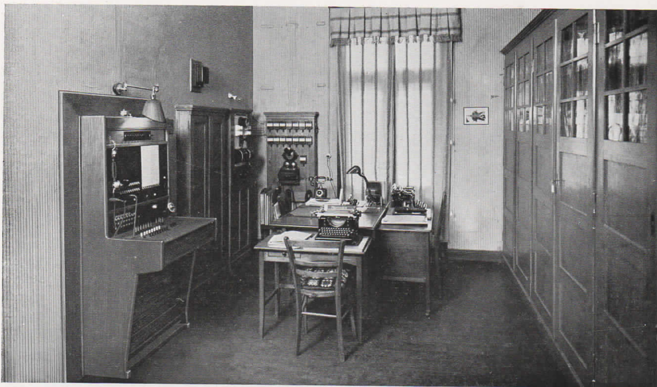
Abb. 28. Fuld-Fernsprech-Glühlampenzentrale im Landratsamt in Burgsteinfurt
