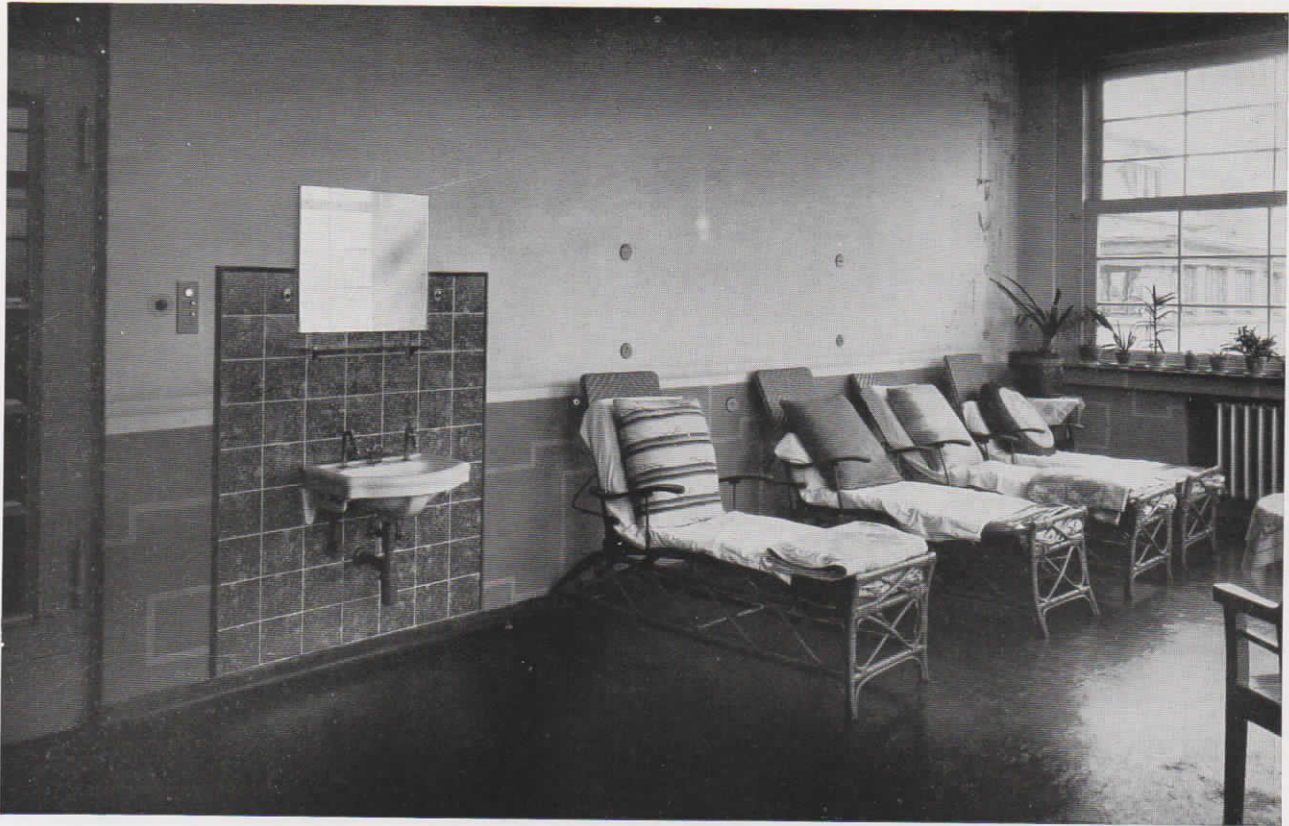
Abb. 67. Liegehalle mit Lichtsignal-Einschalt- und Abstellastatur mit Kontrollampe und Steckbuchsen für den Stecksummer (neben der Türe); ferner Ruftaster mit Steckbuchsen für Birntaster an den Liegestühlen, im St. Marien-Hospital in Siegen
