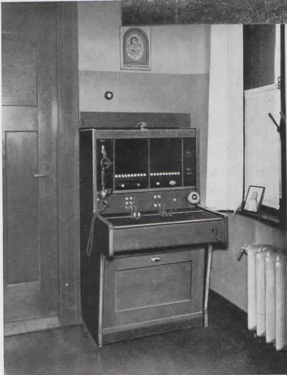
Abb. 21. »Fulde«-Glühlampenzentrale im St. Josefs-Hospital in Bochum
