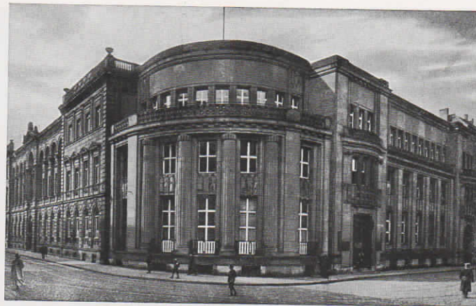
Abb. 52. Der Barmer Bankverein in Wuppertal-B. besitzt eine ausgedehnte Fuld-Fernsprechanlage, bestehend aus halbautomatischer Nebenstellenzentrale für 10 Amtsleitungen und 50 Nebenstellen und einer vollautomatischen Hauszentrale mit 70 Anschlüssen
