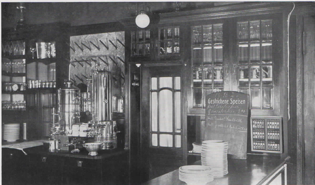
Abb. 6. Einschaltastatur für die Lichtsignal-Kellnerrufanlage im Restaurant Nordstern der Unionbrauerei A.-G. in Dortmund
