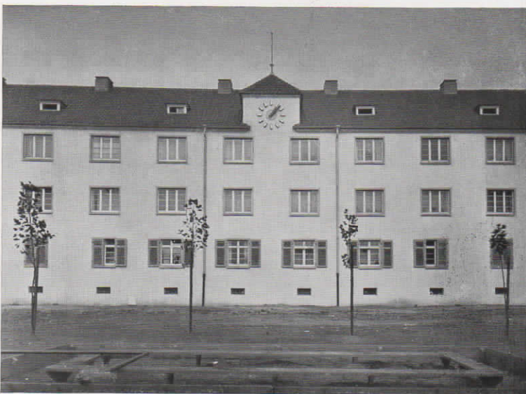
Abb. 37. Siedlung Buer-Luggendelle mit Normalzeit-Turmuhre (1,5 m \odot )
