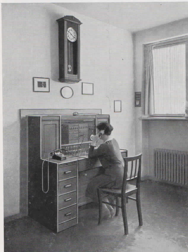
Abb. 22. Bedienungstisch in Schreibtischform der halbautomatischen Fuld-Nebenstellen-Zentrale für 10 Amtsleitungen und 75 Nebenstellen und 3 Querverbindungen beim Siedlungsverband Ruhrkohlenbezirk Essen. An der Wand Normalzeit-Hauptuhr
