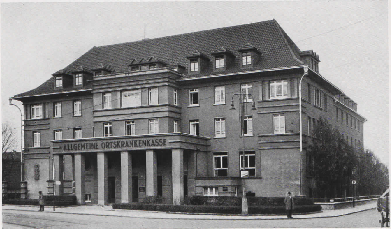
Abb. 40. Allgemeine Ortskrankenkasse in Bielefeld. Dem Fernsprechverkehr dient eine Fuld-Glühlampen-nebenstellen-Zentrale für 3 Amtsleitungen und 15 Nebenstellen, sowie eine vollautomatische Zentrale für 50 Anschlüsse; außerdem befindet sich hier eine Fuld-Lichtsignal- und eine Normalzeit-Uhrenanlage
