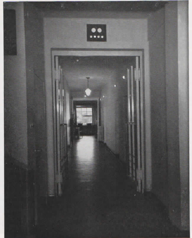
Abb. 61. Flur mit Zimmerlampen und Lichtsignaltafeln im Städt. Krankenhaus St. Franziskus-Hospital, Eitorf
