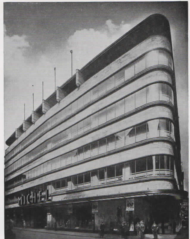
Abb. 51. Das Kaufhaus Michel & Co. A.-G. in Wuppertal-E. verfügt über eine umfangreiche Fuld-Fernmeldeanlage. Sie umfaßt eine Fernsprechanlage, bestehend aus automatischer Hauszentrale für 100 Teilnehmer und eine Glühlampenzentrale für 4 Amtsleitungen und 25 Nebenstellen, eine Personensuchanlage für 6 Personen, eine elektrische Uhrenanlage, sowie eine Feuermeldeanlage
