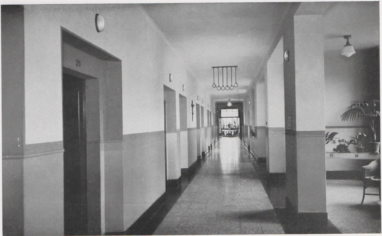
Abb. 65. Flur im Städtischen Krankenhaus in Attendorn, mit Zimmerlampen und Lichtsignalarmatur. Die Lichttrufanlage umfaßt 84 Zimmer, einschl. Bäder
