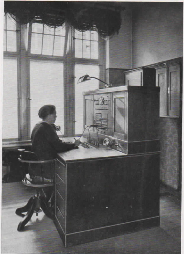
Abb. 29. Bedienungsschrank in Schreibtischform der Fuld-Nebenstellen-Zentrale für 8 Amtsleitungen und 50 Nebenstellen in der Essener Volks-Zeitung, Freda-Beul & Koenen, Essen. Dem Hausverkehr dient eine vollautomatische Fuld-Zentrale mit 70 Anschlüssen. Ferner befindet sich hier eine Fuld-Lichtsignalanlage sowie eine Normalzeit-Uhrenanlage
