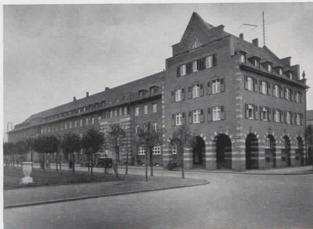
Abb. 13. Das Finanzamt in Oberhausen arbeitet mit einer Fuld-Fernsprech-Anlage mit 30 Sprechstellen
