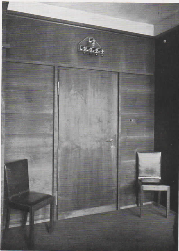
Abb. 28. Fuld-Lichtsignalarmatur mit 5 Lampen in einem Arbeitsraum des Allgemeinen Bauvereins Essen A.-G.
