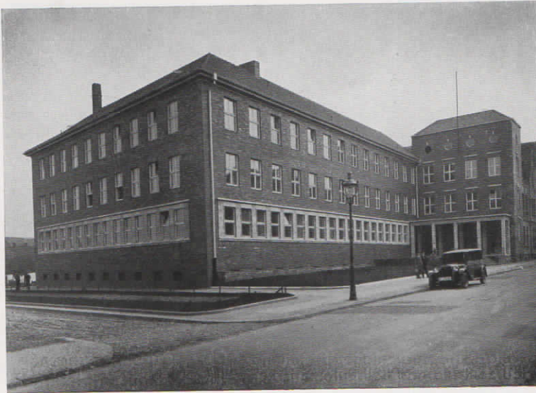
Abb. 16. Das Arbeitsamt in Bottrop verfügt über eine Fuld-Universal-Zentrale mit ca. 20 Sprechstellen
