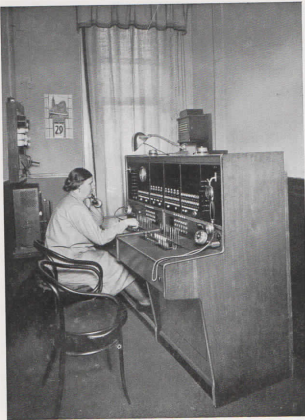
Abb. 11. Die Westfälische Transport-Aktiengesellschaft in Dortmund verfügt über eine Fuld-Glühlampenzentrale für 10 Amtsleitungen und 50 Nebenstellen sowie über eine vollautomatische Fuld-Hauszentrale mit 50 Anschlüssen
