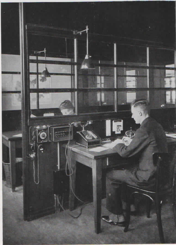
Abb. 17. Bedienungsapparat der Fuld-Universalzentrale im Arbeitsamt Bottrop
