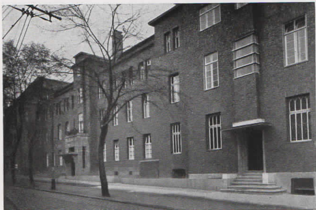
Abb. 53. Das St. Marien-Hospital in Mülheim/Ruhr besitzt eine ausgedehnte »Fuld«-Fernsprechanlage, bestehend aus einer Glühlampenzentrale für 3 Amtsleitungen und 20 Nebenstellen, sowie einem Vollautomaten für den Hausverkehr für 70 Teilnehmer, ferner eine Lichtsignalanlage und eine elektrische Normalzeit-Uhrenanlage, bestehend aus einer Hauptuhr und 10 Nebenuhren
