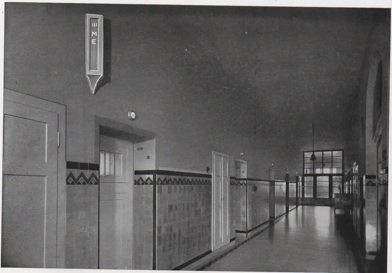
Abb. 25. Flur mit Zimmerlampen und Dreiecktablo im St. Johannis-Hospital in Dortmund
