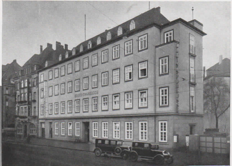
Abb. 36. Die Fuld-Fernsprechanlage der Kreissparkasse Bielefeld umfaßt eine halbautomatische Nebenstellenzentrale für 4 Amtsleitungen und 20 Nebenstellen, eine vollautomatische Hauszentrale mit 30 Anschlüssen, zwei fahrbare Fernsprechapparate Modell „Pufu“, zwei Vorschaltapparate und einen Münzfernsprecher
