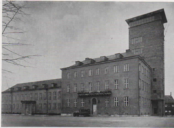
Abb. 14. Das Rathaus in Velbert. Dem Fernspreverkehr dient eine Fuld-Fernsprechanlage, bestehend aus automatischer Hauszentrale und halbautomatischer Nebenstellenzentrale
