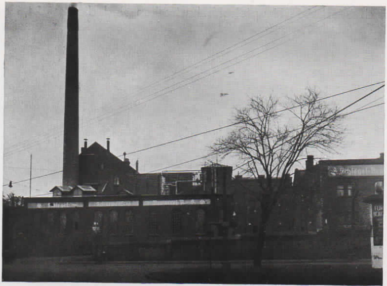
Abb. 36. Die Schlegel-Scharpenseel-Brauerei A.-G. in Recklinghausen verfügt über eine Fuld-Fernsprechanlage mit 15 Anschlüssen für Post- und Hausverkehr
