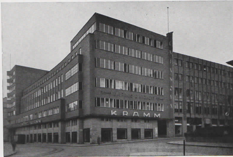
Abb. 38. Im Möbelhaus J. Kramm in Essen befindet sich eine Fuld-Glühlampen-Zentrale für 4 Amtsleitungen und ca. 40 Sprechstellen, ferner eine Fuld-Personensuchanlage nach dem Zeigersystem
