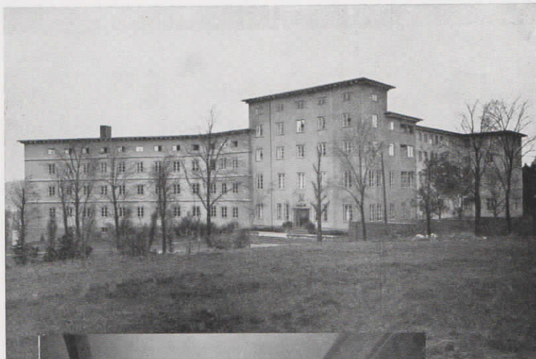
Abb. 47. Das Städtische Krankenhaus in Velbert/Rhld. verfügt über eine ausgedehnte »Fuld«-Fernsprechanlage
