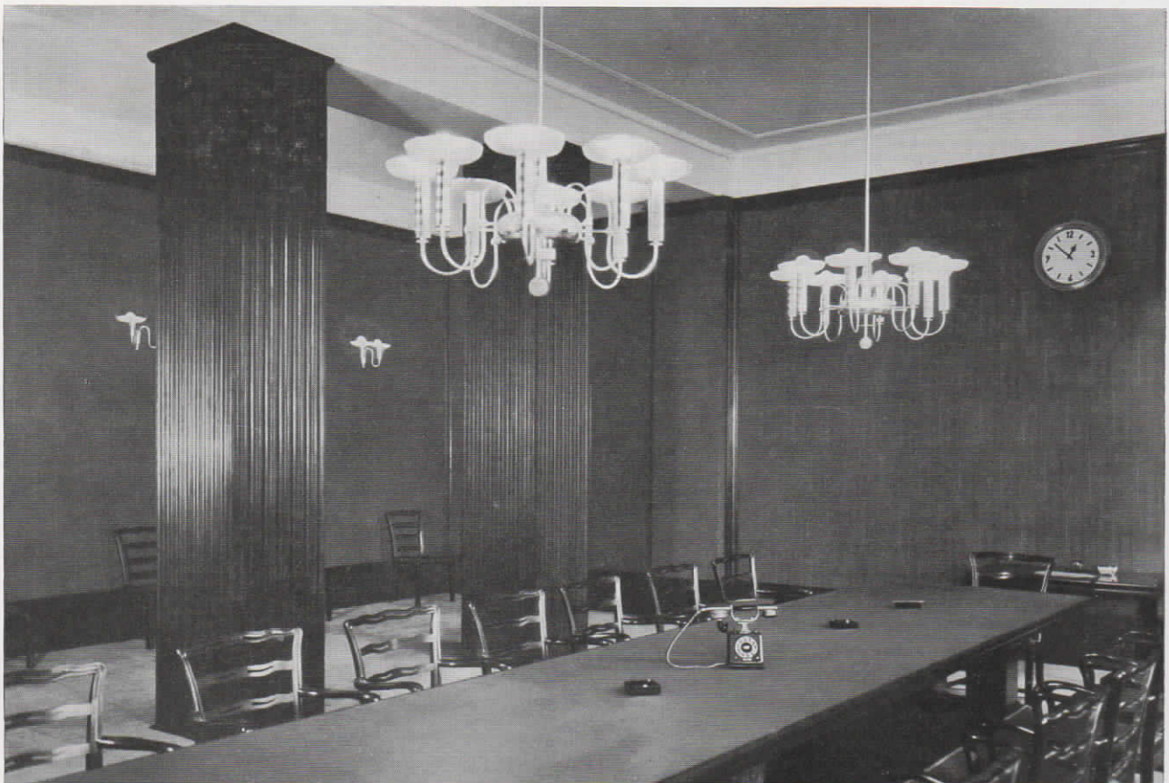
Abb. 2. Sitzungssaal der Stadtparkasse in Bochum (im Rathaus) mit Fuld-Fernsprecher und Normalzeit-Nebenuhr. Die Fernsprechanlage besteht aus einer halbautomatischen Fuld-Nebenstellen-Zentrale für 3 Amtsleitungen und 20 Nebenstellen
