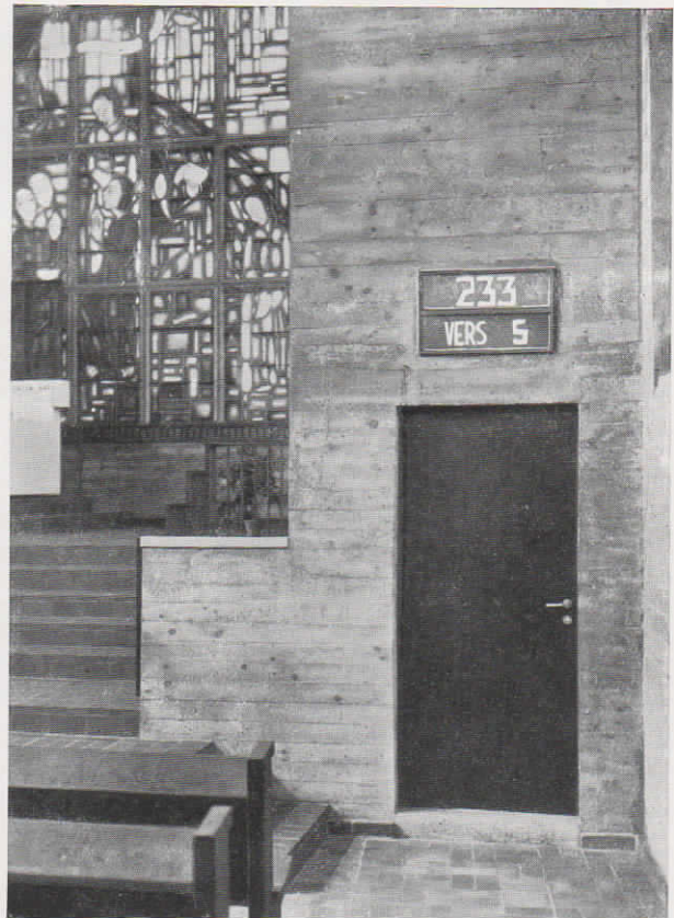
Abb. 2. Liederanzeiger mit elektrisch auswechselbaren Zahlen in der neuen evgl. St. Nikolai-Kirche in Dortmund
