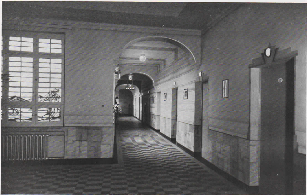
Abb. 68. Flur mit Zimmerlampen und Lichtsignalarmatur im St. Marien-Hospital in Siegen
