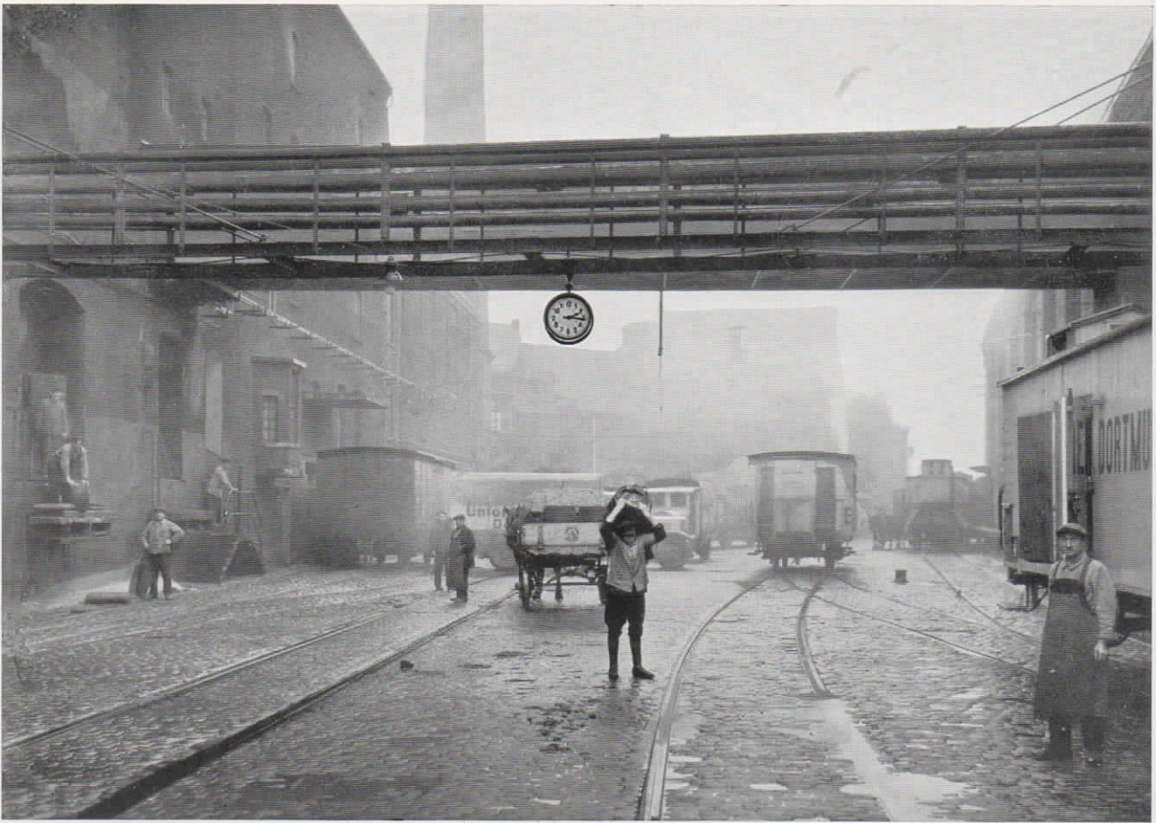
Abb. 5. Transparente doppelseitige Normalzeit-Nebenuhr im Hofe der Unionbrauerei in Dortmund
