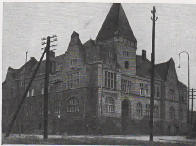
Abb. 6. Rathaus Castrop-Rauxel. Hier befindet sich eine Fuld-Fernsprech-Anlage, bestehend aus Glühlampenzentrale für 8 Amtsleitungen und 80 Nebenstellen sowie einer vollautomatischen Zentrale mit 80 Anschlüssen
