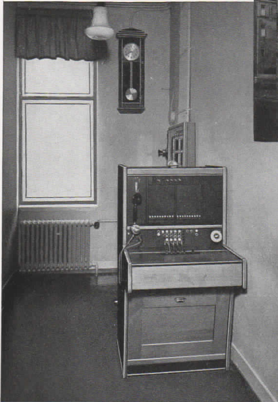
Abb. 37. Bedienungsschrank der halbautomatischen Fuld-Nebenstellenzentrale und Normalzeit-Hauptuhr in der Kreissparkasse in Bielefeld
