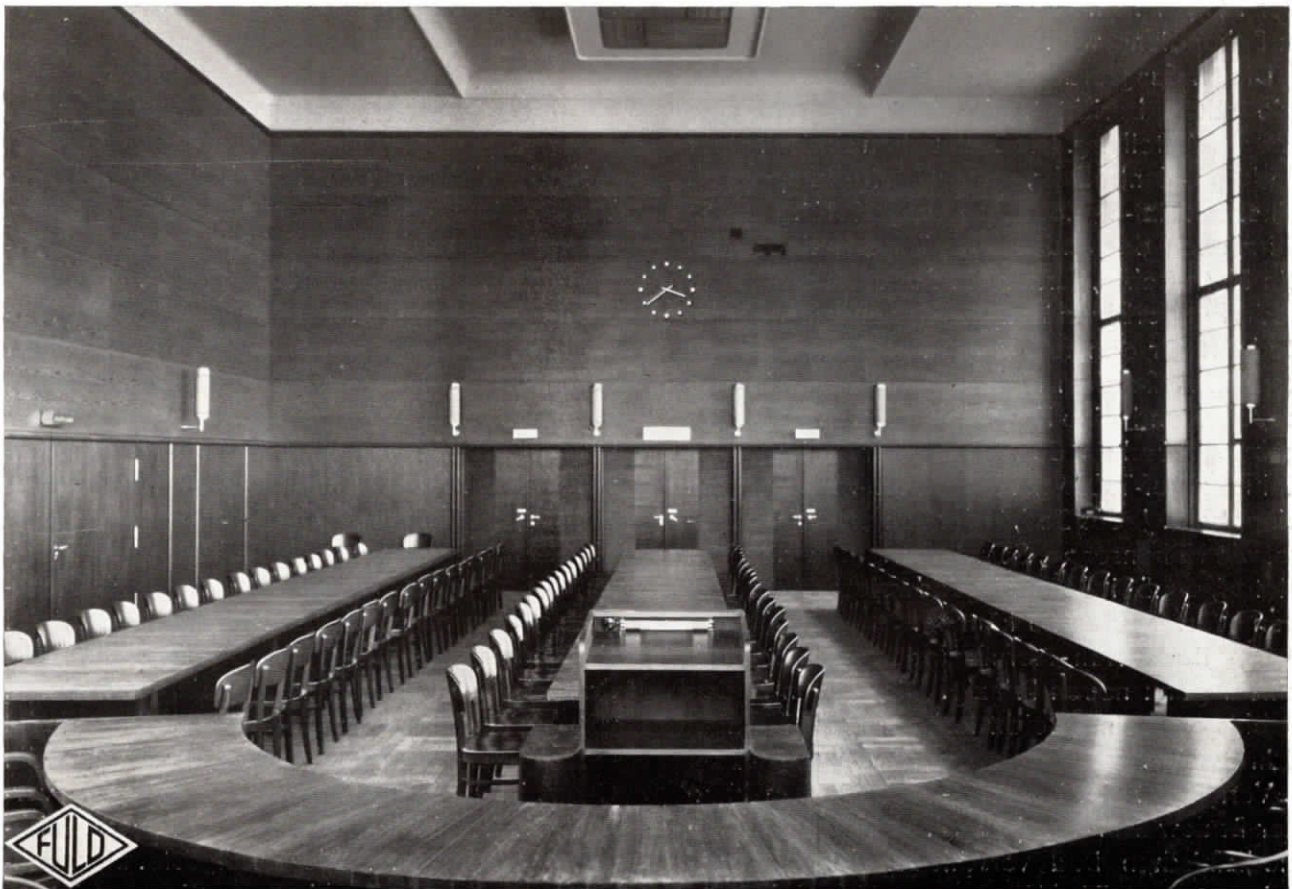
Abb. 19. Sitzungssaal mit eingebauter Normalzeit-Nebenuhr in der Allg. Ortskrankenkasse in Chemnitz
