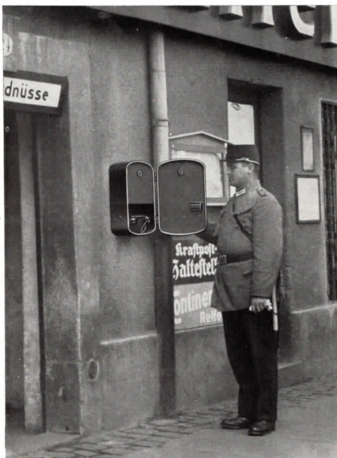
Abb. 4. Polizeistraßenmelder mit Fernsprecheinrichtung
