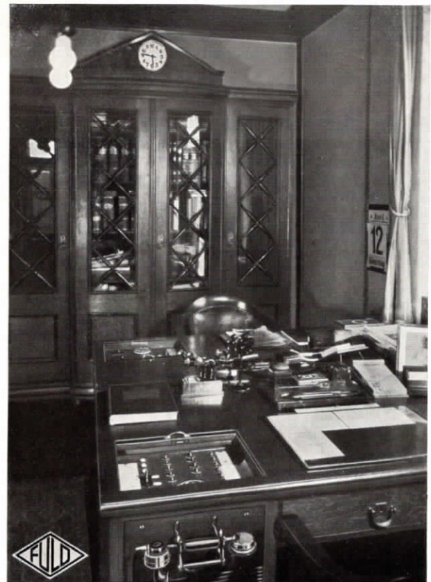
Abb. 28. Direktionszimmer mit in den Schreibtisch eingebauter Fuld-Fernsprech-Apparatur, ferner in den Bibliothekschrank eingelassener Normalzeit-Nebenuhr
