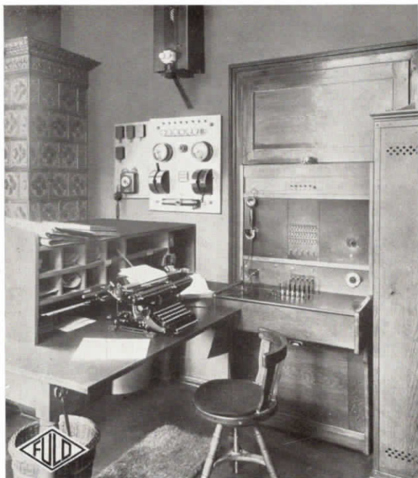
Abb. 5. Fuld-Halbautomatenzentrale, Ladeschalttafel und Gleichrichter im Städt. Schlacht- und Viehhof in Chemnitz
