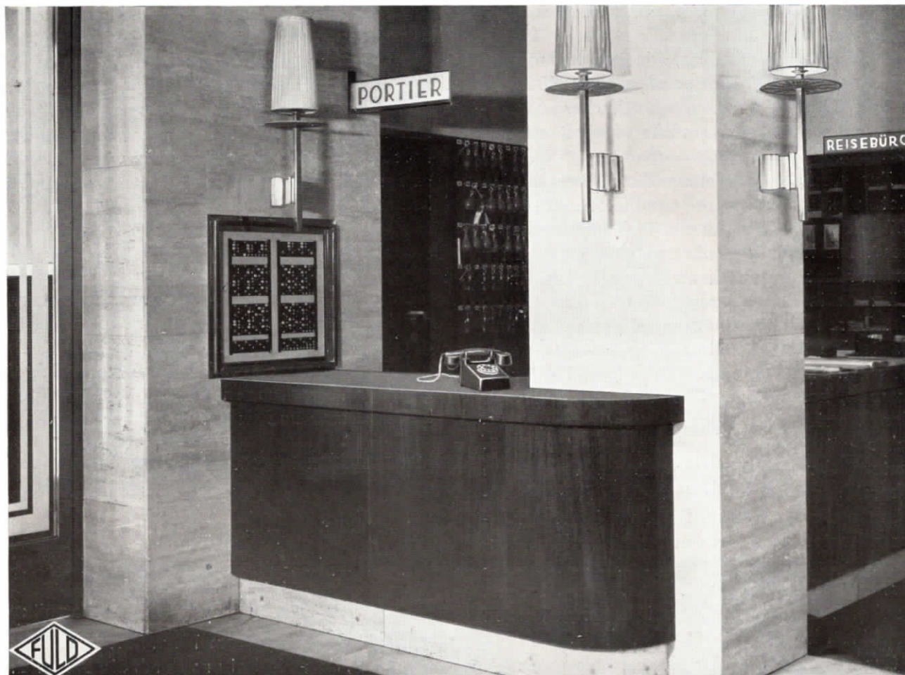
Abb.22. Portierloge mit Haupttablo zur Überwachung der Rufe aus den Gästezimmern mit 600 Kontrolllampen, ferner Fuld-Fernsprecher im Hotel Chemnitzer Hof in Chemnitz
