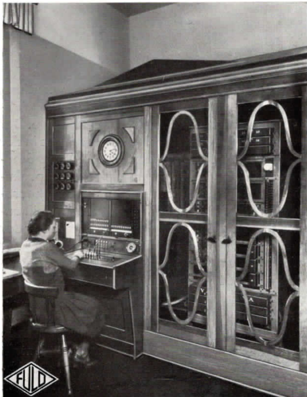
Abb. 18. Fuld-Glühlampenzentrale für 5 Amtsleitungen und 30 Nebenstellen, ferner vollautomatische Fuld-Hauszentrale, ausgebaut für 30 Teilnehmeranschlüsse
