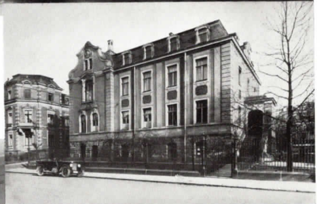
Abb. 27. Bild rechts Das Gebäude der Amtshauptmannschaft in Oelsnitz i.V.
