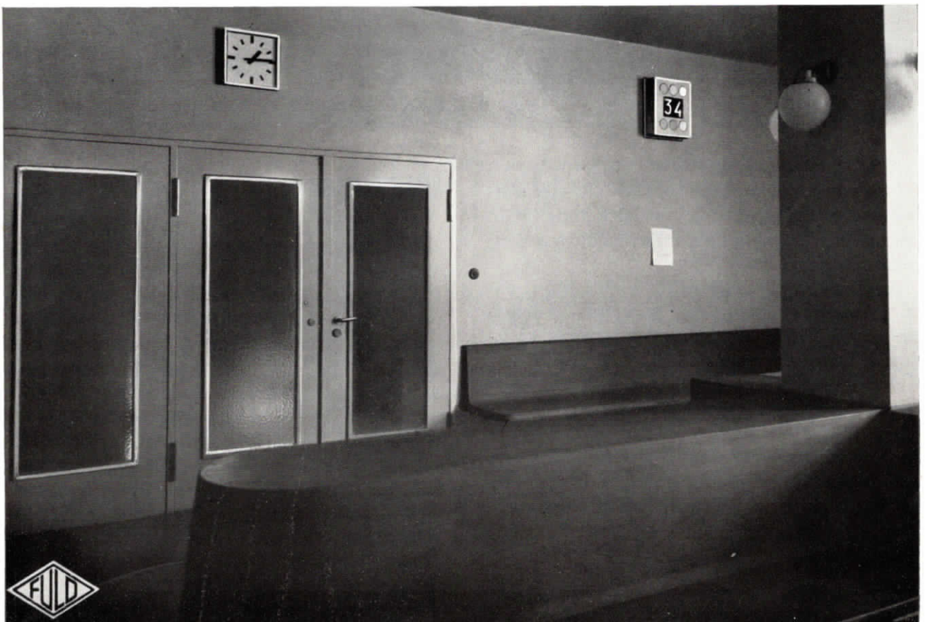
Abb. 13. Warteraum in der Badeanstalt der Allg. Ortskrankenkasse in Chemnitz mit optischer Zahl- und Badeart-Abrufanlage, ferner eingebauter Normalzeit-Nebenuhr
