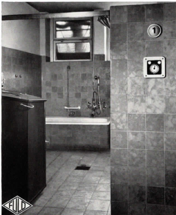
Abb. 14. Badekabine mit Zugkontakt für Notruf, Badezeitkontrolluhr und Notruflampe in der Allg. Ortskrankenkasse in Chemnitz
