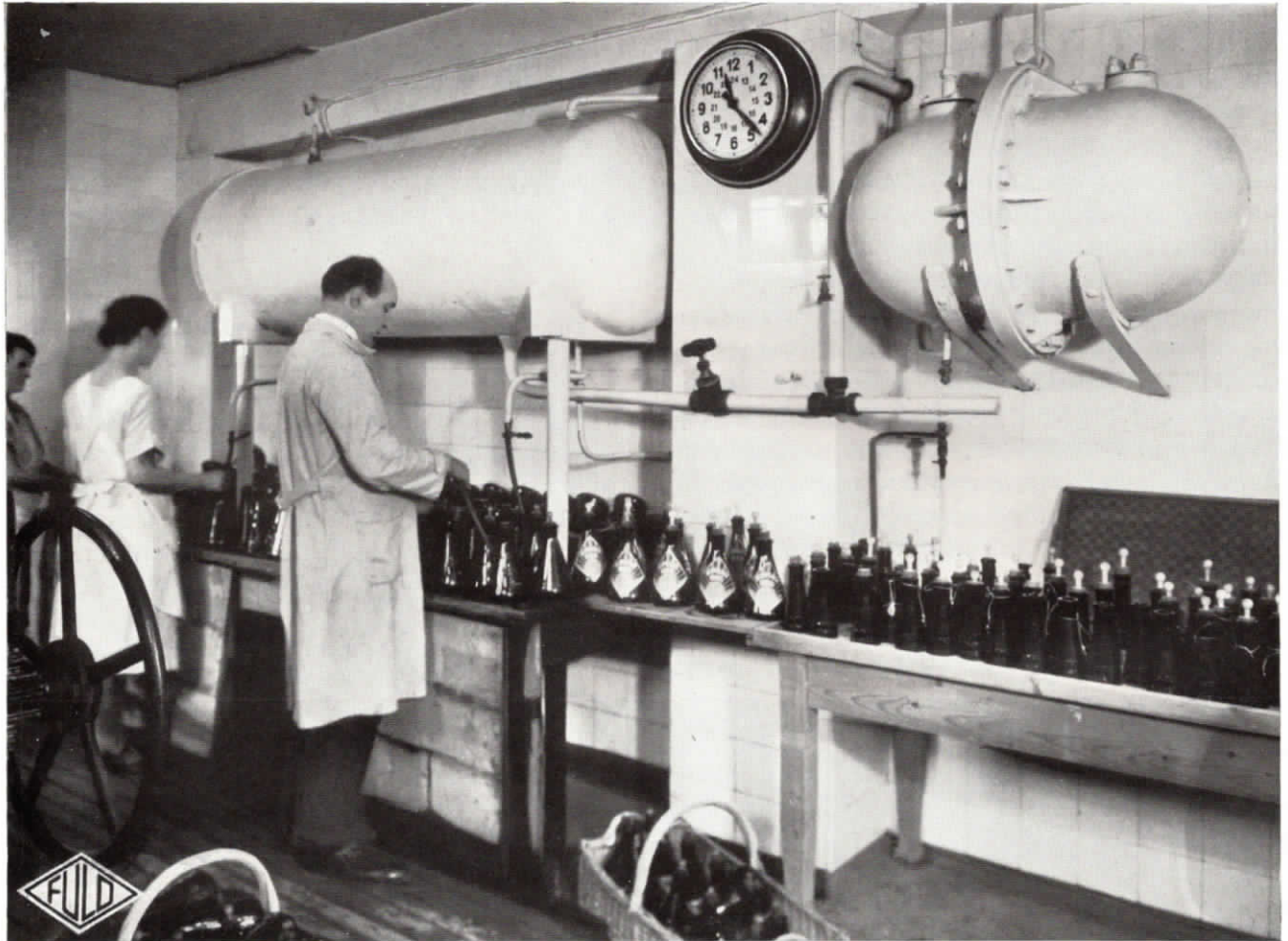
Abb. 33. Abfüllraum mit elektrischer Normalzeit-Nebenuhr im Kurhaus des Radiumbades Oberschlema
