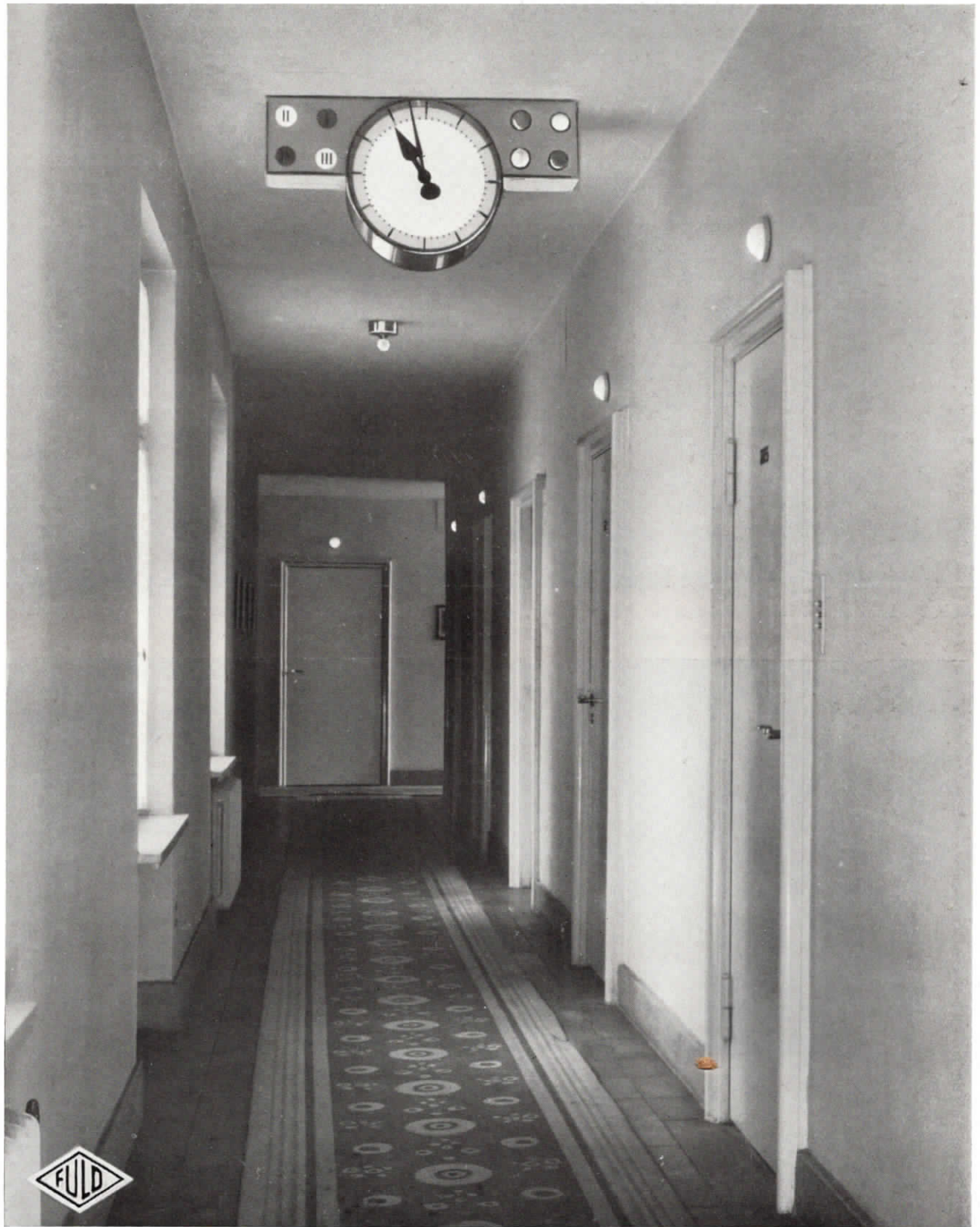
Abb. 23. Flur mit Zimmerlampen über den Türen, ferner doppelseitigen Richtungs-Etagenlampen kombiniert mit doppelseitiger transparenter Normalzeit-Nebenuhr in Spezialausführung im Hotel Chemnitzer Hof in Chemnitz
