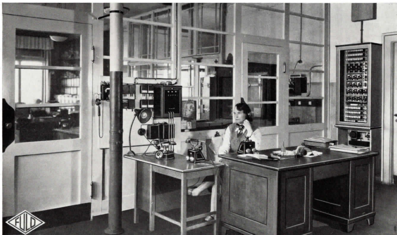
Abb. 16. Die Fernsprechzentrale der Gebr. Uebel in Plauen. Die Firma besitzt im Werk I Bahnhofstraße eine Fuld-Fernsprech-Reihenanlage bestehend aus 24 Apparaten über 3 Amtsleitungen und einem Fuld-Hausautomaten für 25 Teilnehmeranschlüsse mit einer Querverbindung zum Werk Uferstraße, im Werk Uferstraße eine Fuld-Reihenanlage bestehend aus 13 Apparaten über eine Amtsleitung und einer vollautomatischen Fuld-Hauszentrale für 25 Teilnehmeranschlüsse und einer Querverbindung nach dem Werk Bahnhofstraße
