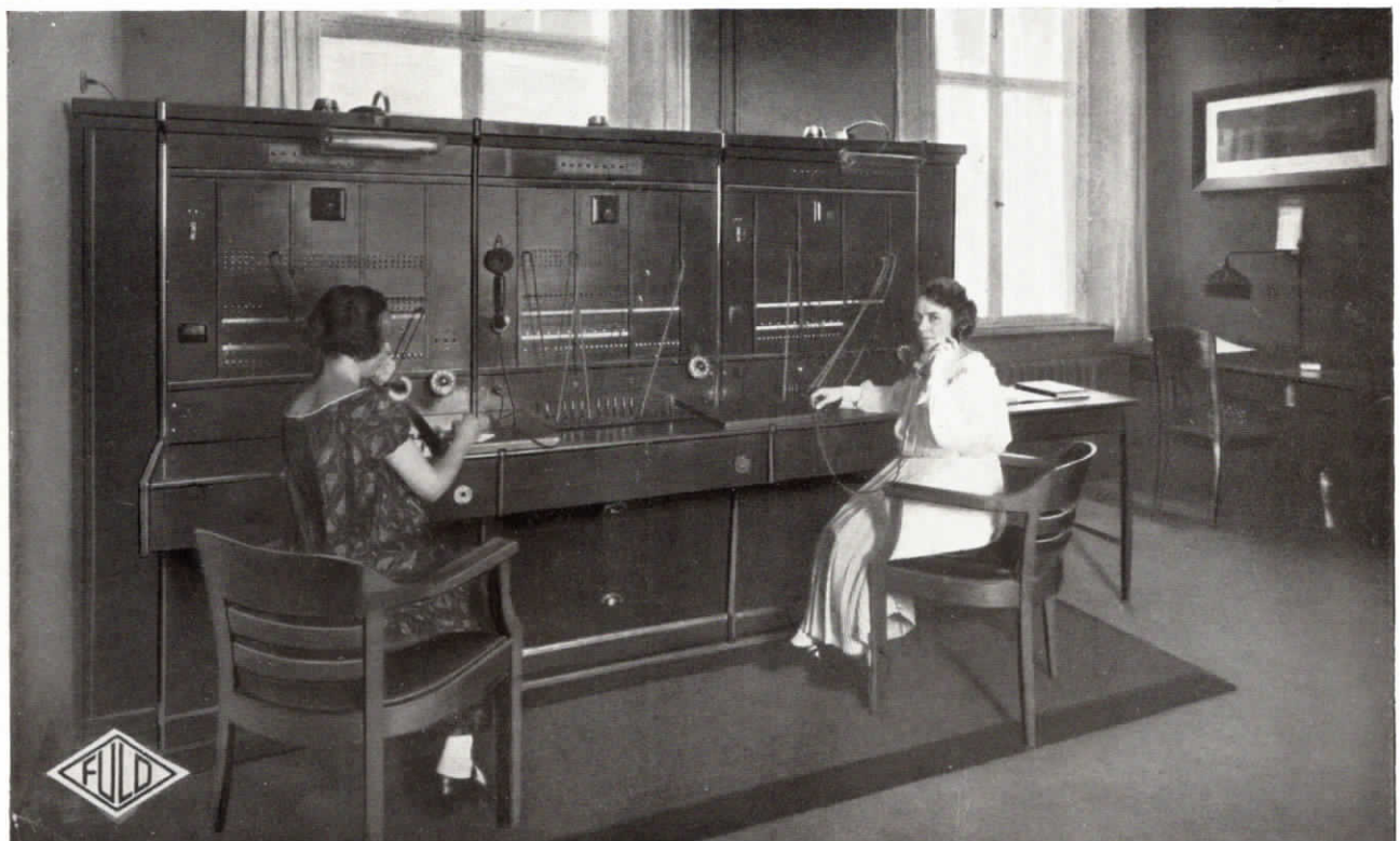
Abb. 13. Fuld-Fernsprechzentrale mit 3 Arbeitsplätzen, ausgebaut für 25 Amtsleitungen und 100 Nebenstellen, in der Dresdner Bank, Filiale Chemnitz
