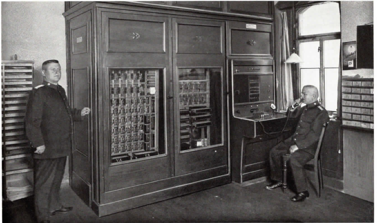
Abb. 10. Die Fuld-Fernsprechanlage im Rathaus Limbach
