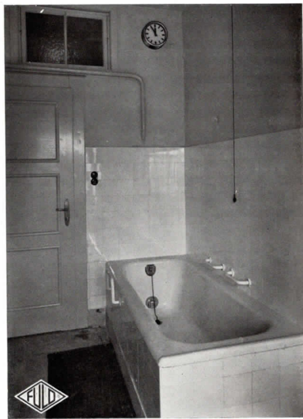
Abb. 31. Badezelle mit elektrischer Normalzeit-Nebenuhr im Kurhaus des Radiumbades Oberschlema. Die elektrische Uhrenanlage besteht aus einer Hauptuhr und 112 Nebenuhren
