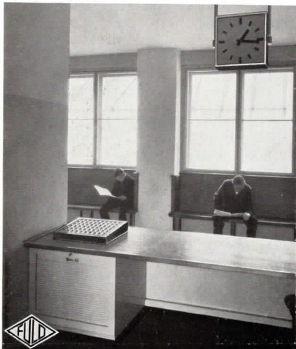
Abb. 17. Kasse der Badeanstalt in der Allg. Ortskrankenkasse Chemnitz mit Kabinen-Besetztmeldetablo für 50 Kabinen, mit automatischer, optischer Zahlenabrufanlage, unterteilt in zwei Gruppen für die Männer- und für die Frauenabteilung, ferner Fuld-Fernsprecher und Normalzeit-Nebenuhr
