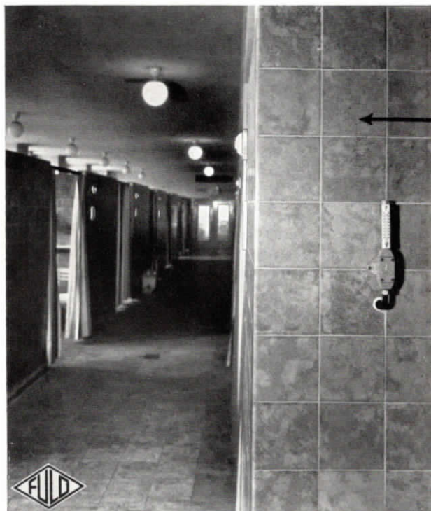
Abb. 15. Flur in der Badeanstalt für Frauen mit elektr. Fernthermometer im Vordergrund rechts, in der Allg. Ortskrankenkasse in Chemnitz
