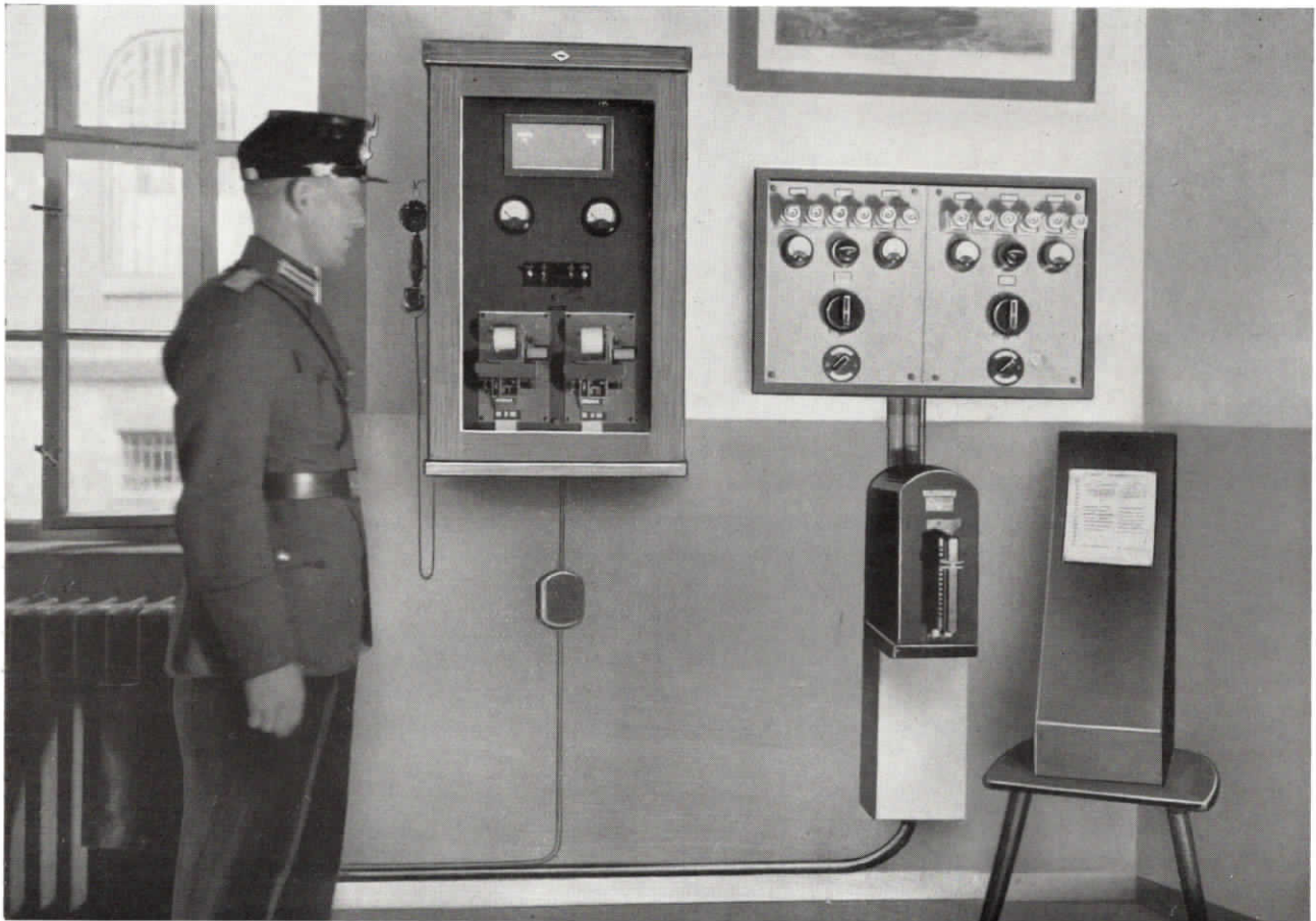
Abb. 2. Notruf-Empfangszentrale (mit Typendruckeinrichtung nach dem Dekadensystem) des Überfallkommandos im Polizei-Präsidium in Chemnitz
