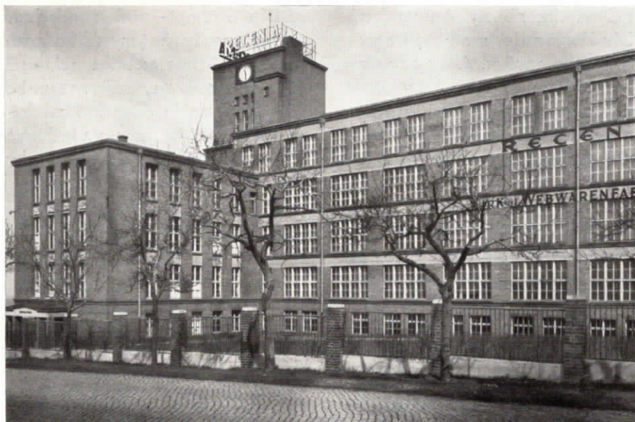
Abb. 25. Die Recenia Wirkwarenfabrik A.-G. in Hartmannsdorf bei Chemnitz besitzt eine ausgedehnte Fuld-Fernsprech-, Lichtruf- und Uhrenanlage
