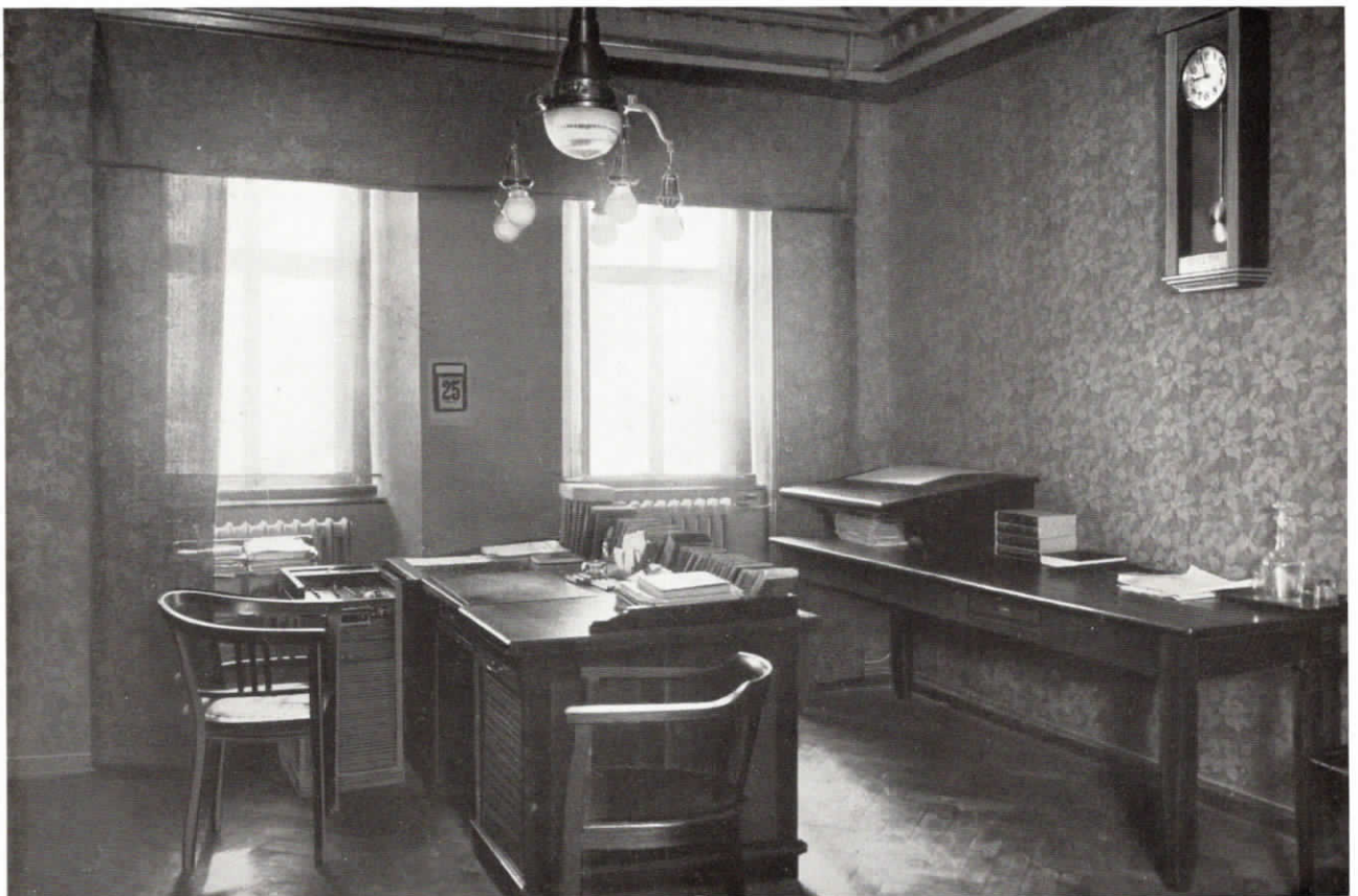
Abb. 11. Bürgermeisterzimmer mit fahrbarem Fernsprechapparat „Pufu“ im Rathaus Limbach
