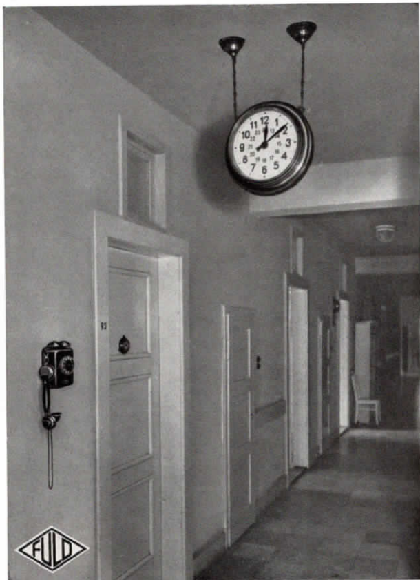
Abb. 30. Flur vor den Badezellen mit Fuld-Fernsprecher und doppelseitiger Normalzeit-Nebenuhr im Kurhaus des Radiumbades Oberschlema. Die Fuld-Fernsprechanlage besteht aus 10 Reihenapparaten über 2 Amtsleitungen und 18 Hausapparaten; dem internen Verkehr dient eine vollautomatische Hauszentrale für 25 Teilnehmeranschlüsse
