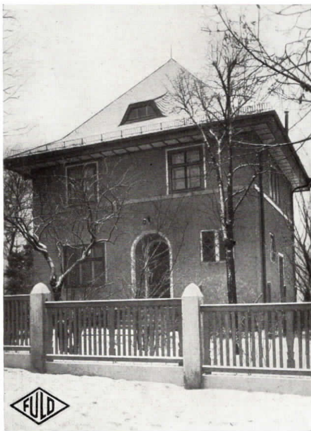
Abb. 40. Einfamilienhaus in einem Villenvorort in Chemnitz, das mit einer sehr zweckmäßigen Fuld-Fernsprechanlage ausgestattet ist
