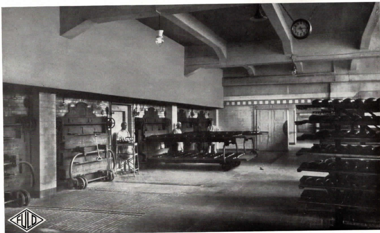
Abb. 30. Bäckerei mit elektrischer Normalzeit-Nebenuhr in der Sächsischen Brotfabrik „Union“ in Chemnitz
