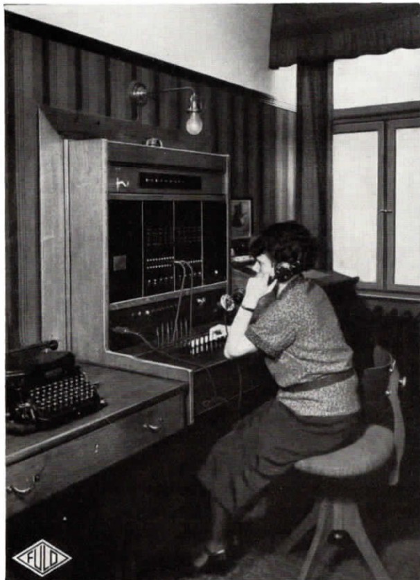
Abb. 13. Halbautomatische Fuld-Nebenstellenzentrale im Werk I der Industrie-Werke A.-G. Plauen
