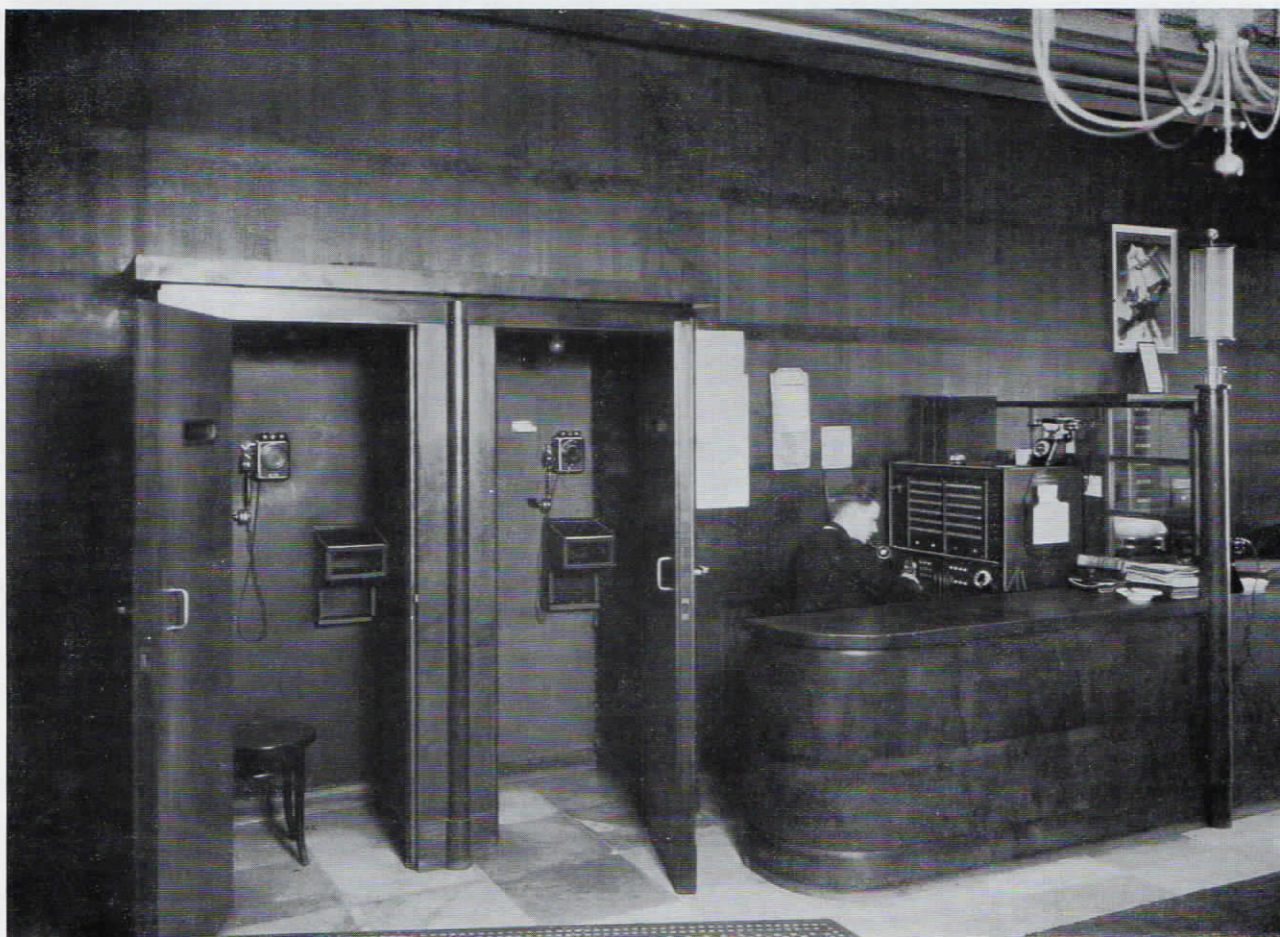
Abb. 71. Empfangsraum im „Hotel Excelsior“ in Bremerhaven mit einer Fuld-Glühlampenzentrale für 3 Amtsleitungen und 120 Nebenstellen, ferner Telefonzellen mit Fuld-Fernsprechapparaten.
