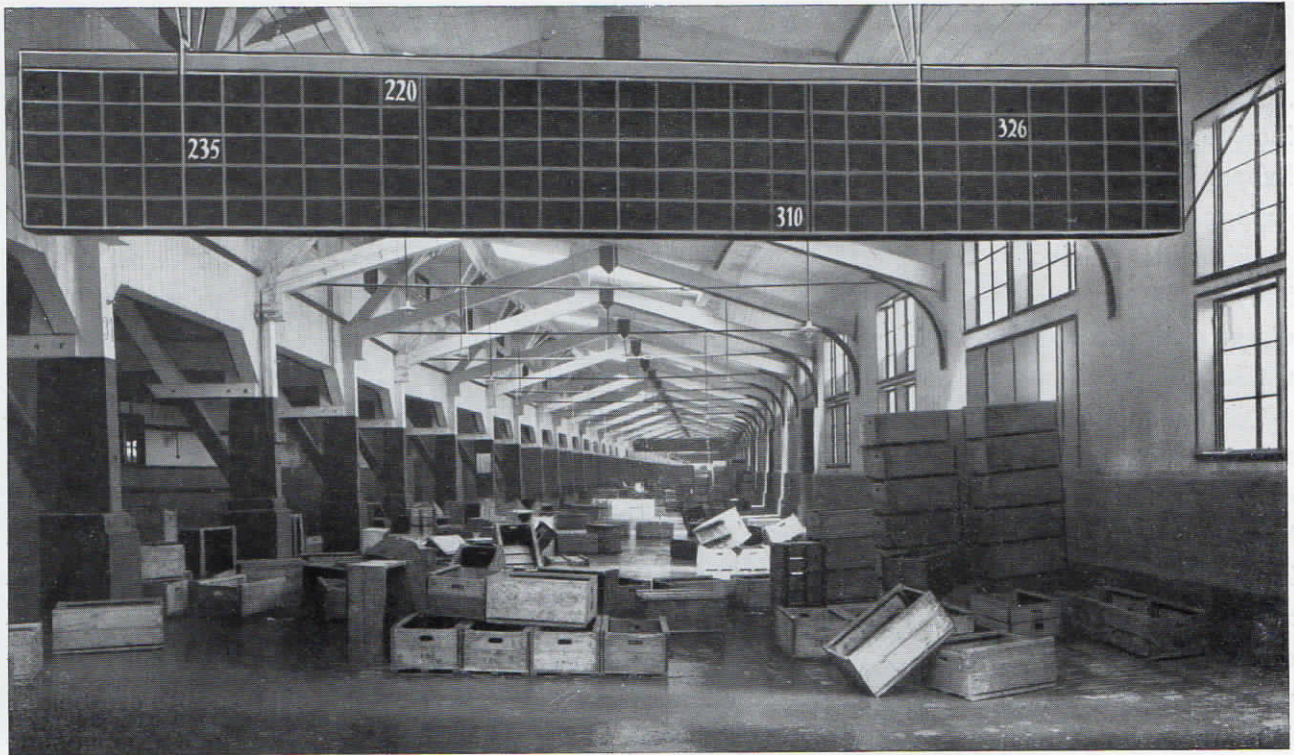
Abb. 6. Fischauktionshalle mit fünf 8 m langen und 1 m hohen Fuld-Lichtsignaltablos für 150 Teilnehmer, in Wesermünde-F.
