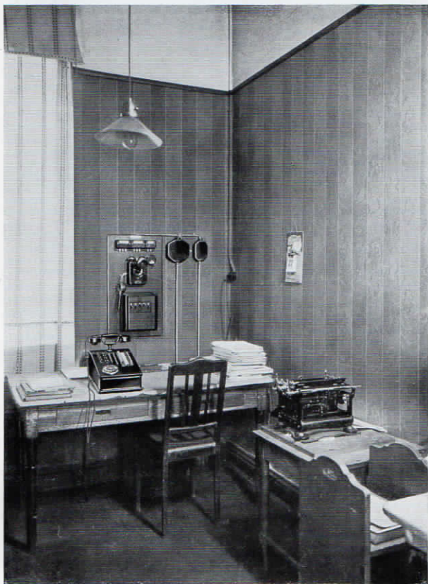
Abb. 76. Der Bedienungsapparat zur Fuld-Universalzentrale im Landratsamt und Kreisaußchuß des Kreises Wesermünde. Die Anlage ist ausgebaut für 4 Amtsleitungen und 30 Nebenstellen und ist ausbaufähig auf 8 Amtsleitungen und 50 Nebenstellen.
