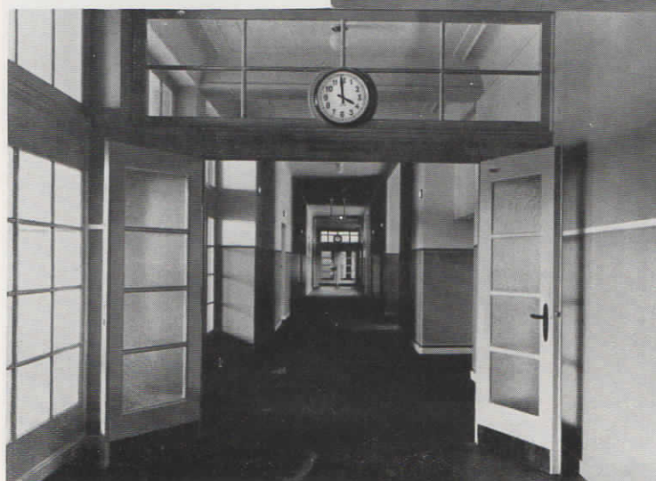
Abb. 63. Flur in der Städtischen Krankenanstalt Bremen mit Lichtsignal-Zimmerlampen über den Türen, Lichtsignal-Armatur an der Decke und doppelseitigen Normalzeit-Nebenuhren.
