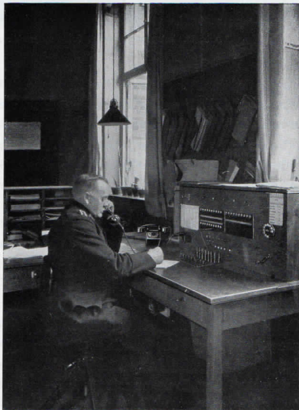
Abb. 2. Fernsprechvermittlungsschrank in einer Polizeiwache.
