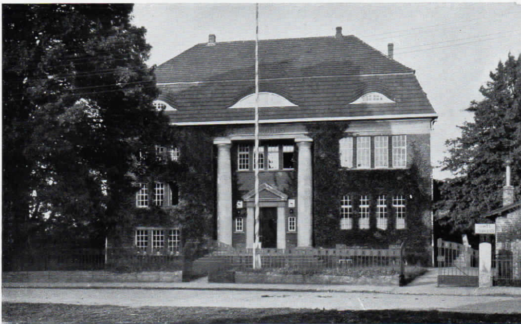
Abb. 92. Das Landratsamt und Kreisaußchuß in Osterholz-Scharmbeck verfügt über eine halbautomatische Fuld-Fernsprechanlage für 4 Amtsleitungen und 40 Nebenstellen. Dem internen Verkehr dient eine vollautomatische Fuld-Hauszentrale für 50 Teilnehmer.
