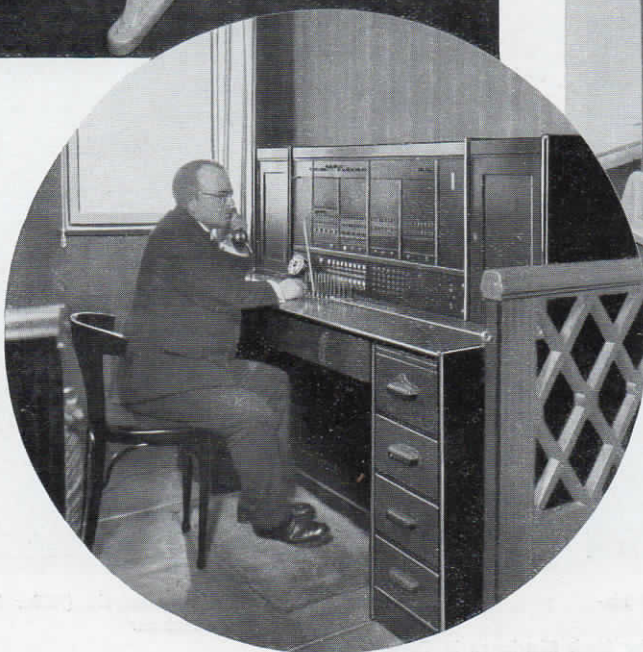
Abb. 98 (oben). Vollautomatische Fuld-Hauszentrale nach dem Stangenwähler-System für 100 Teilnehmer. Eine Universalzentrale für 3 Amtsleitungen und 100 Nebenstellen dient dem Nachtverkehr; im Rathaus der Stadt Delmenhorst in Oldenburg.
