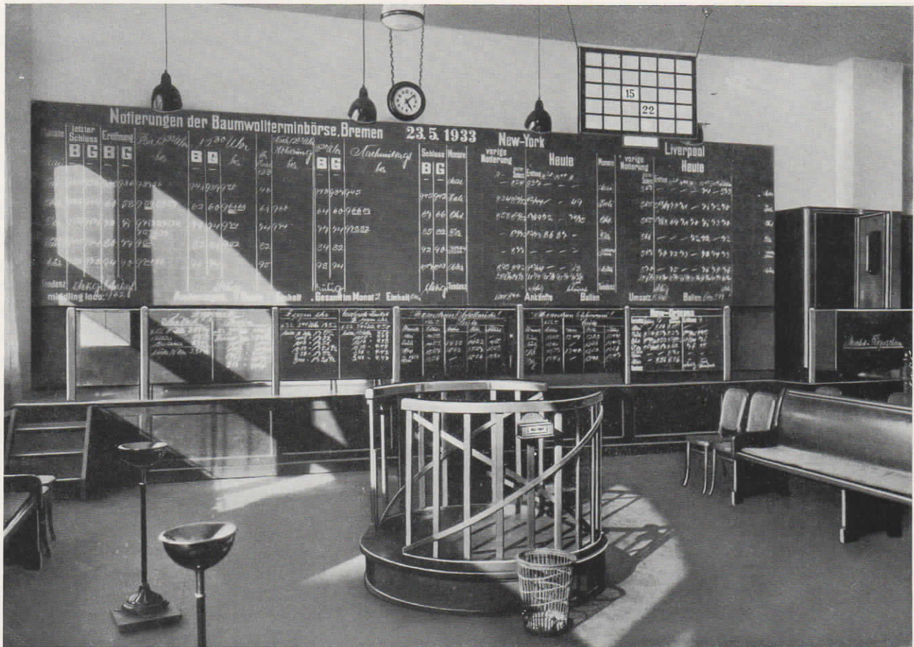
Abb. 6. Die Baumwollterminbörse Bremen mit Fuld-Lichtsignal-Tablo mit 30 Lichtfeldern, das die Teilnehmer in die rechts im Bild beginnenden Telefonzellen ruft, ferner Normalzeit-Nebenuhr. Die Bremer Baumwollbörse verfügt über eine Fuld-Fernsprechanlage, bestehend aus 1 Glühlampenzentrale für 8 Amtsleitungen und 40 Nebenstellen, 1 vorgeschalteten- und 23 Fernsprechapparaten mit Rückfragemöglichkeit.
