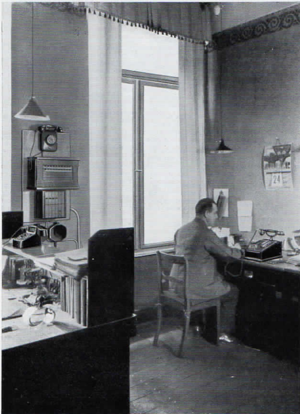
Abb. 89. Der Abfrageapparat zur Fuld-Universalzentrale für 3 Amtsleitungen und 40 Nebenstellen im Rathaus der Stadt Verden an der Aller.
