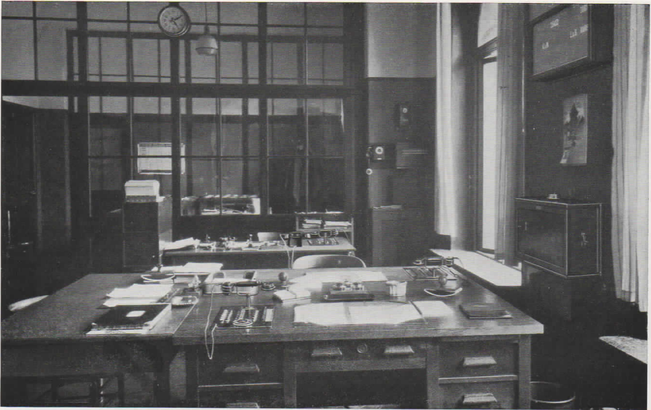
Abb. 32. Fuld-Spezial-Makler-Telephonanlage, bestehend aus 4 Telephontischen mit eingebauter Sprechgarnitur für 5 Amtsleitungen und 10 Maklerleitungen, 3 Glühlampen-Tablos und einem Relaischrank, ferner Normalzeit-Nebenuhr, in einer Getreide- und Futtermittelimportfirma Bremens.
