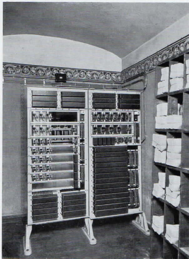
Abb. 76. Der Bedienungsapparat zur Fuld-Universalzentrale im Landratsamt und Kreisaußchuß des Kreises Wesermünde. Die Anlage ist ausgebaut für 4 Amtsleitungen und 30 Nebenstellen und ist ausbaufähig auf 8 Amtsleitungen und 50 Nebenstellen.
