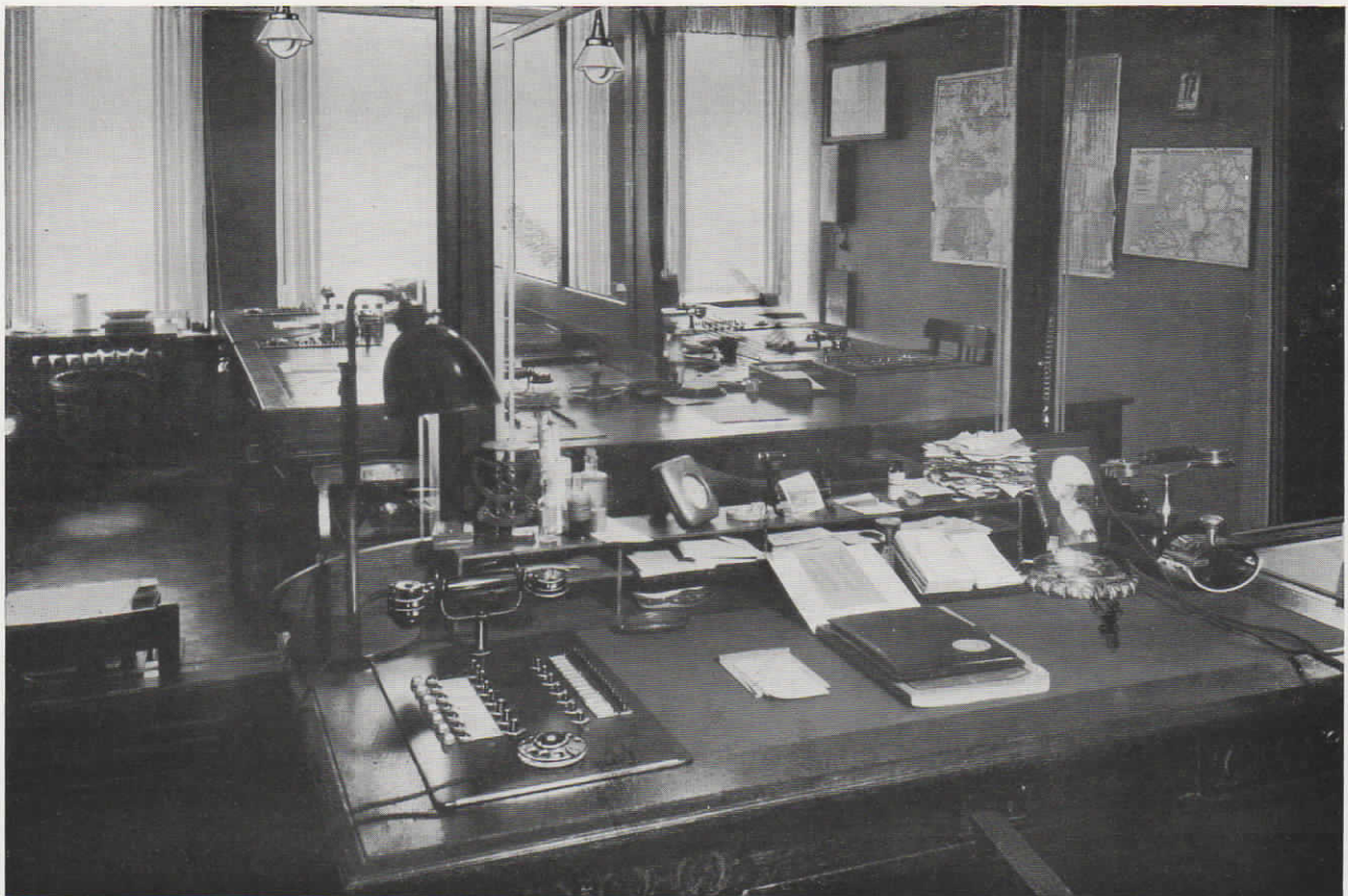
Abb. 33. Fuld-Spezial-Makler-Telephonanlage, bestehend aus 6 Telephontischen mit eingebauter Sprechgarnitur für 7 Amtsleitungen und 15 Maklerleitungen, ferner 2 Glühlampentablos und 2 Relaischränke, in der Getreideimportfirma C. Schwarze in Bremen. Die Glühlampentablos enthalten neben den Anruf- und Besetztlampen für die Amts- und Maklerleitungen noch besondere Namensfelder, die anzeigen, auf welchen Amtsleitungen bereits Verbindungen für den betreffenden Herrn warten.
