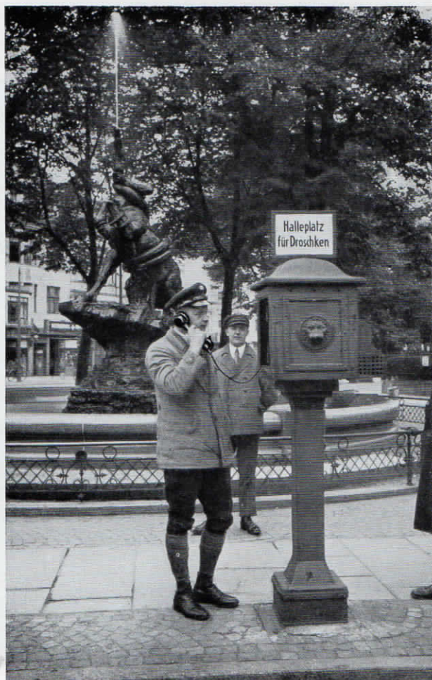
Abb. 4. Säule mit wetterfestem Fernsprecher für den Autoruf des Bremer Droschkenvereins.
