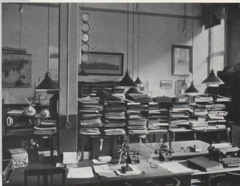
Abb. 18 (unten). Blick in einen Büroraum der Speditionsfirma Röhlig & Co. in Bremen mit Fuld-Fernsprechapparaten und Lichtsignalarmatur zum Suchen von 5 Personen.
