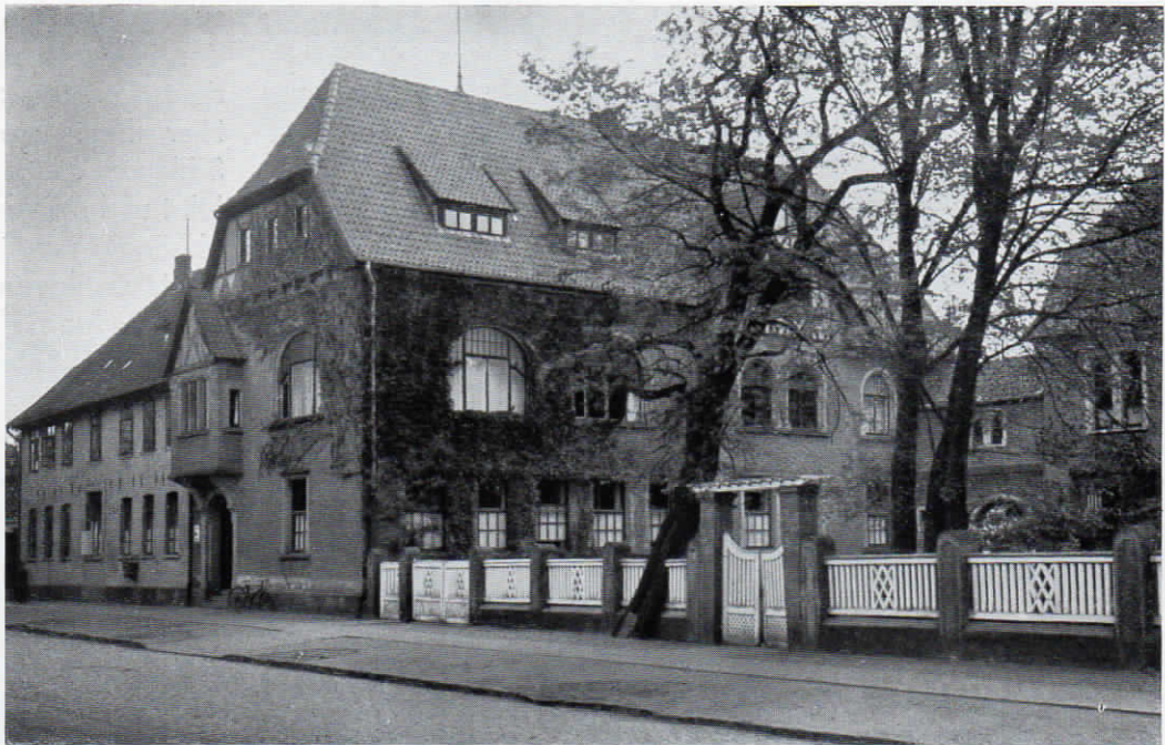
Abb. 91. Das Landratsamt und Kreisaußchuß Verden an der Aller arbeitet mit einer Fuld-Reihen-Fernsprechanlage über 2 Amtsleitungen, einer vollautomatischen Hauszentrale (23er System) und einem Vermittlungsschrank für 2 außenliegende Nebenstellen.
