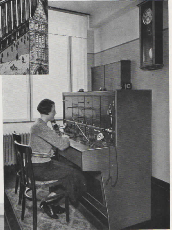
Abb. 43. Das Warenhaus Rudolph Karstadt A.-G. in Bremen verfügt über umfangreiche Fuld'sche Fernmeldeanlagen und zwar eine Fernsprechanlage, eine Normalzeit-Uhrenanlage und eine Feuermeldeanlage.
