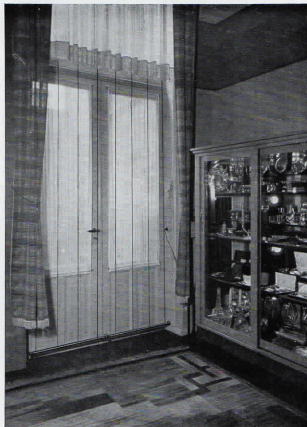
Abb. 6. Türschutz durch Drahtgardine.
