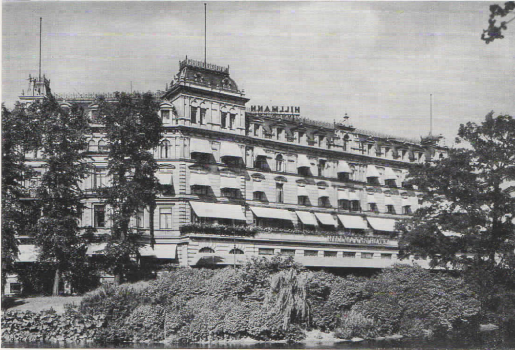
Abb. 54. Hillmann's Hotel in Bremen verfügt über eine umfangreiche fernmeldetechnische Einrichtung, bestehend aus Fuld-Glühlampen-Fernsprechzentrale für 10 Amtsleitungen und 220 Nebenstellen, Fuld-Lichttrufanlage für Kellner, Mädchen, Diener, ferner einer besonderen Glühlampen-Tabloanlage für die Restaurationsräume.
