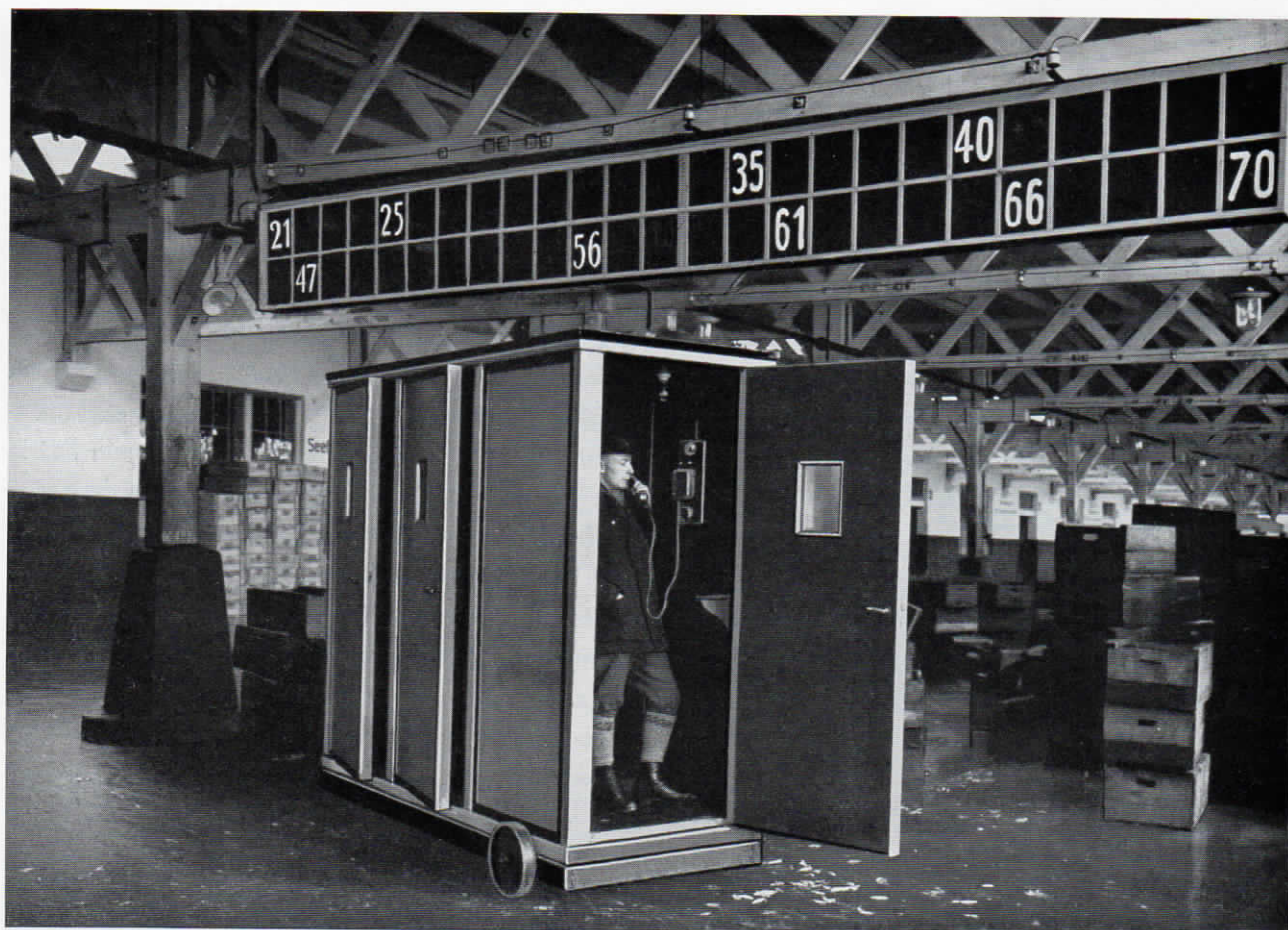
Abb. 13. Telephonwagen mit Fuld-Fernsprechern, ferner Fuld-Lichtsignaltaflo im Fischereihafen Cuxhaven.
