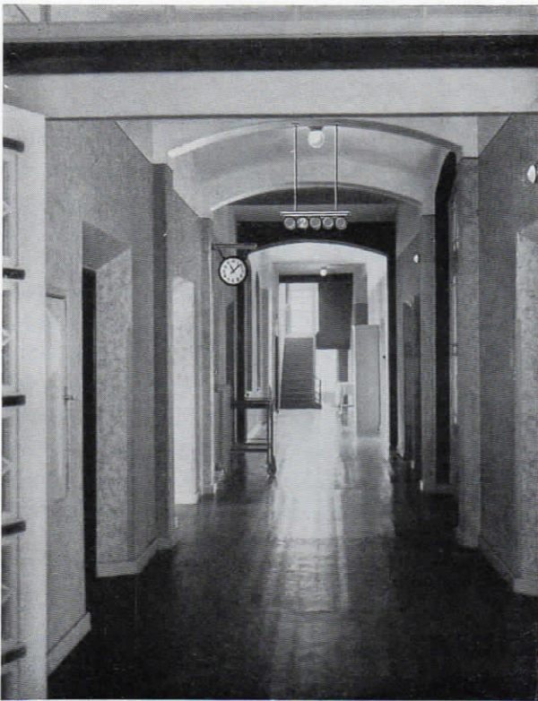
Abb. 110. Flur im Städtischen Krankenhaus in Wilhelmshaven mit Fuld-Zimmerlampen, Lichtrufarmatur und doppelseitiger Normalzeit-Nebenuhr.
