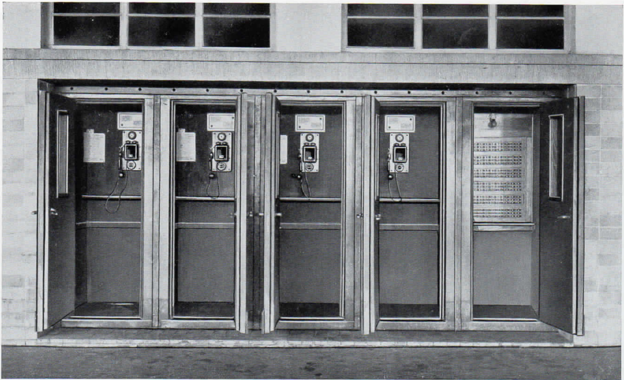
Abb. 11. In der neuerbauten Fischauktionshalle X in Bremerhaven wurden die Telephonzellen eingebaut, und zwar sind 30 Zellen über die Halle verteilt. Die Zelle rechts enthält die Signalgeber-Einrichtung.
