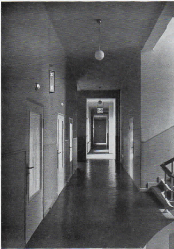
Abb. 72 (oben). Flur mit Lichtsignalzimmerlampen über den Türen und Dreiecktablo, Notbeleuchtung, ferner doppelseitiger Normalzeit-Nebenuhr im Kreiskrankenhaus Soltau i. H.
