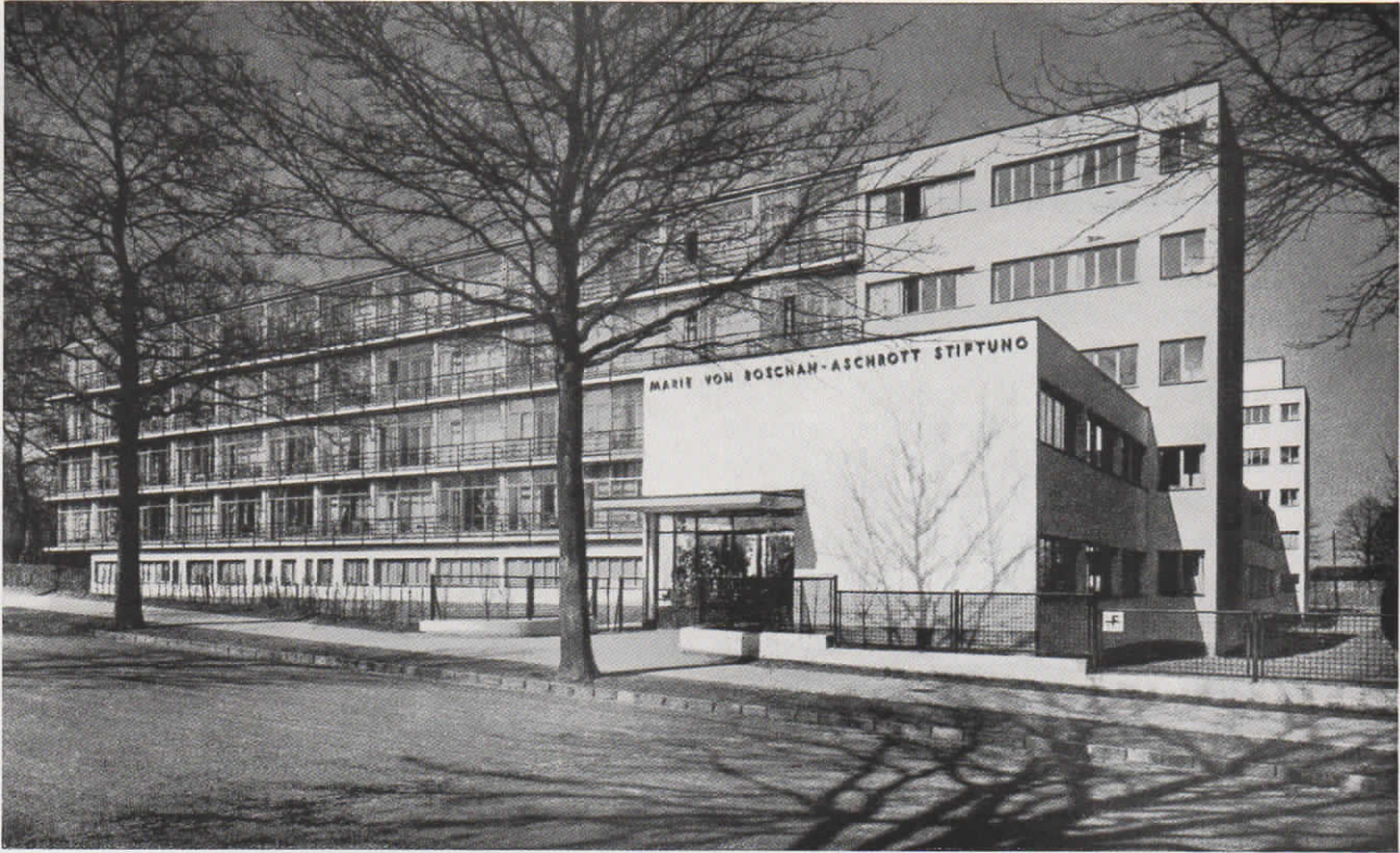
Abb. 15. Die Marie von Boschan-Aschrott-Stiftung Altersheim in Kassel verfügt über eine umfangreiche und vielseitige Fernmeldeanlage, bestehend aus: Fernsprechanlage, elektrischer Uhrenanlage, Lichtsignalanlage, Nachtglockenanlage, elektr. Türöffneranlage, Gonganlage und Radioanlage.
