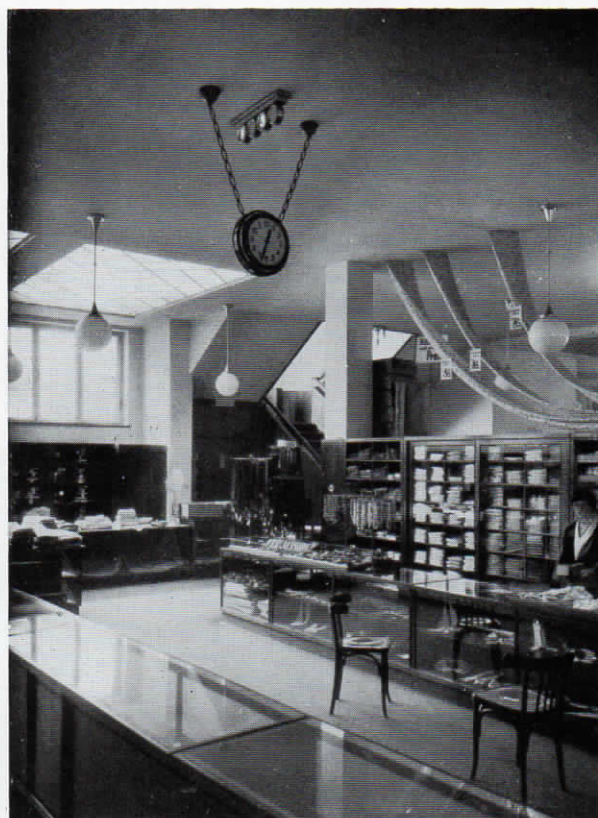
Abb. 19. Verkaufsraum mit Fuld-Lichtsignal-Armatur und doppelseitiger Normalzeit-Nebenuhr, in der Firma Rosbach & Risse in Braunschweig.
