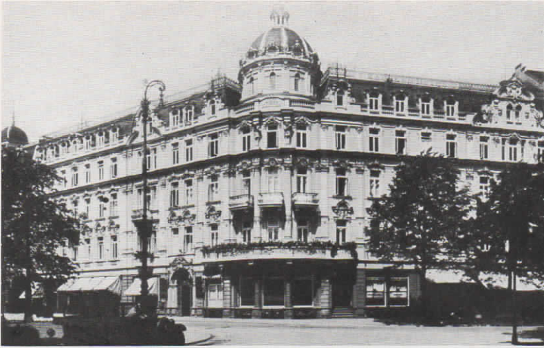
Abb. 38. Kastens Hotel in Hannover verfügt über eine Glühlampenzentrale für 12 Amtsleitungen und 130 Nebenstellen; dem internen Verkehr dient eine vollautomatische Zentrale 50er System; angeschlossen sind 2 vorgeschaltete Fernsprechapparate und 130 Fernsprechapparate für den Amtsverkehr.
