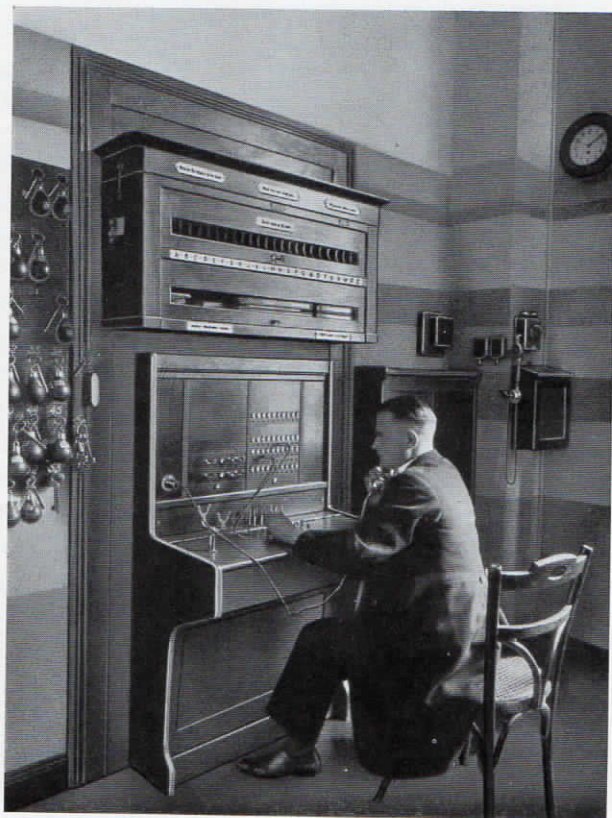
Abb. 21. Portierloge mit Fuld-Glühlampenzentrale für 2 Amtsleitungen und 20 Nebenstellen in Frühlings Hotel Stadt Bremen in Braunschweig.
