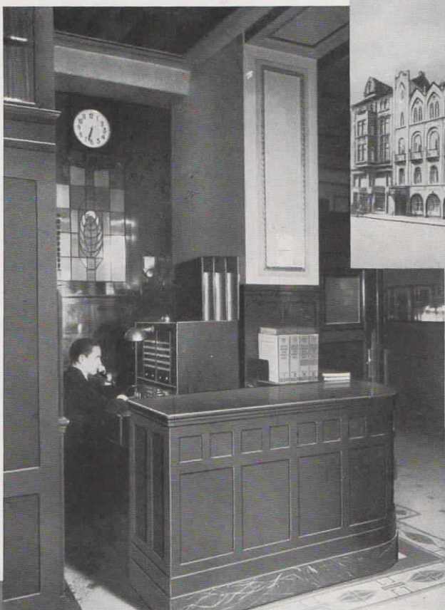
Abb. 41 (links). Portierloge mit Fuld-Glühlampenzentrale für 4 Amtsleitungen und 100 Nebenstellen im Grand-Hotel Mussmann in Hannover.
