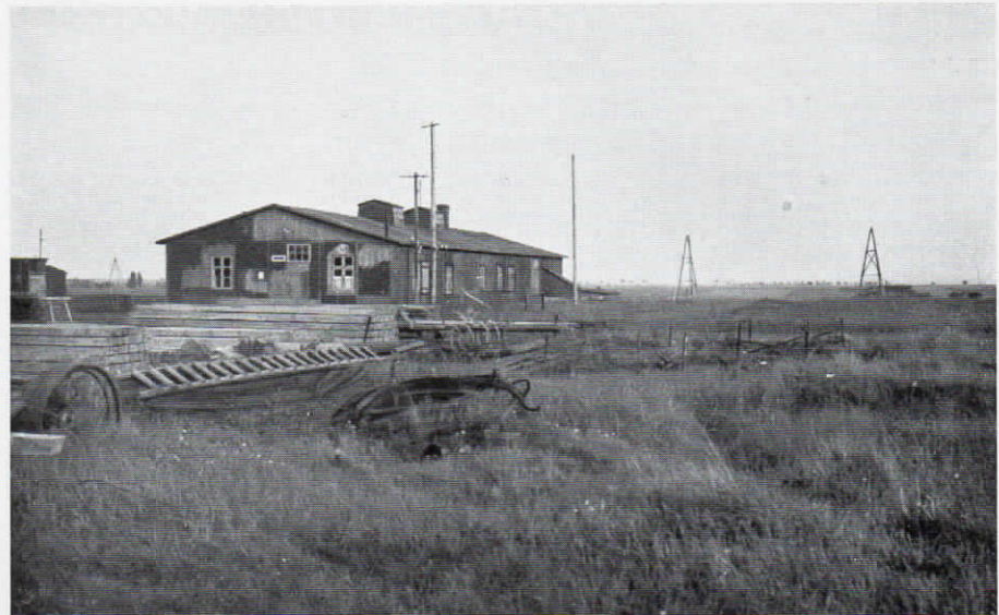
Abb. 24. Werkschuppen der „Ebag“ Erdölbergbau A. G. in Oberg bei Peine, in dem ein Zentralumschalter für eine Amtsleitung und 4 Nebenstellen und eine vollautomatische Fuld-Fernsprechzentrale 10er System zur Aufstellung gelangte. Im Hintergrunde einige Bohrtürme, die der „Ebag“ gehören.
