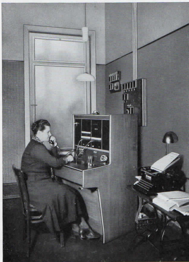
Abb. 55. Fuld-Glühlampenzentrale für 3 Amtsleitungen und 20 Nebenstellen.
