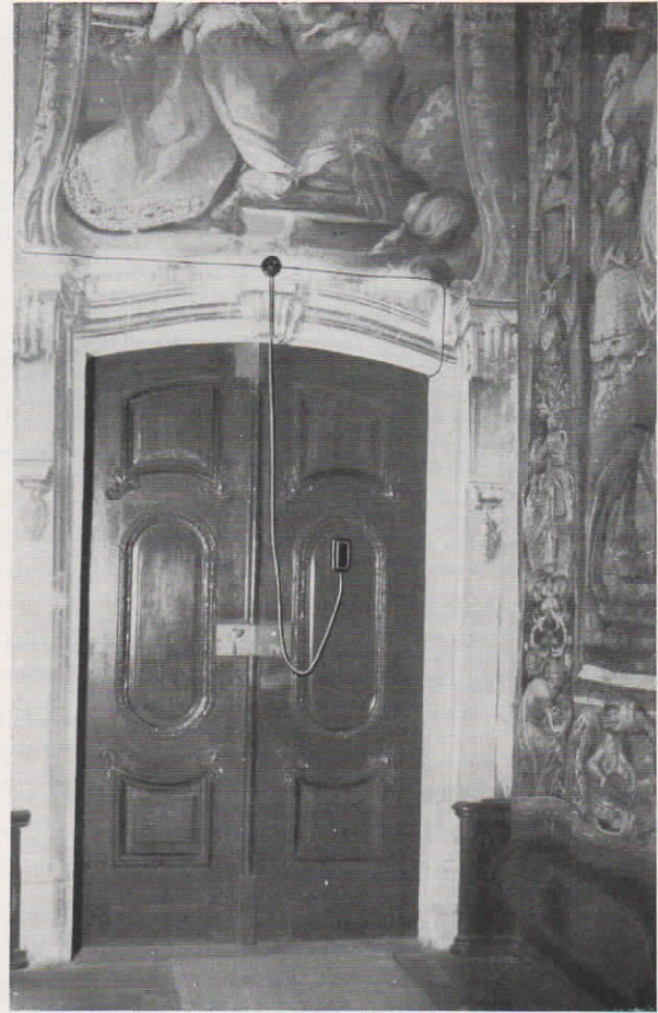
Abb. 48 und 49. Türsicherungskontakte der Sicherungs- und Alarmanlage im Hildesheimer Dom.
