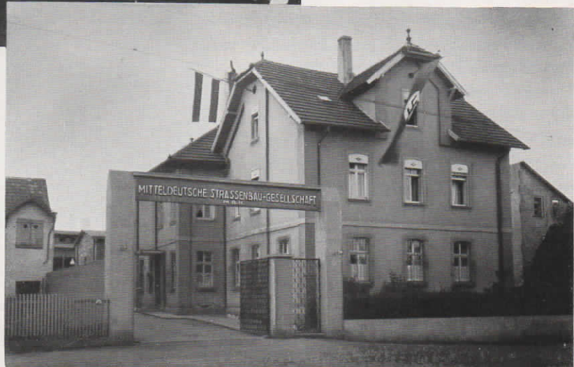
Abb. 12 (rechts). Die Mitteldeutsche Straßenbau-Gesellschaft m. b. H. in Niederzwehren b. Kassel besitzt eine Fuld-Glühlampenzentrale für 3 Amtsleitungen und 20 Nebenstellen, ferner eine vollautomatische Fuld-Hauszentrale 25er System für den internen Verkehr.
