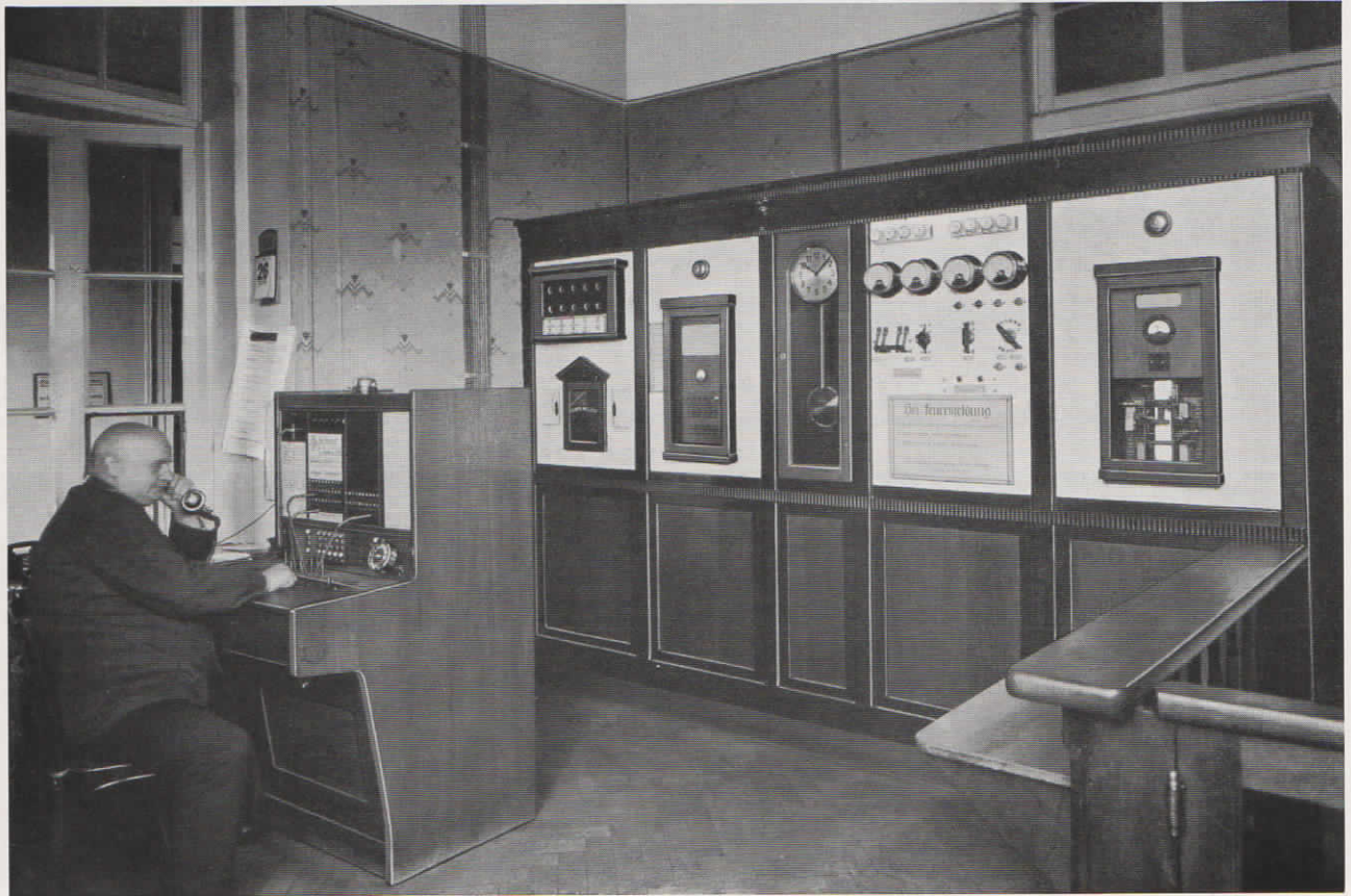
Abb. 2. Blick in den Zentralenraum der Fernmeldeanlagen in den Städt. Bühnen in Hannover. Die Städt. Bühnen in Hannover verfügen über eine halbautomatische Fuld-Fernsprechzentrale für 5 Amtsleitungen und 50 Nebenstellen, eine vollautomatische Fuld-Fernsprechzentrale 100er System und eine Fuld-Fernsprechzentrale 10er System, die beiden letzteren für den internen Verkehr; ferner 48 Fernsprechapparate für Post- und Hausverkehr, 5 Münzfernsprecher und 24 Hausapparate; außerdem über eine Elektrozeit-Feuermeldeanlage, bestehend aus einer Zentrale und 150 Feuermeldern; ferner über eine umfangreiche Elektrozeit-Wächterkontrollanlage.
