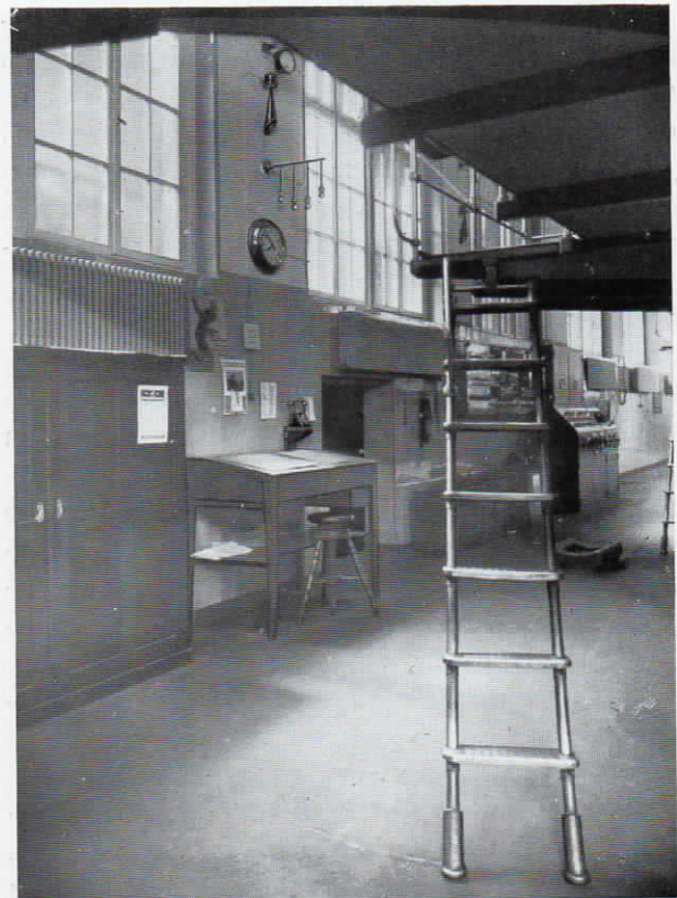
Abb.13. Rotationsmaschinensaal mit Fuld-Fernsprecher, Lichtruf-Armatur, Normalzeit-Nebenuhr und Signalhupe in der Braunschweigischen Landeszeitung.
