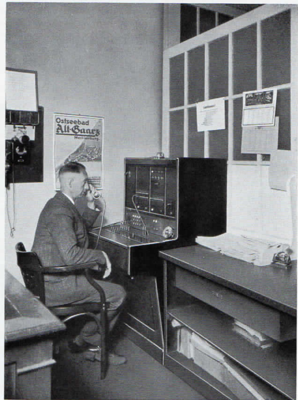
Abb. 15. Fuld-Glühlampenzentrale für 4 Amtsleitungen und 30 Nebenstellen in den Braunschweiger Neuesten Nachrichten.
