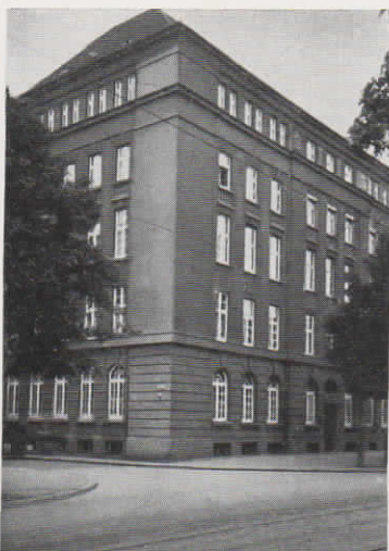
Abb. 14 (rechts). Die Kohlenhandels-gesellschaft „Westfalia“ Wiesebrock, Schulte & Co. in Hannover arbeitet mit einer Fuld-Glühlampenzentrale für 5 Amtsleitungen und 23 Nebenstellen; angeschlossen sind 23 Fuld-Fernsprech-apparate für Amts- und Hausverkehr.
