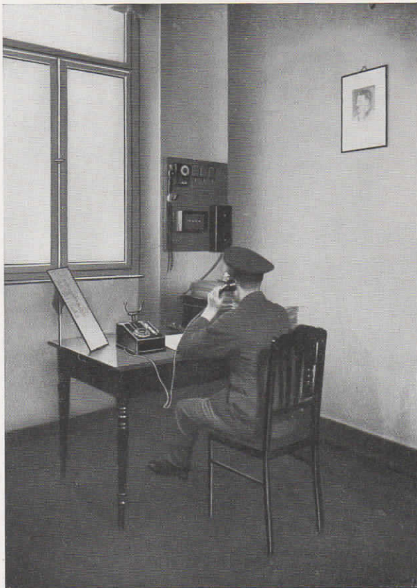
Abb. 10 und 11. Das Städtische Wohlfahrtsamt Hannover Nebenstelle Horst Wessel-Platz bedient sich einer Fuld-Universal-Fernsprechzentrale für 3 Amtsleitungen und 20 Nebenstellen.
