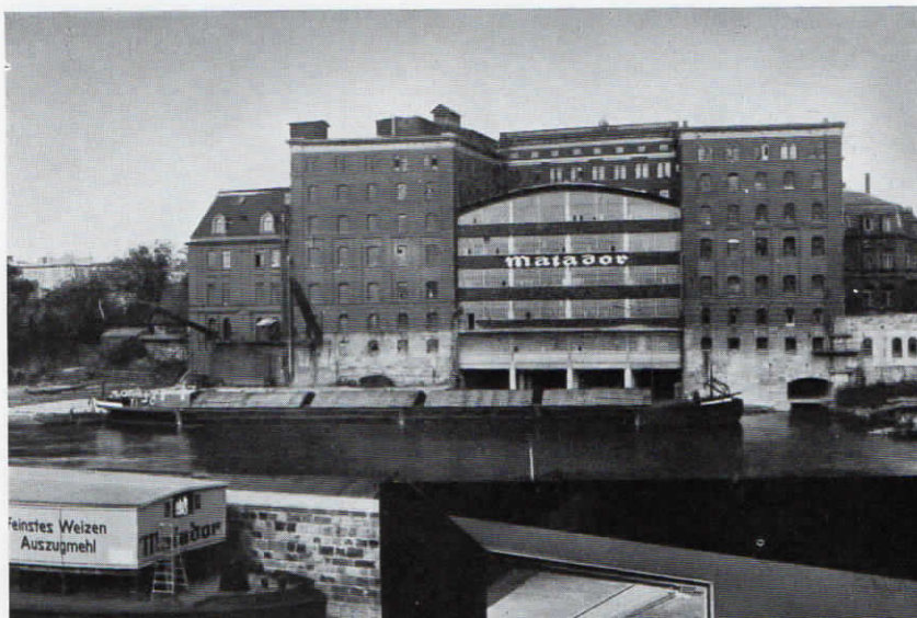
Abb. 87 (links). Teilansicht der Wesermühlen A.G., Hameln a.W. Die Wesermühlen A.G. verfügt über eine Fuld-Glühlampenzentrale für 6 Amtsleitungen und 40 Nebenstellen, ferner über eine vollautomatische Fuld-Hauszentrale 50er System.
