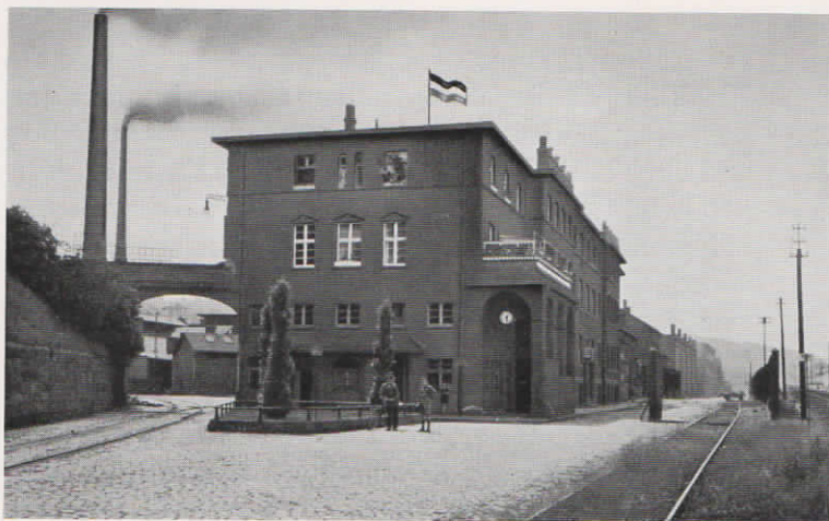
Abb. 13. Die Waggonfabrik Wegmann & Co. in Kassel-Rothenditmold besitzt eine Fuld-Glühlampenzentrale u. in ihrem Werk in Bettenhausen eine vollautomatische Fuld-Hauszentrale 10er System.
