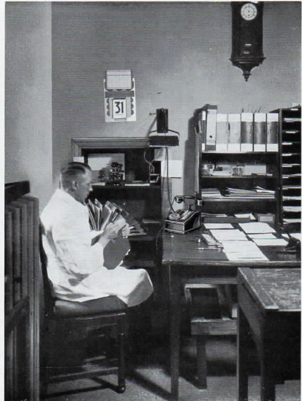
Abb. 6 (rechts). Bedienungsapparat zur Fuld-Universalzentrale für 4 Amtsleitungen und 25 Nebenstellen in der Dresdner Bank Filiale Braunschweig.
