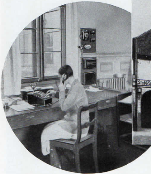
Abb. 81 (oben). Bedienungsapparat zur Fuld-Universalzentrale für 2 Amtsleitungen und 26 Teilnehmeranschlüsse, im Rathaus der Stadt Nienburg a. W.
