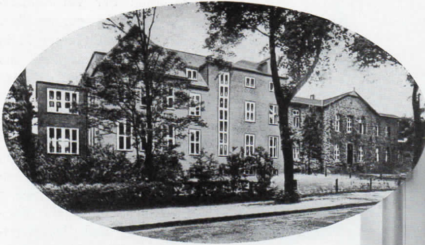
Abb. 70 (links). Kreiskrankenhaus in Soltau i. H.
