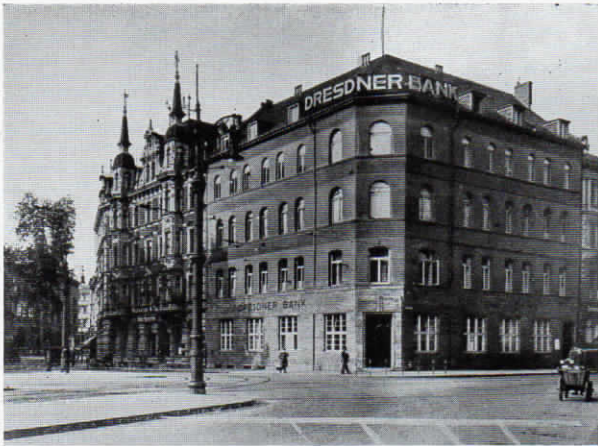
Abb. 5. Die Dresdner Bank Filiale Braunschweig
