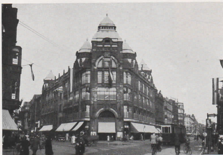
Abb. 28. Das Kaufhaus Rudolph Karstadt Akt.-Ges. in Hannover besitzt eine Fuld-Glühlampenzentrale für 3 Amtsleitungen, 18 Nebenstellen und 15 Hausstellen.
