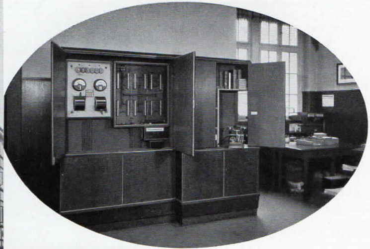
Abb. 94 (oben). Blick in einen Büroraum im Göttinger Tageblatt Gebr. Wurm G.m.b.H. in Göttingen mit Bedienungs- apparat zur Fuld-Universalzentrale für 3 Amtsleitungen und 26 Teilnehmer- anschlüssen; ferner mit Rangiervertei- ler und Ladeschalttafel.
