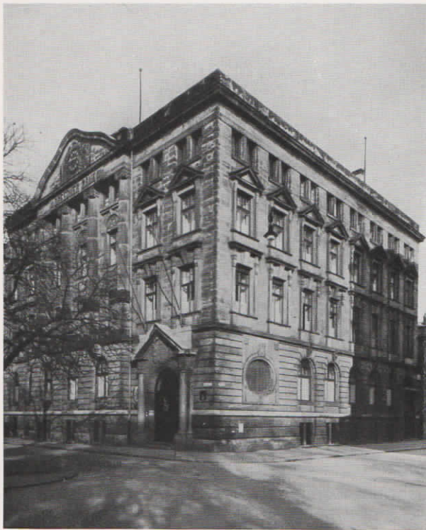
Abb. 12. Die Dresdner Bank Filiale Hannover verfügt über eine Fernsprech-Glühlampenzentrale f. 18 Amtsleitungen, eine vollautomatische Hauszentrale 100er System, 4 vorgeschaltete Fernsprechapparate über 2 Amtsleitungen, 40 Fernsprecher für Amts- u. Hausverkehr u. 20 Hausapparate.
