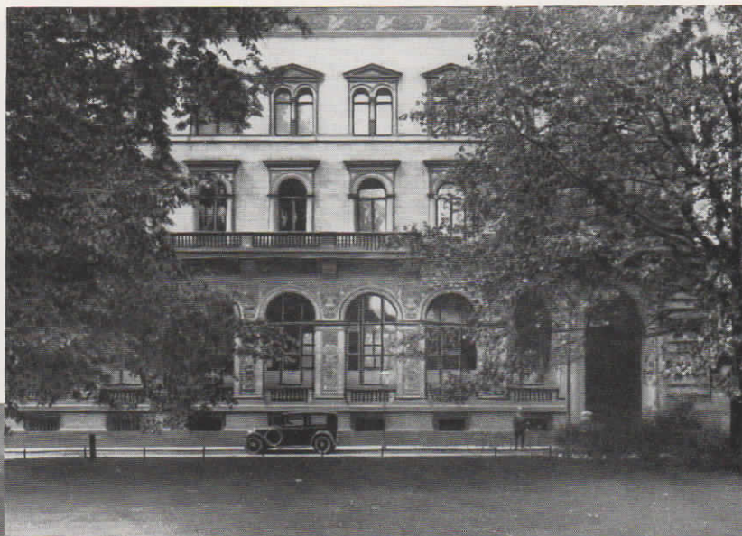
Abb. 4 (rechts). Die Reichsbankhauptstelle in Hannover.
