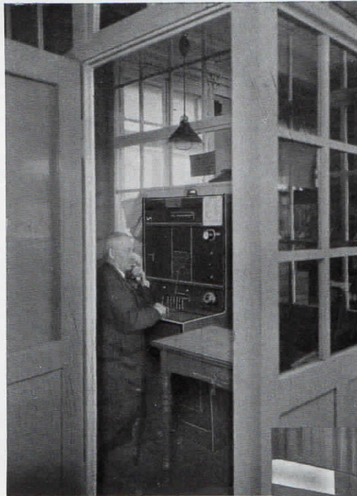
Abb. 61 (links). Die Chr. Hostmann-Steinbergsche Farbenfabriken G. m. b. H. in Celle verfügen über eine halbautomatische Fuld-Fernsprechzentrale für 5 Amtsleitungen und 25 Nebenstellen, eine vollautomatische Fuld-Hauszentrale für 50 Teilnehmer und eine Fuld-Fernsprech-Reihenanlage über 1 Amtsleitung, bestehend aus 5 Apparaten für Amtsverkehr.
