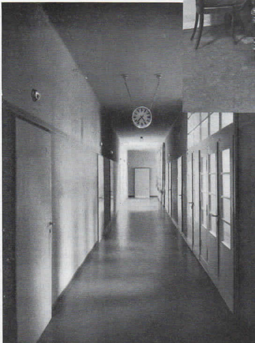
Abb. 66 (links). Flur mit Fuld-Lichtsignalzimmerlampen über den Türen u. doppels. Normalzeit-Nebenuhr in der Landesfrauen - Klinik in Celle.
