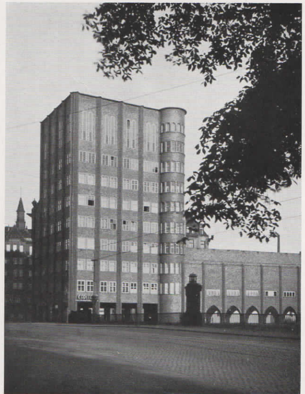
Abb. 13. Die Capitol-Lichtspiele in Hannover-Linden besitzen einen manuellen Zentral-Umschalter für 2 Amtsleitungen u. 2 Nebenstellen; dem internen Verkehr dient eine vollautomatische Fuld-Haus-Fernsprechzentrale 23er System, ferner 4 Fernsprechapparate für den Amtsverkehr und 10 Hausapparate.
