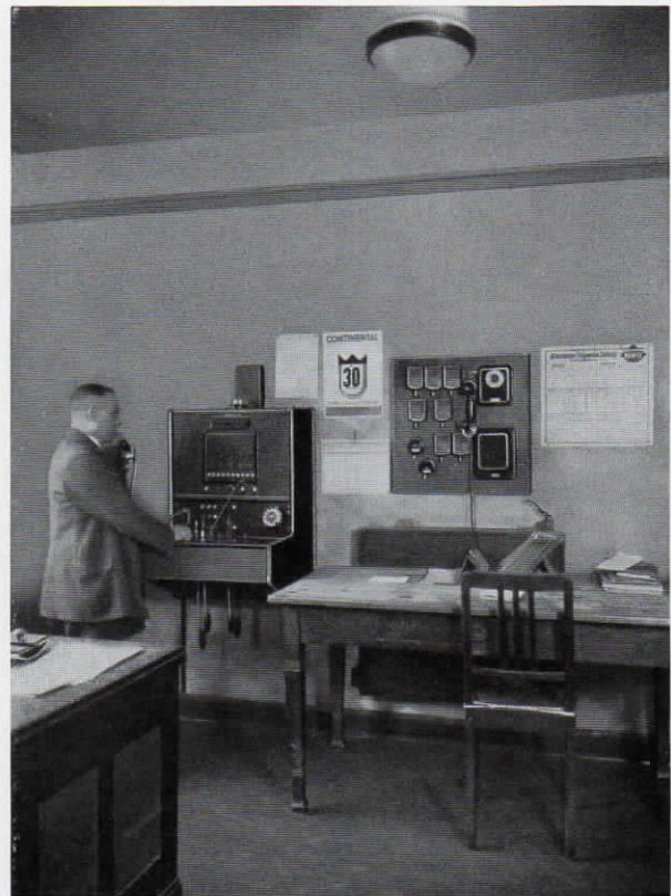
Abb. 53. Die Münsterische Schiffs- und Lagerhaus Akt.Ges. in Hildesheim bedient sich einer Fuld-Glühlampen-Wandzentrale für 3 Amtsleitungen u. 10 Nebenstellen, sowie einer vollautomatischen Fuld-Hauszentrale für 15 Teilnehmeranschlüsse.
