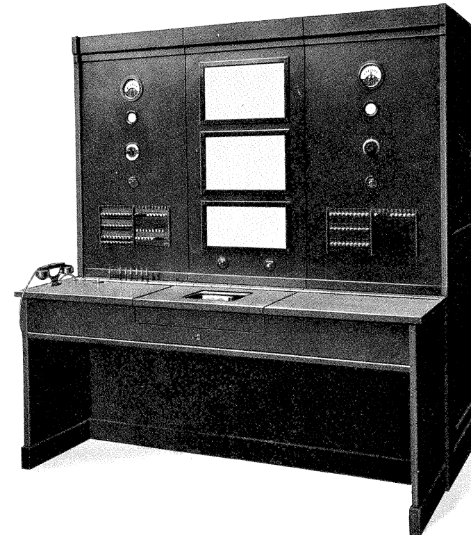
Abb. 30. Feuermeldezentrale der Stadt Brüssel (Strahlensystem).
