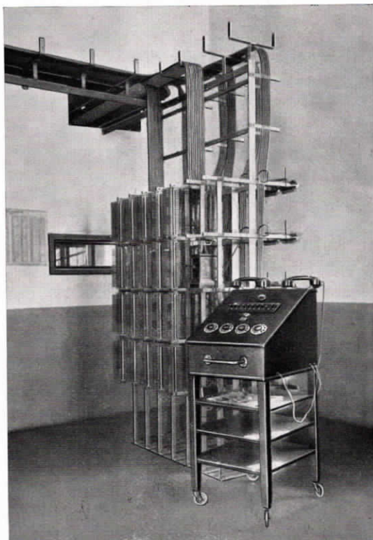
Abb. 7 Hauptverteiler und Prüfpult zur Fallwähler-Zentrale in Addis Abeba
