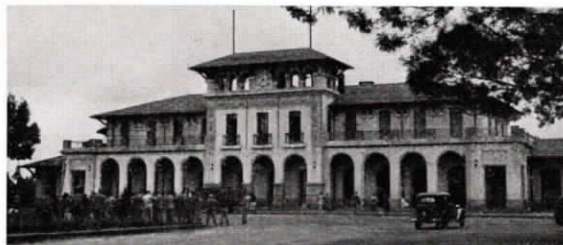
Abb. 15 Bahnhofsgebäude der französisch- äthiopischen Eisenbahn Addis Abeba
