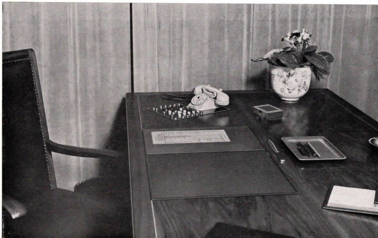
Bild 2 Schreibtisch mit in die Platte eingebauter Fernsprech- und Signaleinrichtung
