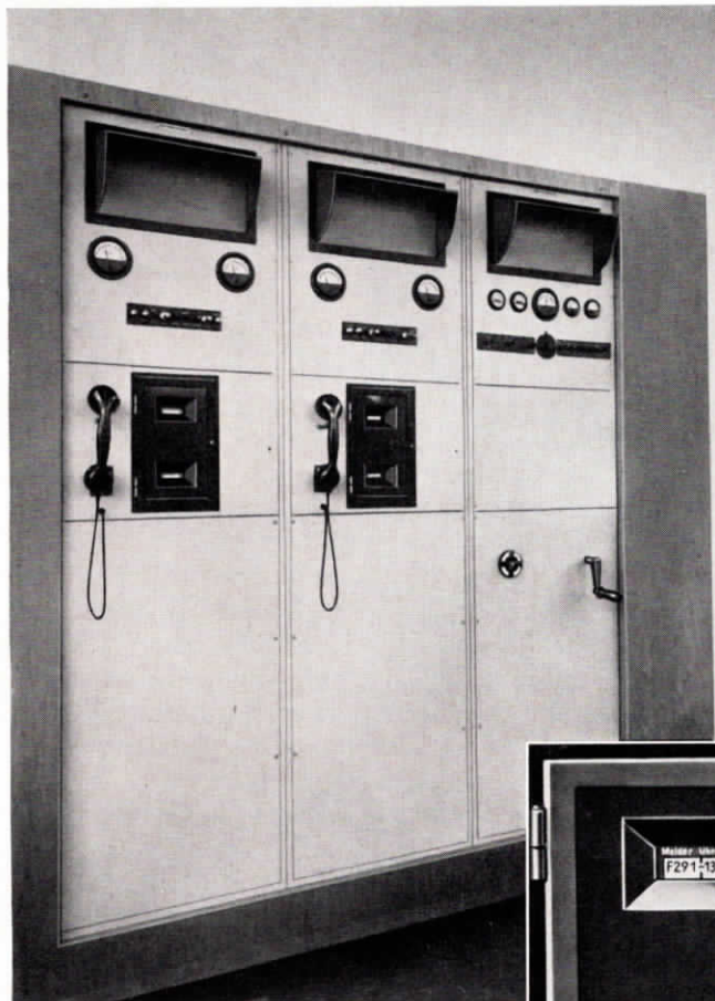
Abb. 17 Feuermelde-Anlage nach dem Universalsystem der TuN
