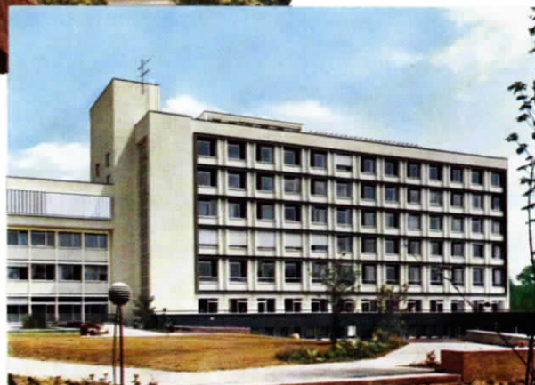
BILD 1b Rückansicht des fertiggestellten Neubaues
