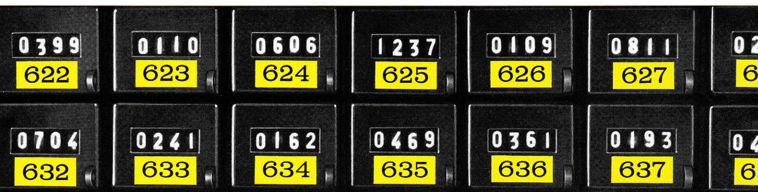
BILD 3 Gebührenzähler zum Registrieren der Gebühreneinheiten für abgehende Orts- und Ferngespräche
