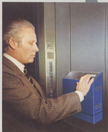
4 Aufzugsteuerung mit Berechtigungsabfrage
