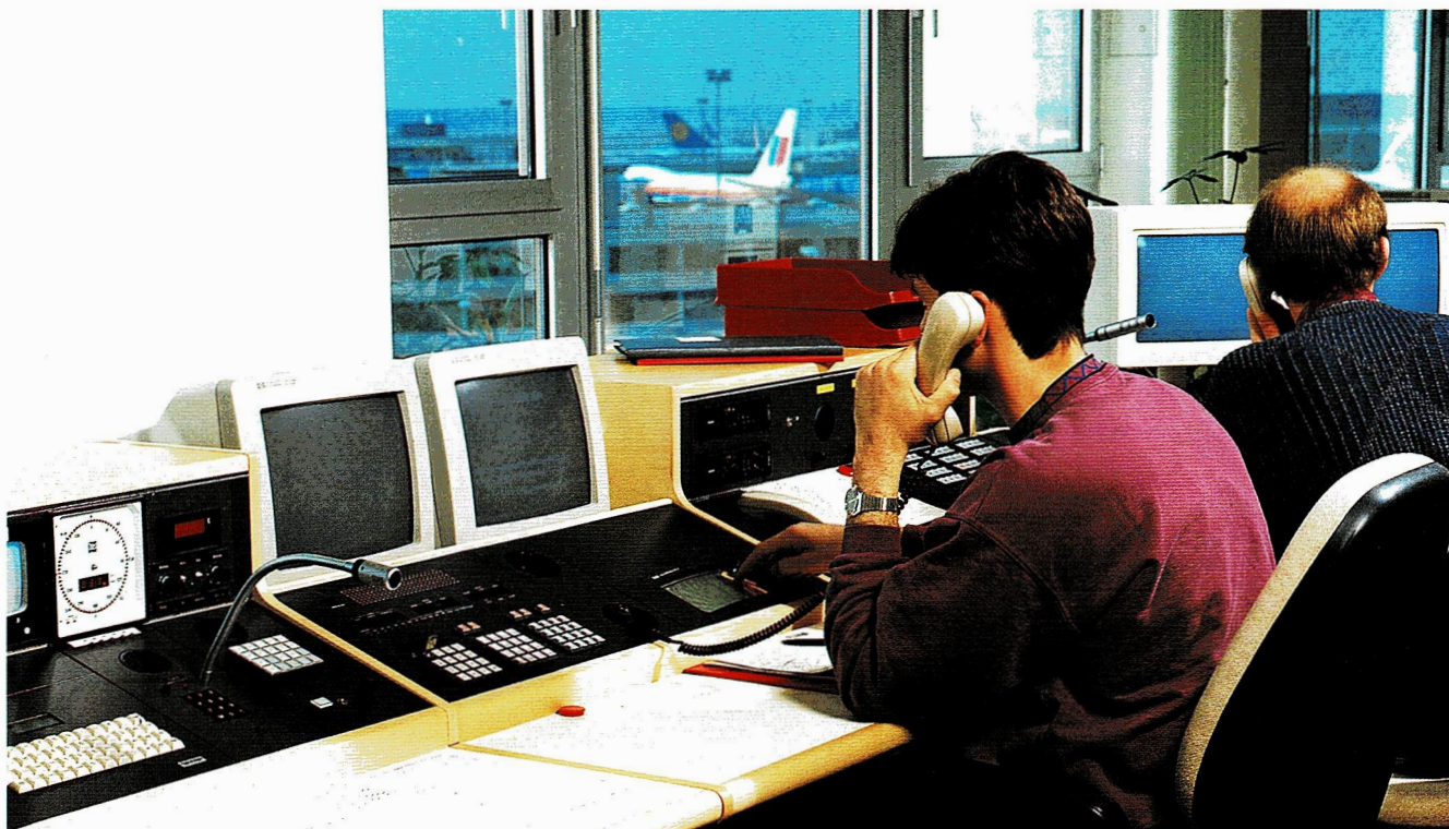
Bild 1 Elektronische Brandmeldeanlage auf dem Rhein-Main-Flughafen
